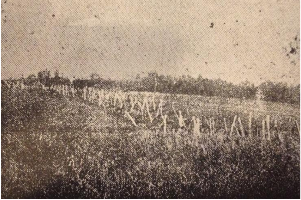
Şekil 2.27. (Açık renkli kayın ağacından yapılmış kazıklardan müteşekkil bir tel mâni'in karadan alınmış fotoğrafıdır. Muhite ( yüksek çayırılık) uydurmak mümkün ve kolaydı.)
