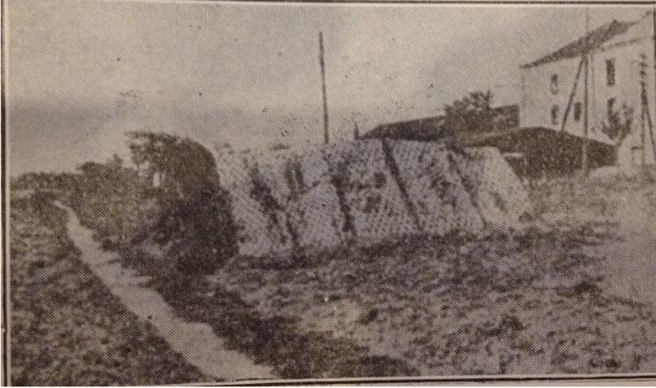
Şekil 2.13. Gizleme vesâiti olarak arazi rengine müşabih keten bez istimal edilmiştir. Bunun sandık şeklinde zeminden yüksek olarak inşâsı topu belli eder.
