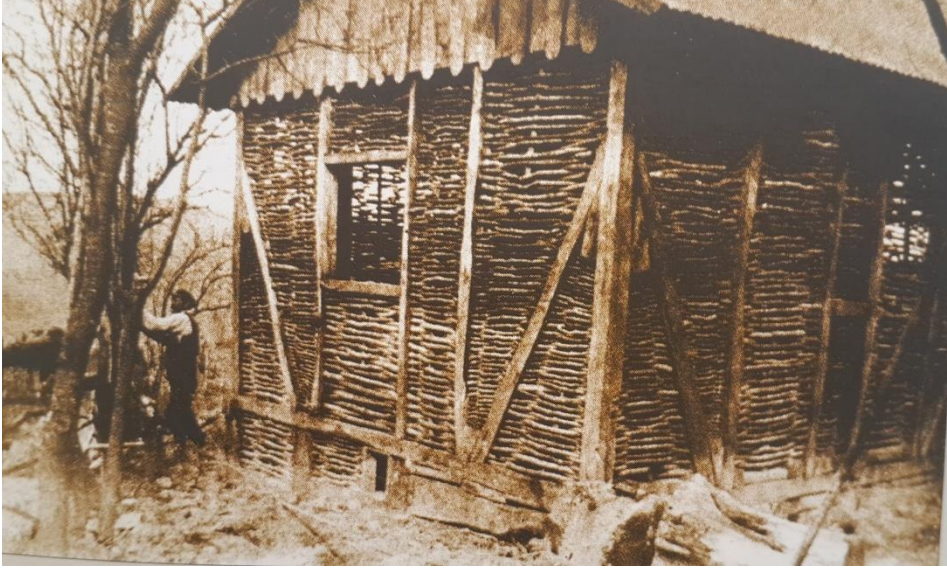
Resim 17: Adampol 'de ev inşasının ilk aşaması. Çalı çırpıdan yapılmış iskelete samanla karıştırılmış kil yapıştırılıyormuş ve üstü ille düzleniyormuş. 20 yüzyılın 20'li yılları
