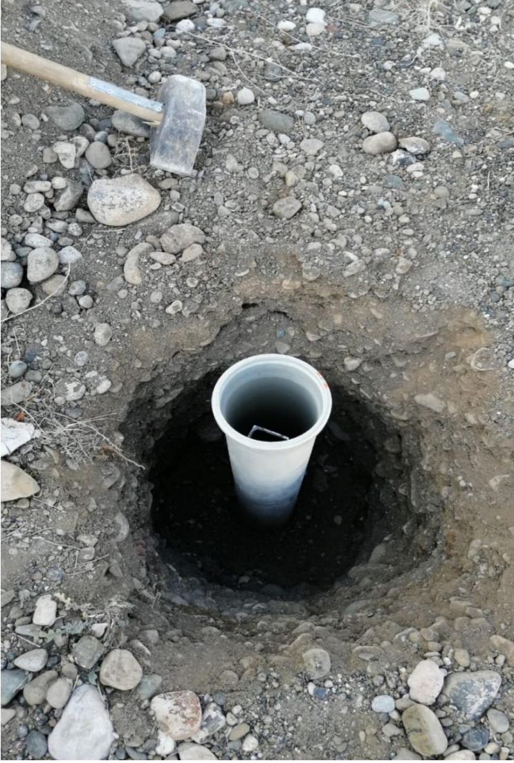
Resim 3.2. Topraklayıcının etrafına direnç düşürücünün kalıbının yerleştirilmesi
