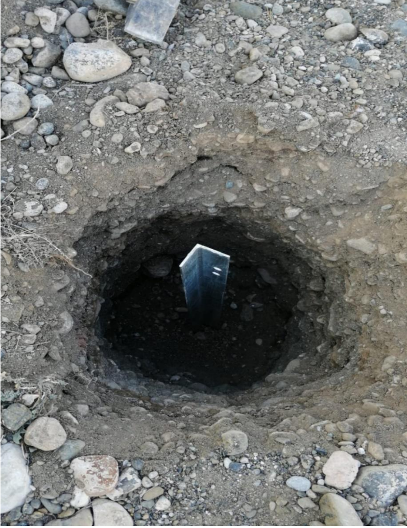
Resim 3.1. Topraklayıcının toprağa yerleştirilmesi
