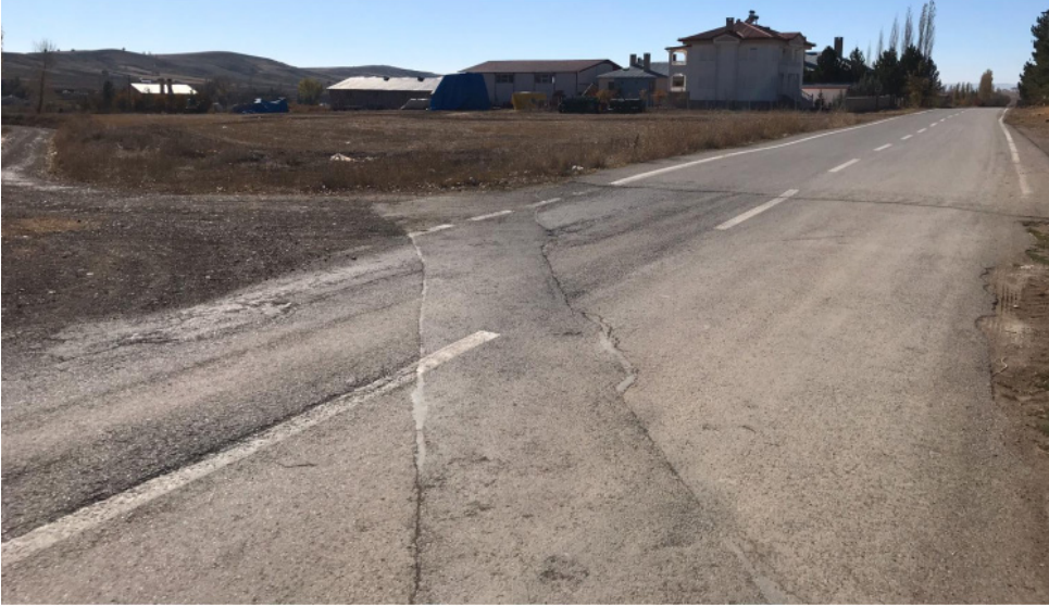
Şekil 6. Arazi ulaşımında kullanılan asfalt yol 72 . Sivas caddesi
