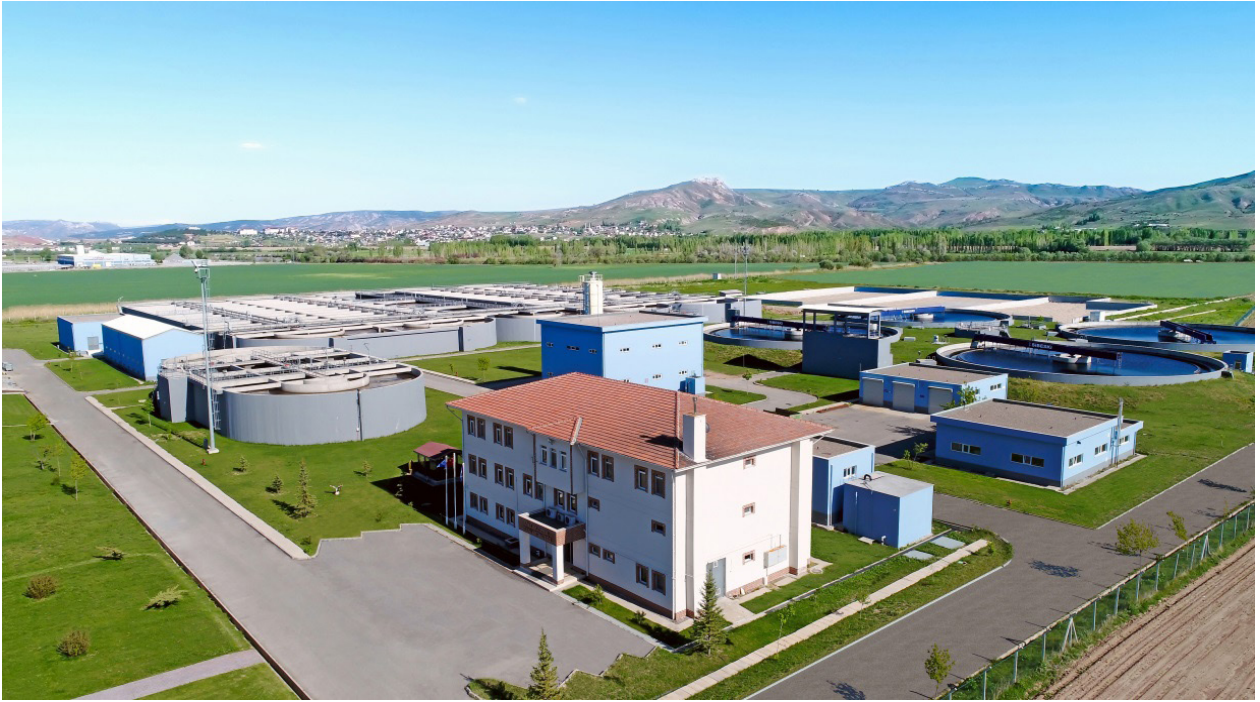
Şekil 2. Sivas AAT Genel Görünüş
