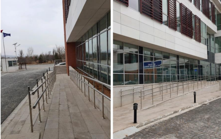
Şekil 2.2.8. Rampa –bina ana girişi-.
