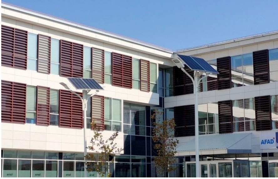
Şekil 2.1.6. Güneş enerji panelli aydınlatma direkleri
