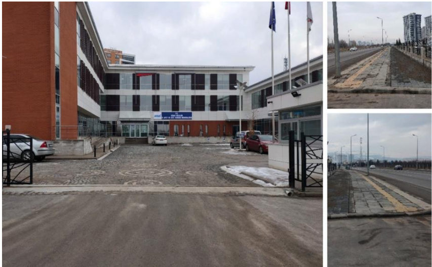
Şekil 2.2.12. Bina ana girişi ve bahçe.
