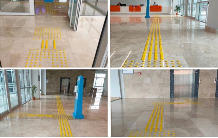
Şekil 2.2.9. Hissedilebilir yürüme yüzey işaretleri.
