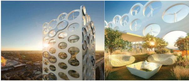
Şekil 5.13: Binaya entegre edilmiş rüzgâr türbinleri örneği: COR, Oppenheim Architects (Url-9).
