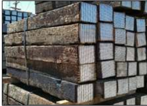
Şekil 10. Ahşap traverse sac plaka takviyesi
