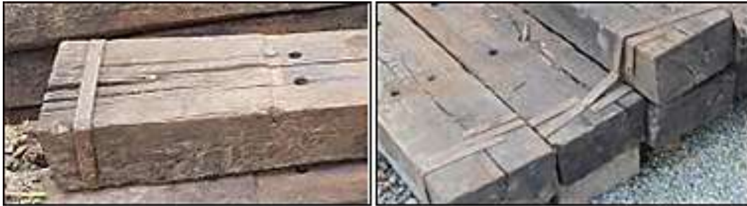
Şekil 7. Ahşap traverslerin çemberlenmesi
