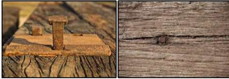
Şekil 9. Ahşap traverse bulon takviyesi
