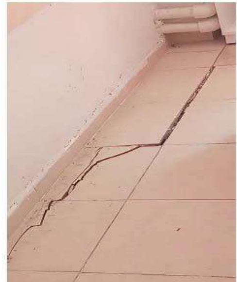
Şekil 2. Çalışma alanında görülen (a) Köşe Kolon altı yer hareketi (b) Seramik Kaplama Hasarı
