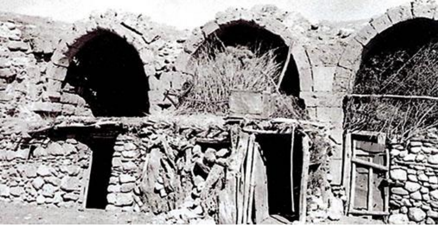
Fotoğraf 12: Avlunun kuzey kanadındaki revaklar (Güreşsever Cantay, 2016)
