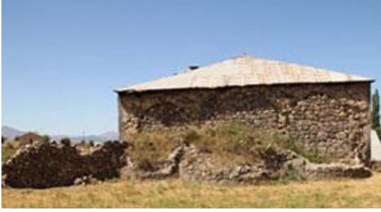
Fotoğraf 60 Kayadibi Köyü Kilisesi, Doğu Cephe
