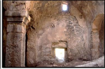
Fotoğraf 27 Düzyayla Kilisesi, Batı duvar
