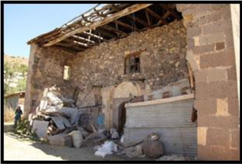
Fotoğraf 59 Kayadibi Köyü Kilisesi, Batı Cephe Kalıntıları ve Narteks
