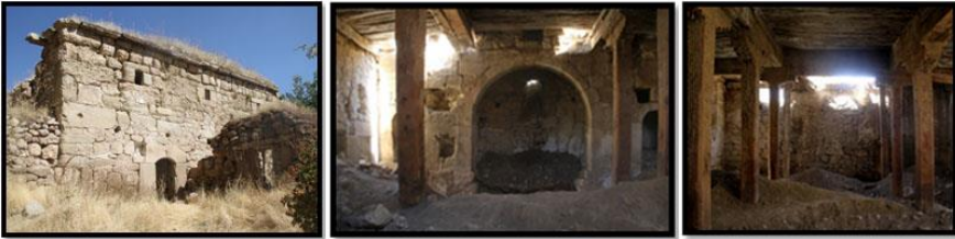
Fotoğraf 36-37-38 Günyamaç Kilisesi, Güney Cephe, Doğu Duvarı, Batı Duvarı
