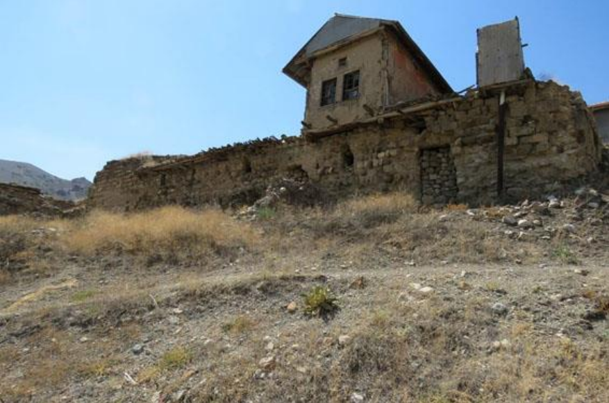
Fotoğraf 8: Burmahan Avlu Bölümü Doğu Cephesi (M. Kutlu Arşivi, 2018)
