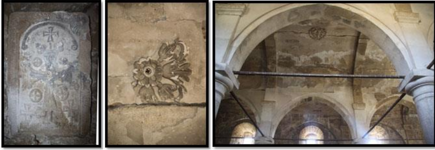
Fotoğraf 43-44-45 Tuzhisar Surp Garabed Kilisesi, Bezemeler
