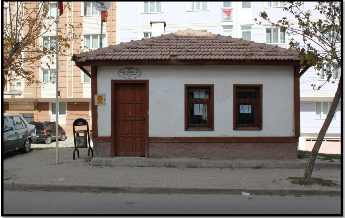
Resim -17 Fatih Mahallesi Muhtarlık Binası
