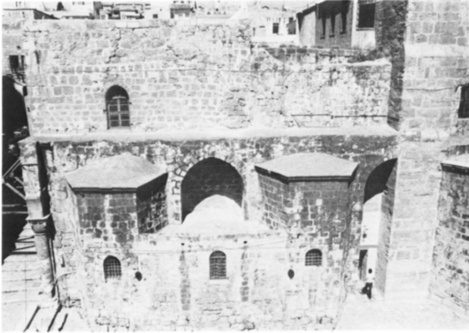
Foto 21: Kudüs. Kutsal Mezar Kilisesi, Vaftiz Kanadı, Doğu Cephe (Ousterhout 1989: 74).
