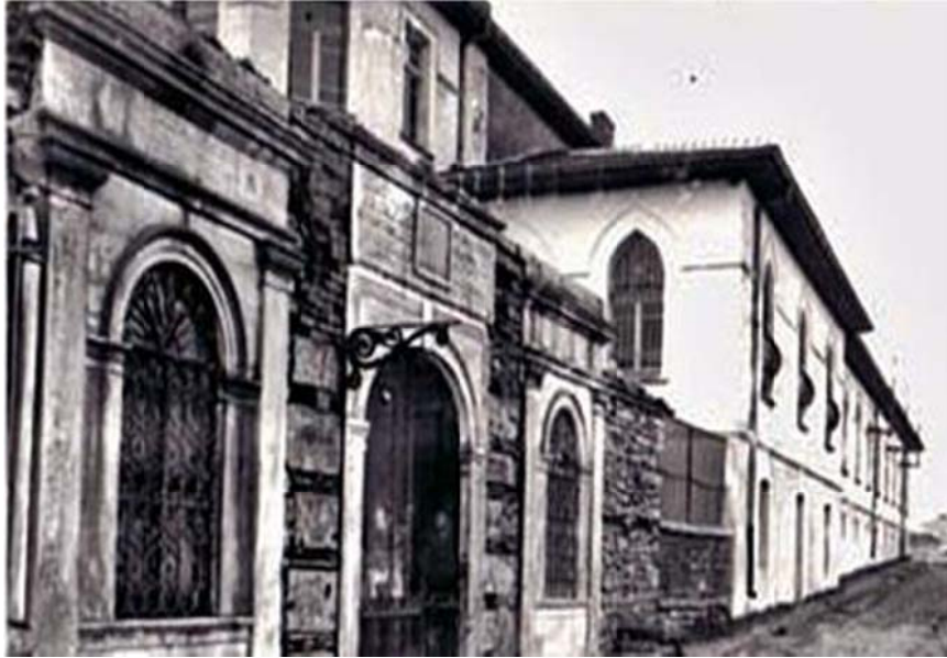
Resim: 3. Yenikapı Mevlevîhânesinin eski hali.
