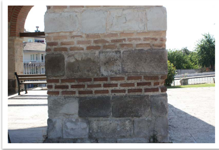
Fotoğraf 38: Taşıyıcı Ayaktaki Almaşık Örgü Tekniği
