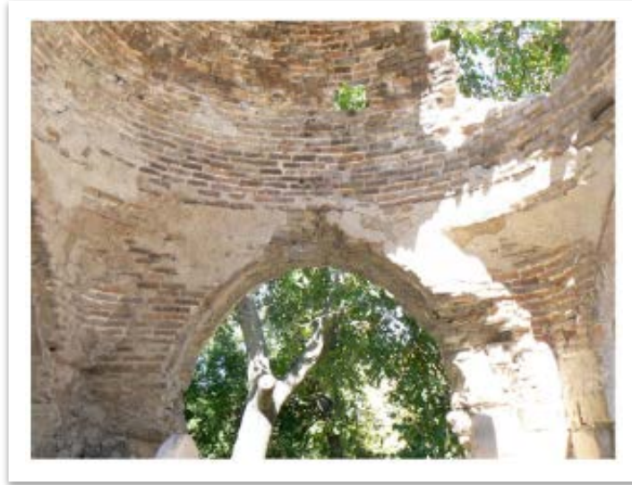
Fotoğraf 42: Nefise Hatun Türbesi Restorasyon Öncesi Kubbe İçi Görünüm (MVBM 2006)
