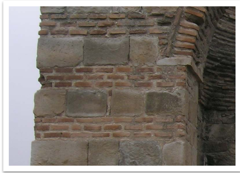
Fotoğraf 29: Restorasyon Öncesi Taşıyıcı Ayak (MVBM 2004)
