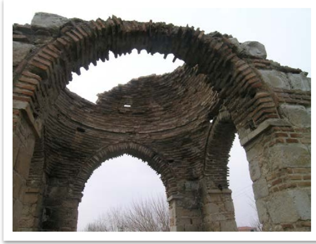
Fotoğraf 30: Kanlı Kümbet'in Onarım Öncesi İçten Kubbe Görünümü (MVBM 2004)
