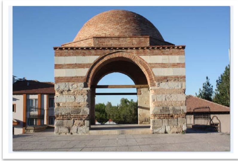
Fotoğraf 31: Restorasyon Sonrası Kubbe ve Sekizgen Kasnak
