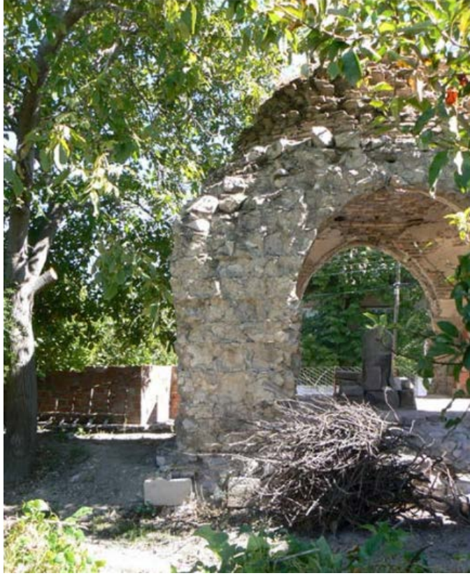
Fotoğraf 40 : Restorasyon Öncesi Güneydoğu Köşesi (MVBM 2006)
