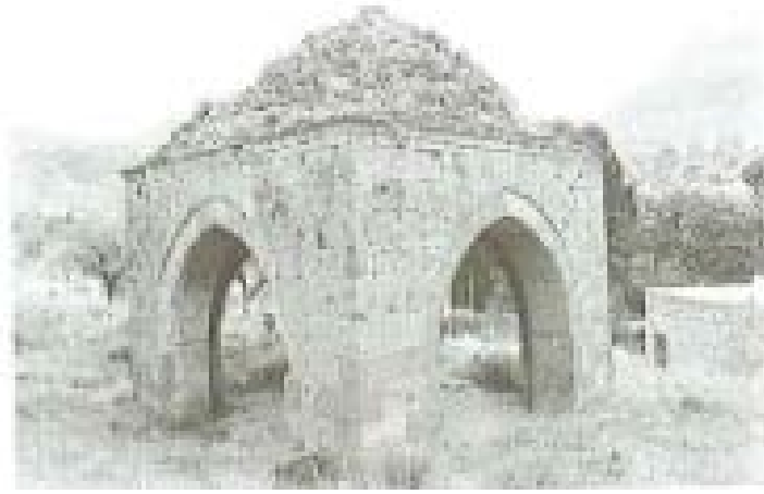
Fotoğraf 99: Ürgüp Damsa Köyü Kesikbaş Türbesi (Kılıcı 2007)
