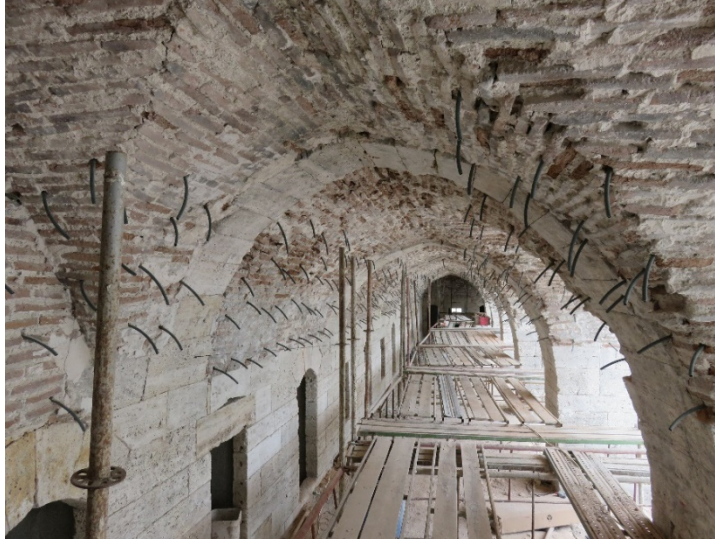
Fotoğraf 195: 1.kat kuzeybatı revaka enjeksiyon uygulaması
