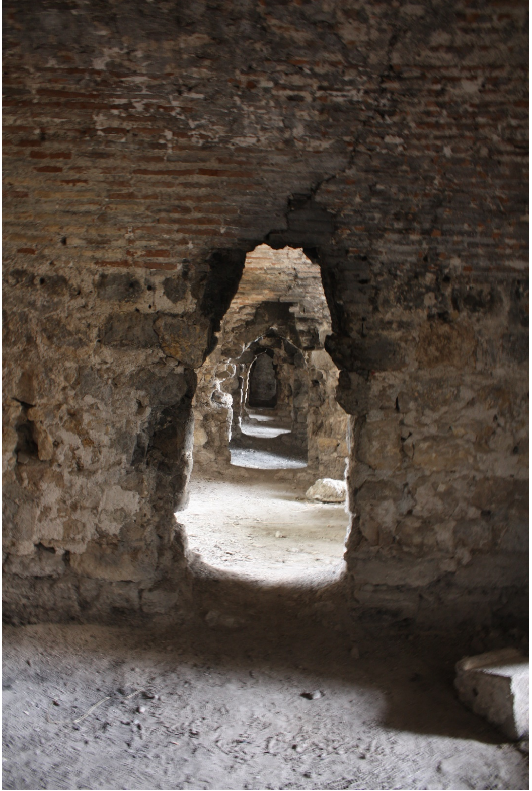
Fotoğraf 82: Ocak bölümlerinin yıkılarak odalar arası geçiş sağlanması. Geçişlerdeki islerden bu bölümlerin ocak nişi olduğunu anlıyoruz
