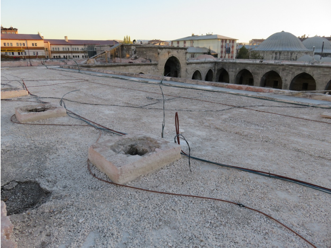
Fotoğraf 275: Ponza taşlarının üzerine sulandırılmış hidrolik kireç dökülmesi
