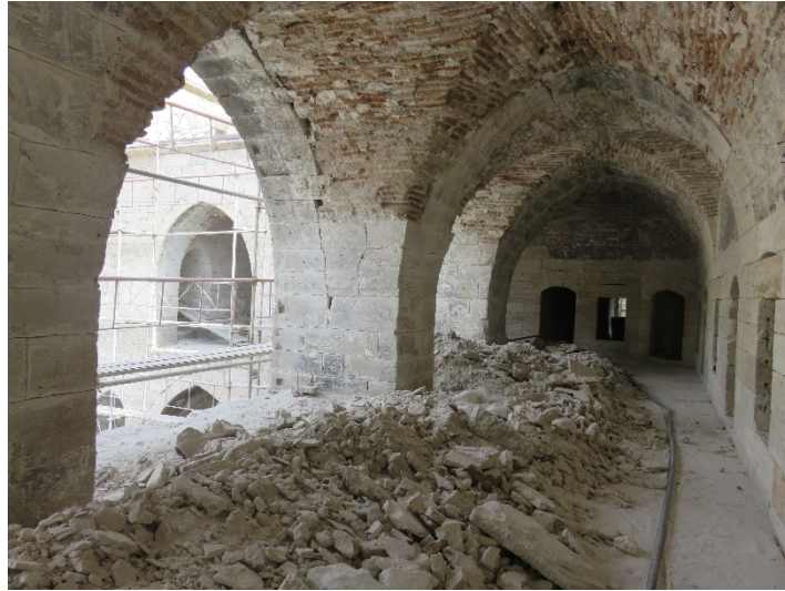
Fotoğraf 221: Güneybatı revakındaki odalardan ve revaktan arındırılan beton
