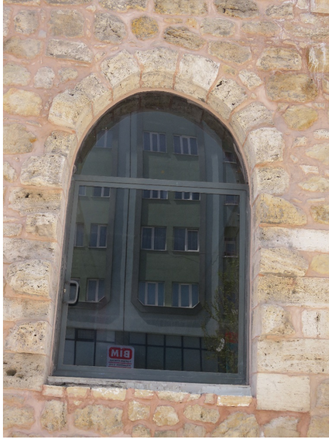
Fotoğraf 169: Hanın kuzeydoğu dış cephesindeki açıklığın camekanlı kapı ile kapatılması
