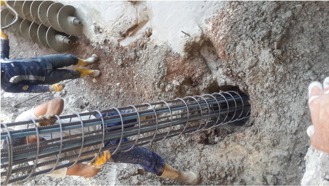
Fotoğraf 132: Hanın, iç avlusunda fore kazık uygulamasının denenmesi
