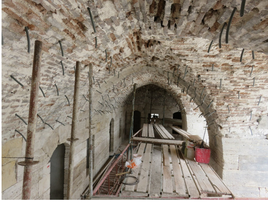
Fotoğraf 196: 1.kat kuzeybatı revaka enjeksiyon uygulaması
