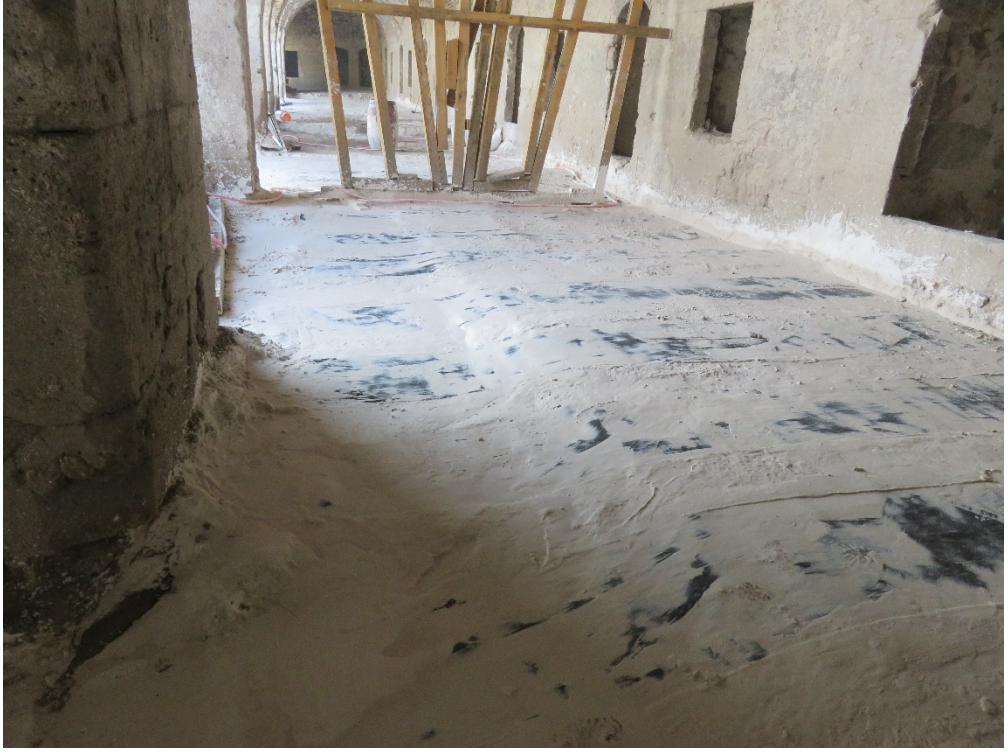
Fotoğraf 200: 1.kat kuzeybatı revaka fiber karbon kumaş uygulamasının yapılması
