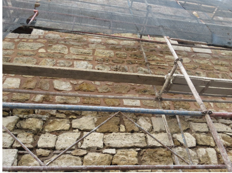
Fotoğraf 245: Kuzeydoğu cephesi derz yapımı
