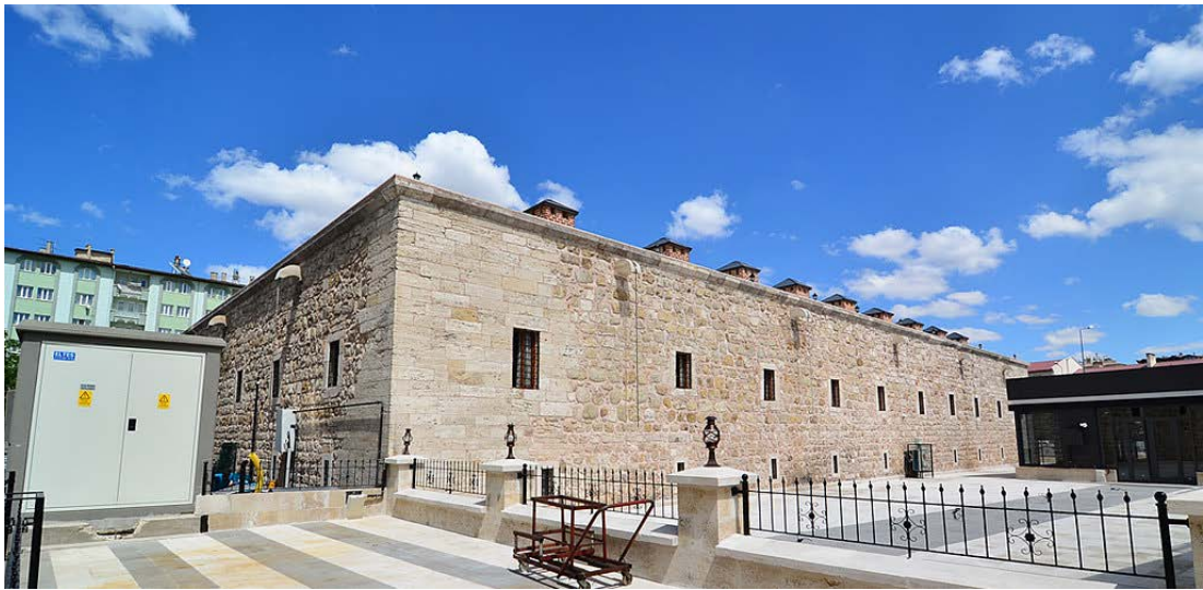
Fotoğraf 298: Güneybatı cephede silme tamirâtı
