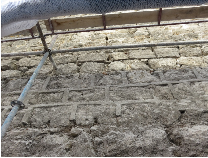
Fotoğraf 244: Kuzeybatı cephesi çimento esaslı derzlerin sökülmesi
