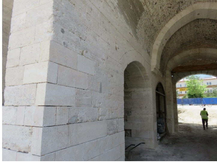
Fotoğraf 227: Hanın giriş bölümündeki güneybatı taraf taşıyıcılarda taş yenilenmesi
