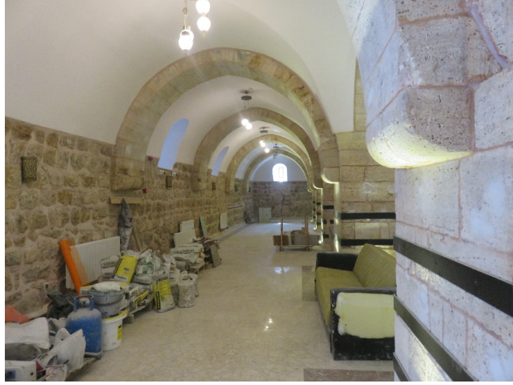
Fotoğraf 189: Yapının ahır bölümünde kullanılan cilalı traverten kaplaması
