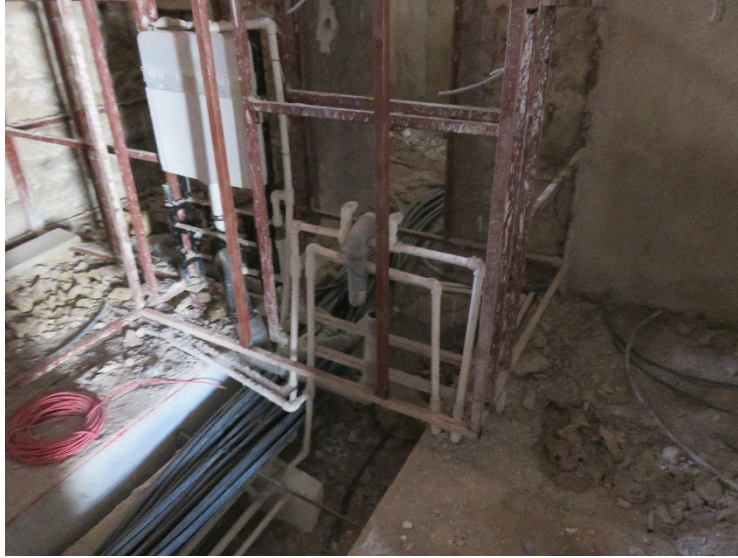
Fotoğraf 161: Zemin kat odalarda kanal açma ve tesisat borularını ekleme çalışmaları
