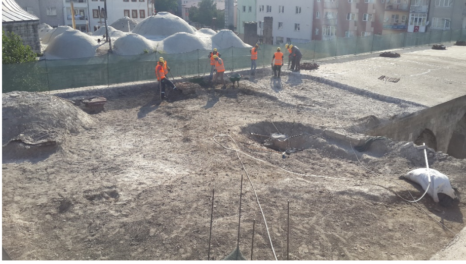
Fotoğraf 265: Mozaik döşemenin el aletleriyle kaldırılması
