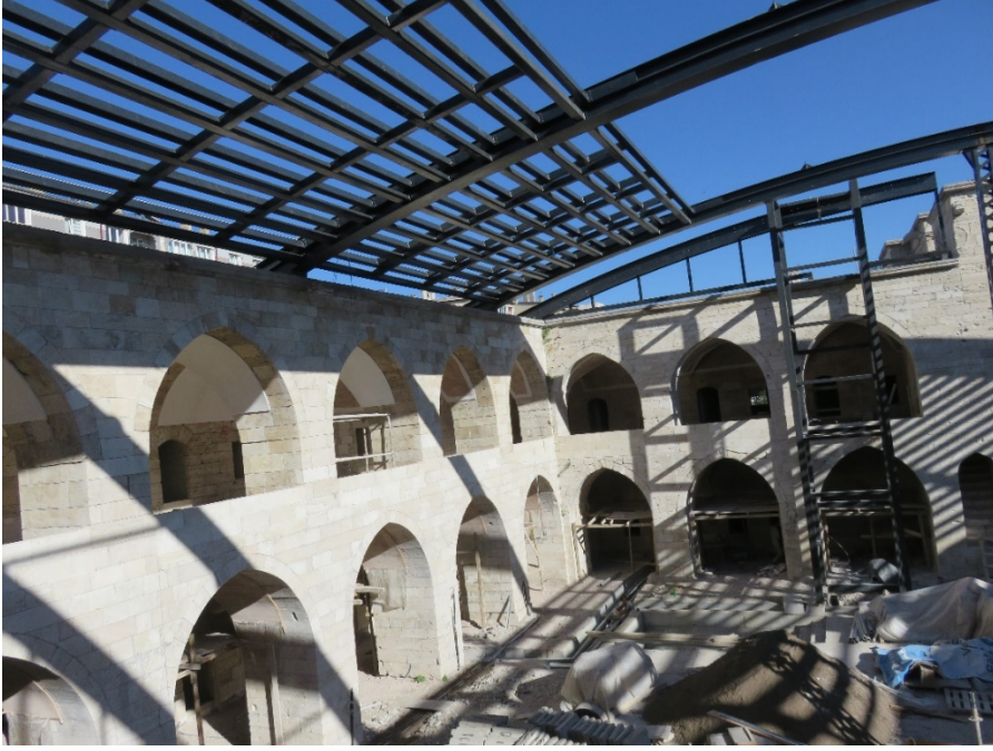
Fotoğraf 288: Behram Paşa Hanı açılır-kapanır çelik örtüsü
