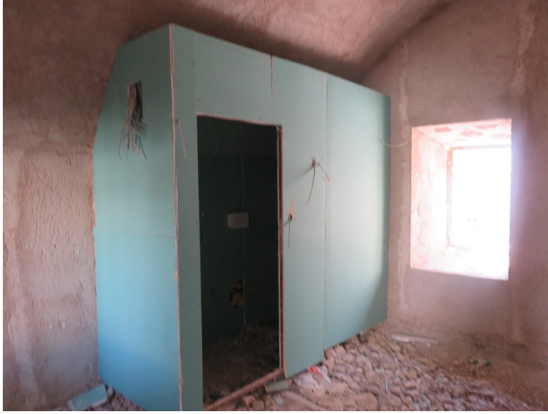
Fotoğraf 128: Odaların içlerine yeşil alçıpan ile duvar yapılması
