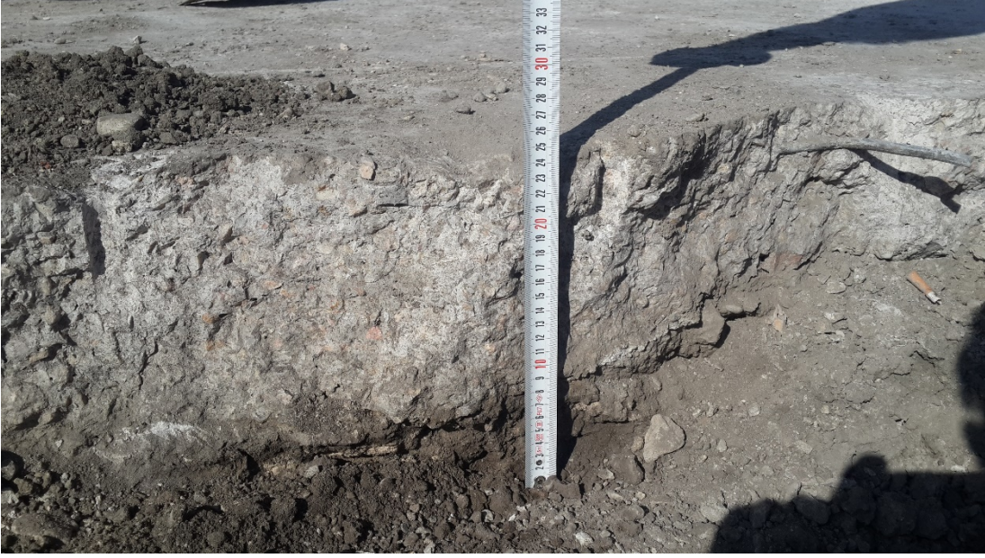
Fotoğraf 267: Mozaik döşemenin el aletleriyle kaldırılması
