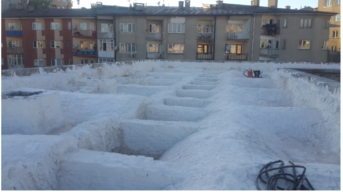
Fotoğraf 272: Hidrolik kireç harcının tonoz üstlerine dökülmesi ve karbon kumaş uygulaması
