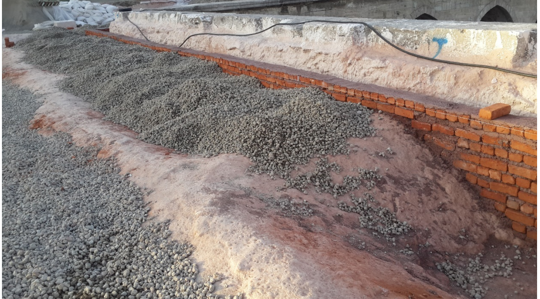
Fotoğraf 291: Harman tuğlasıyla örülen duvar, hatlın alt yapısı
