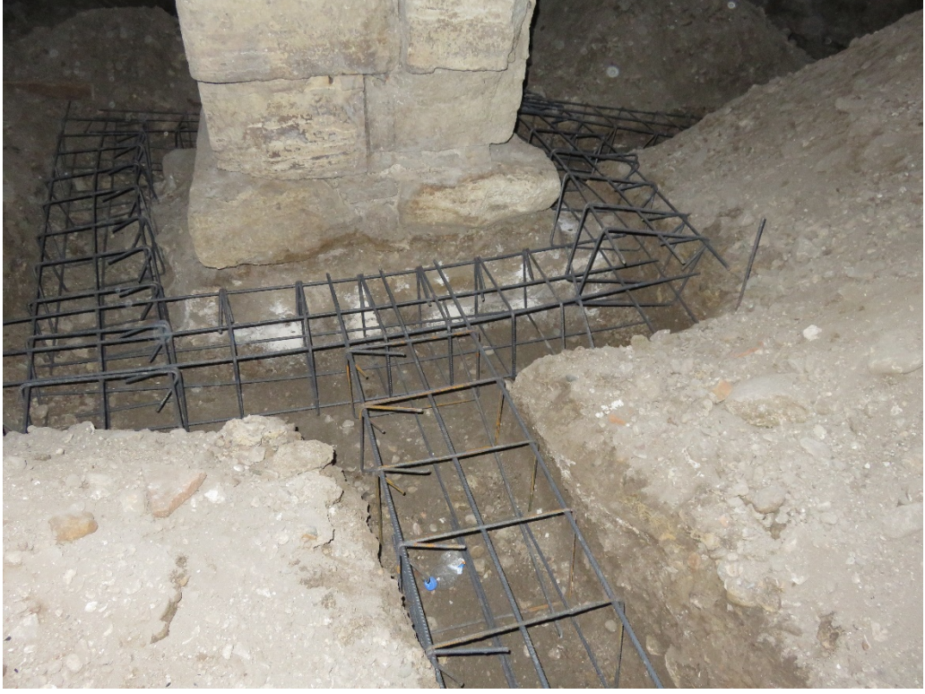
Fotoğraf 122: Hanın ahır bölümünde kanallara demirlerin yerleştirilmesi
