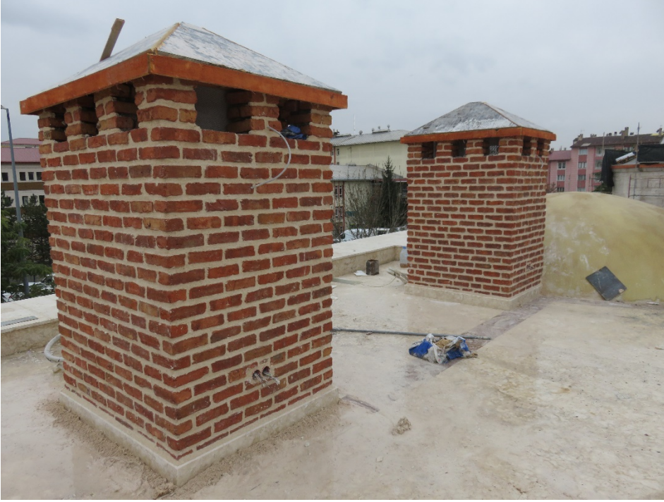
Fotoğraf 299: Örtüde baca yapılması
