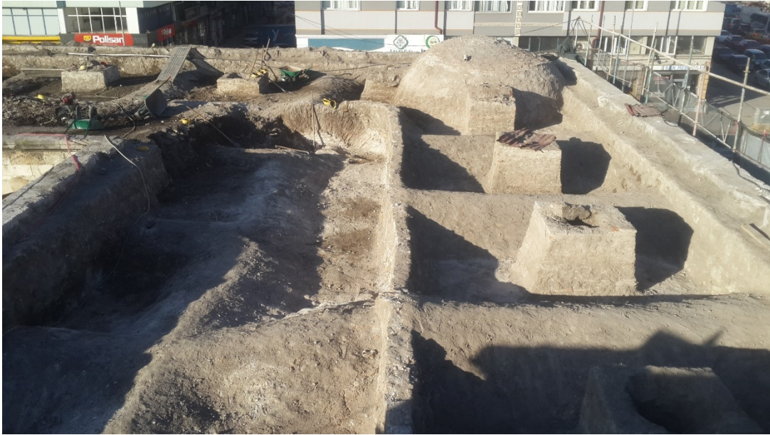
Fotoğraf 55: Behram Paşa Hanı'nın örtüsünde yer alan baca temelleri
