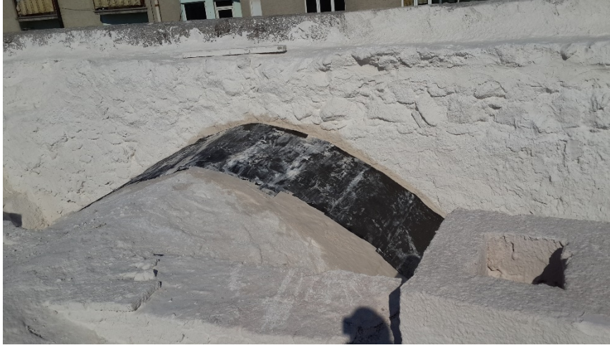
Fotoğraf 198: Örtüdeki çatlayan tonozun fiber karbon kumaş ile güçlendirilmesi
