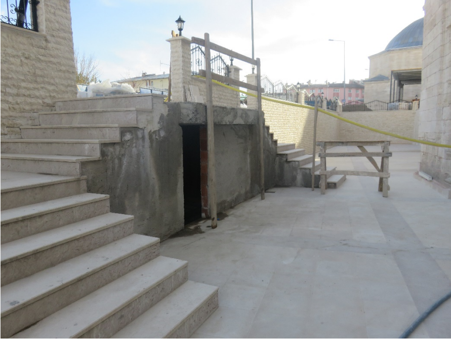
Fotoğraf 191: Yapının güneydoğu cephesinde uygulanan cilalı traverten taş kaplaması
