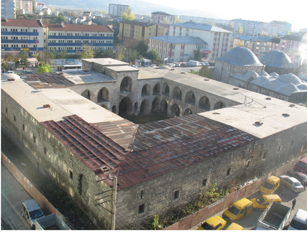
Fotoğraf 65: Behram Paşa Hanı kuzeybatı ve güneydoğu cephesi
