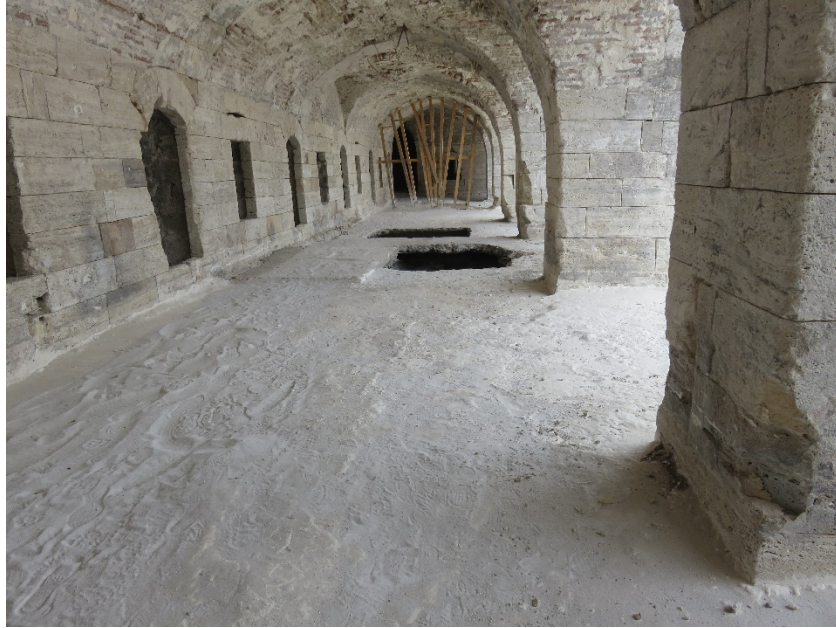
Fotoğraf 213: 1.kat kuzeybatı revakı, ahır bölümünden beton tavan sökümü
