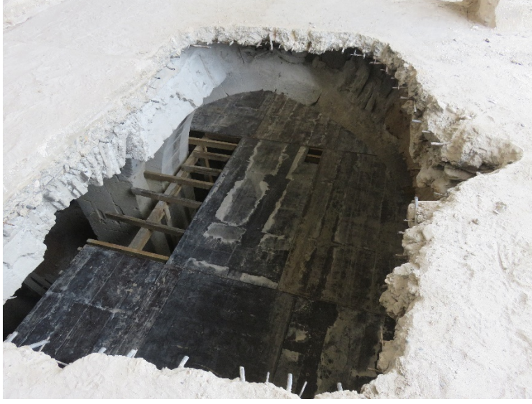
Fotoğraf 214: Ahır bölümünden beton tavan sökümü
