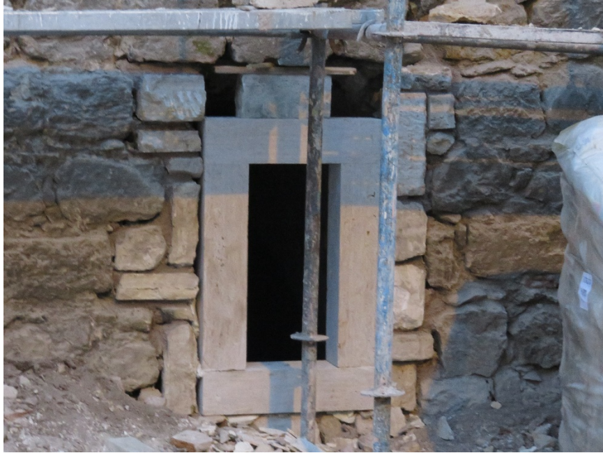
Fotoğraf 239: Mazgal pencere şebekesinin dışarıdan örülmesi ve söve yapımı
