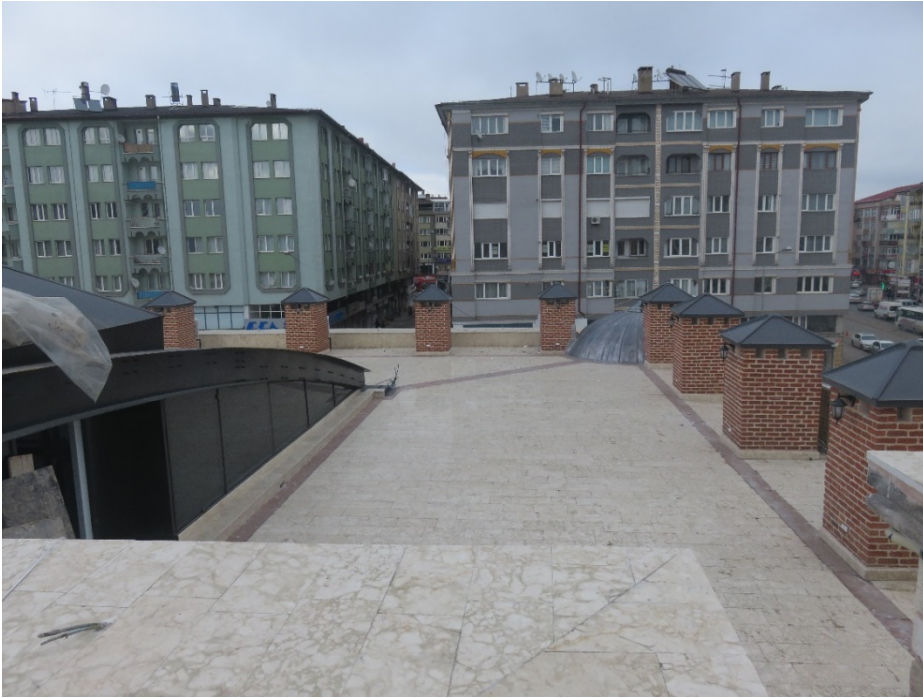
Fotoğraf 192: Örtünün cilalı traverten ile kaplanması
