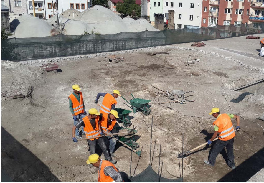
Fotoğraf 266: Mozaik döşemenin el aletleriyle kaldırılması
