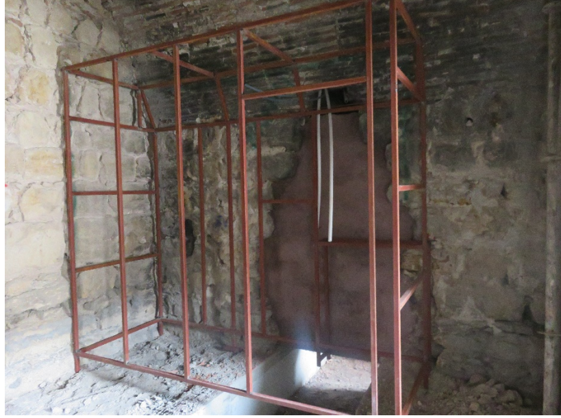
Fotoğraf 141: Baca boşluklarından tesisat borularının geçirilmesi
