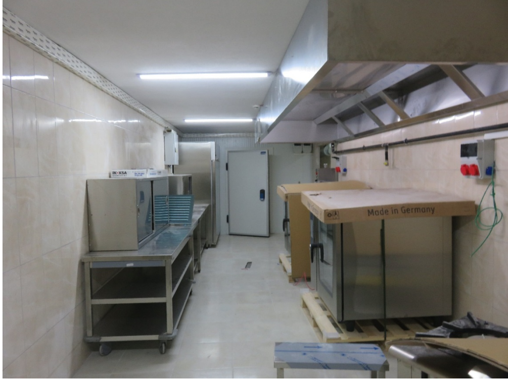
Fotoğraf 151: Hanın kuzeybatısına yapılan eklenti binanın içerisi mutfak bölümü
