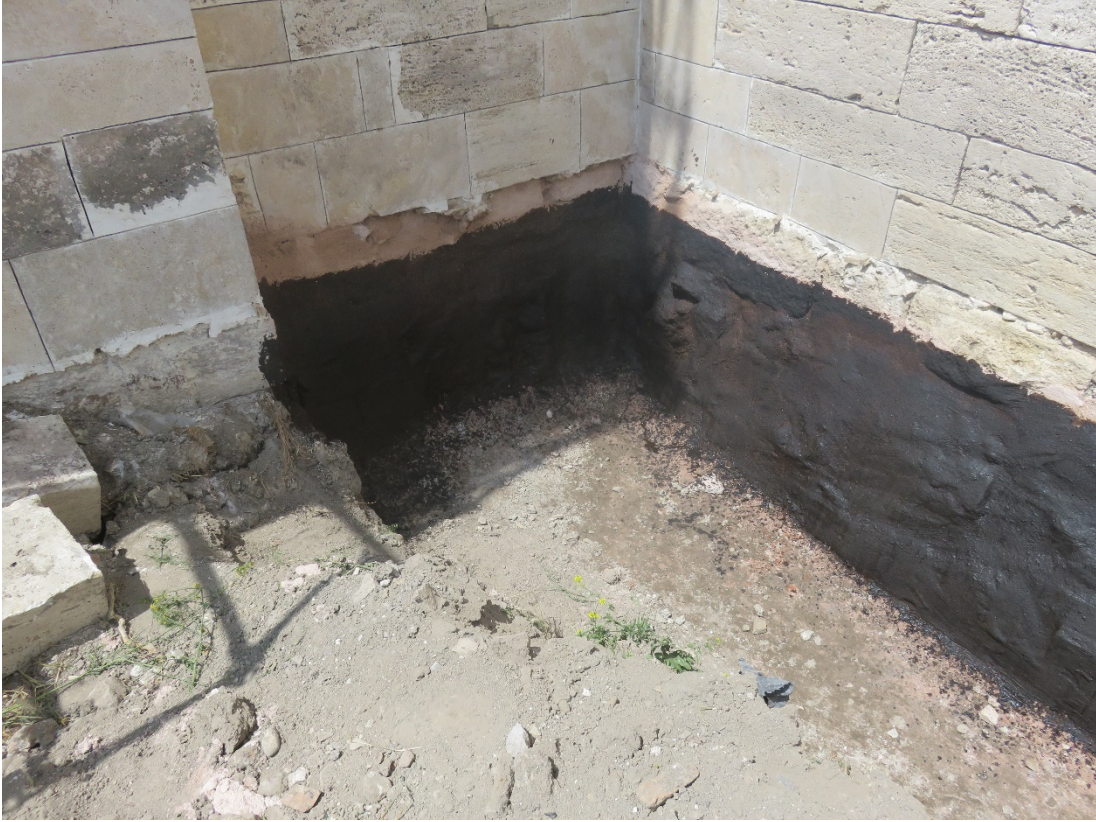
Fotoğraf 229: Behram Paşa Hamı güneydoğu cephesi drenaj çukurunun açılması ve temel taşlarına yalıtım malzemesi sürülmesi
