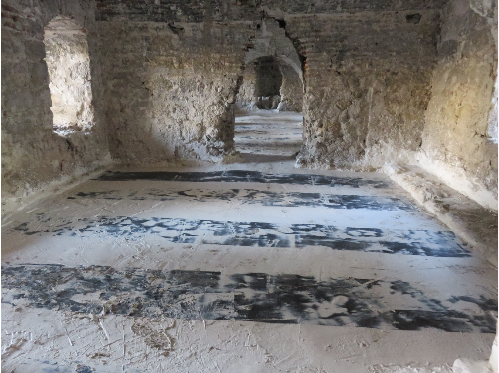
Fotoğraf 201: 1.kat kuzeybatı odalara fiber karbon kumaş uygulamasının yapılması
