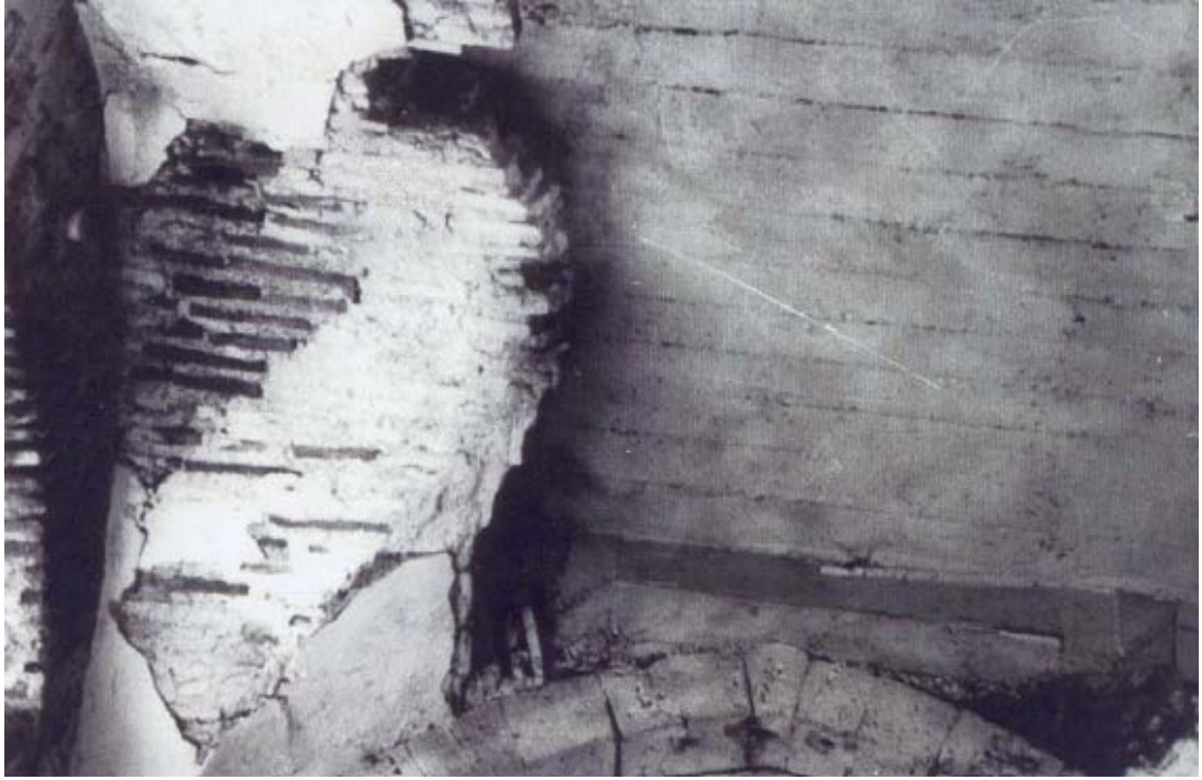
Fotoğraf 26: Hanın ahır girişindeki yıkık tonoz üzerinde yer alan betonarme döşeme / S.V.B.M.F.A.
