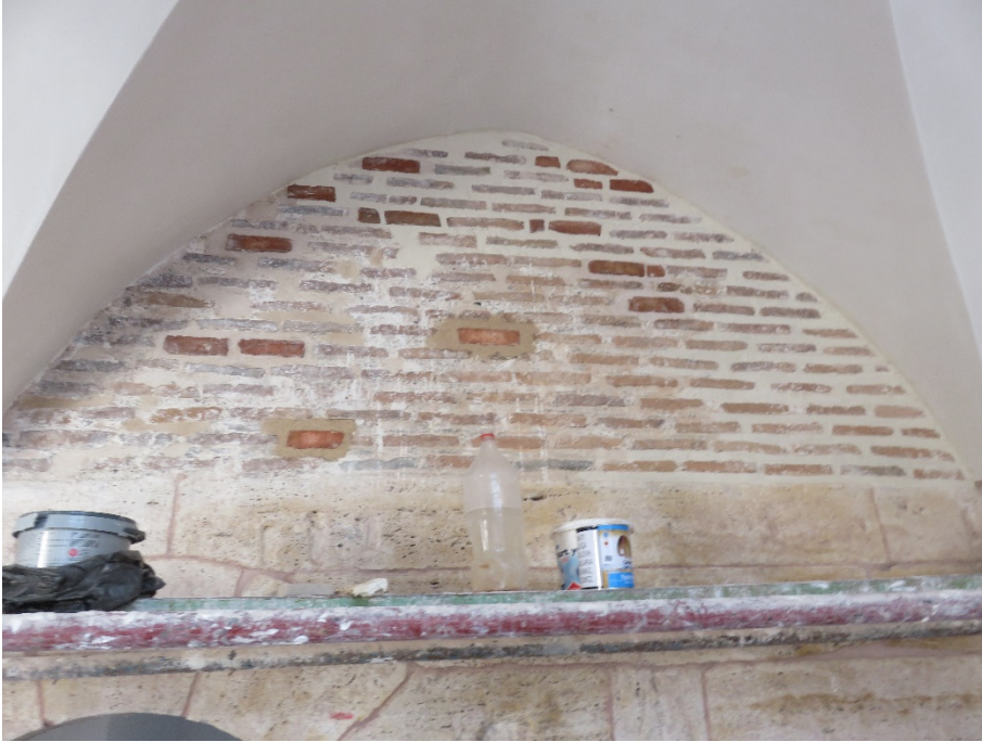
Fotoğraf 254: Harman tuğlaların kırılmış yüzeylerine uygulanan işlem detayı
