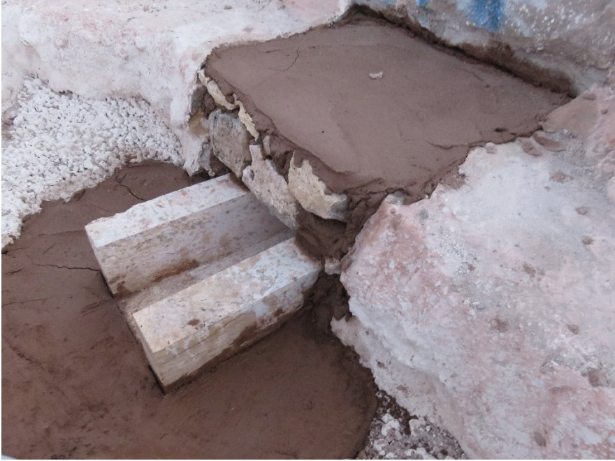
Fotoğraf 296: Örtüde çörten yerleştirilmesi ve üzerinin taşla örülmesi
