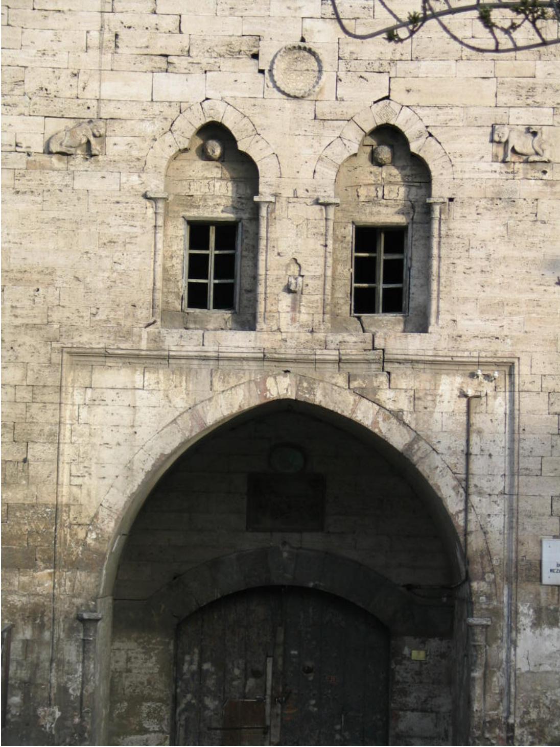
Fotoğraf 89: Behram Paşa Hanı'nın ana giriş cephesi olan güneydoğu cephesi
