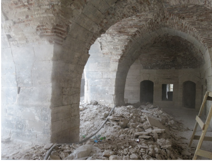
Fotoğraf 222: Kuzeybatı revakta betondan arındırma işlemi
