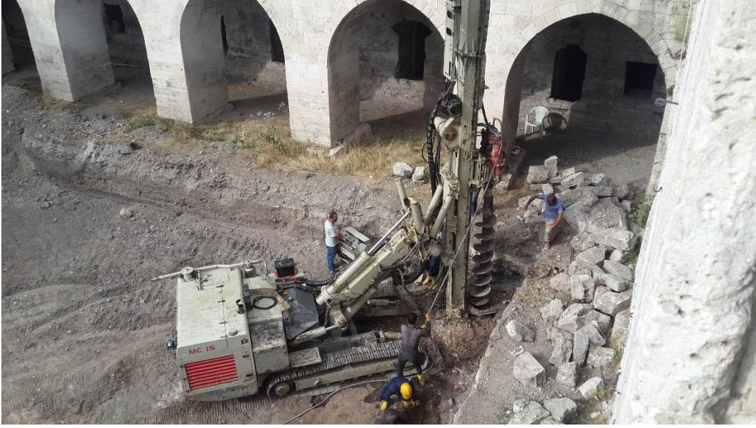
Fotoğraf 131: Hanın, iç avlusunda fore kazık uygulamasının denenmesi
