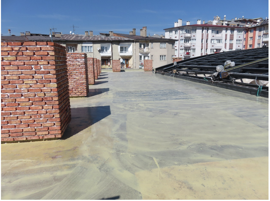
Fotoğraf 280: Örtü bölümü su yalıtım uygulaması
