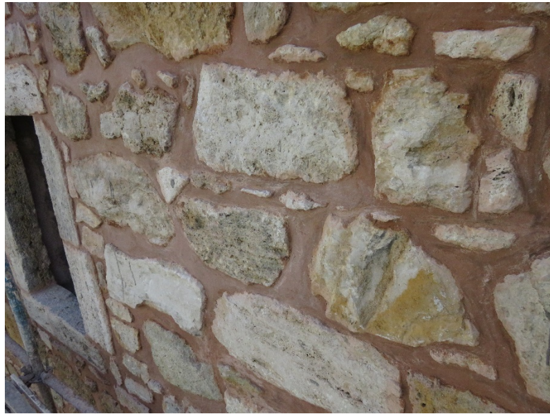
Fotoğraf 246: Kuzeydoğu cephesi yapılan derz detayı
