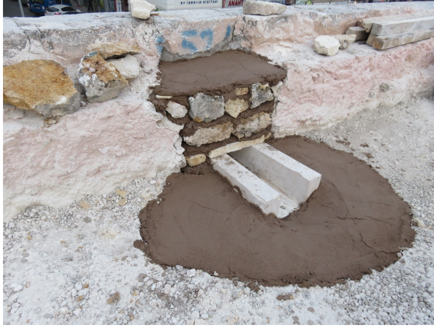
Fotoğraf 297: Örtüde çörlen yerleştirilmesi ve üzerinin taşla örülmesi
