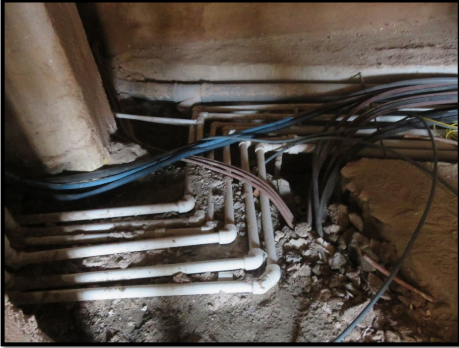
Fotoğraf 188: Tesisatların zemin kaplamasının altından geçirilmesi
