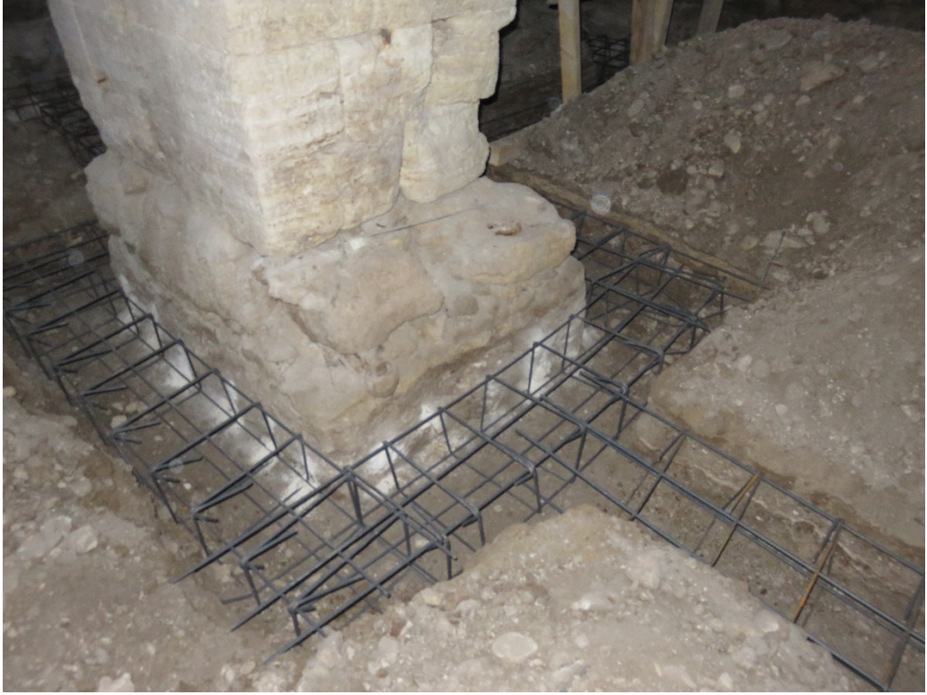
Fotoğraf 123: Hanın ahır bölümünde kanallara demirlerin yerleştirilmesi
