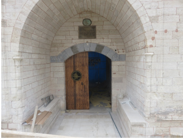
Fotoğraf 164: Hanın ana giriş ahşap kapı kanatları
