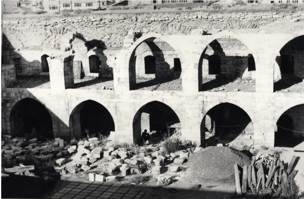
Fotoğraf 69: Behram Paşa Hanı kuzeydoğu cephesi, 1980 yılı restorasyon öncesi görseli / S.V.B.M.F.A.
