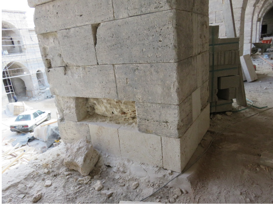
Fotoğraf 177: Yapının 1. kat kuzeybatı revakındaki taşıyıcı ayakların taş çürütme işlemleri
