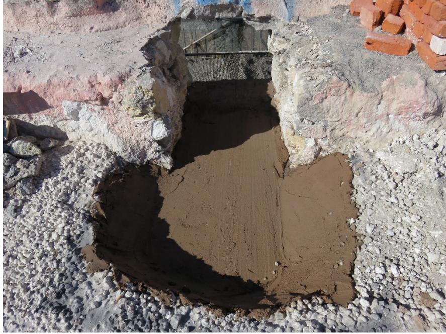
Fotoğraf 294: Çörten yerlerinin açılması ve çörtlenin oturtulacağı yerin hazırlanması
