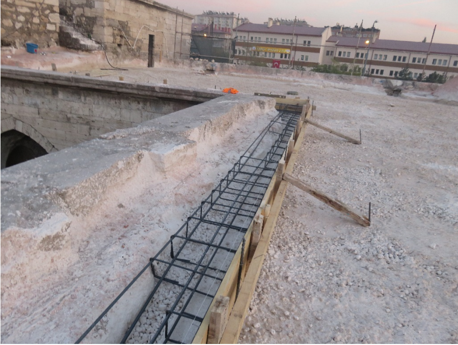
Fotoğraf 293: Örtüye hatıl yapılması ve demirlerin yerleştirilmesi
