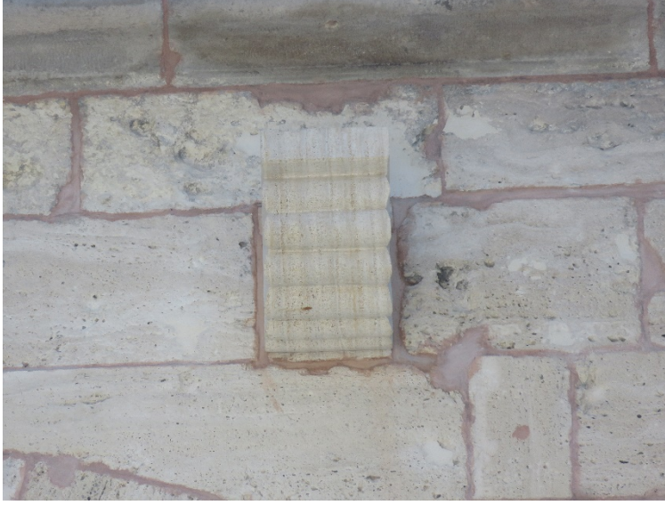
Fotoğraf 248: Behram Paşa Hanı avlusu güneydoğu cephede derz yapılması
