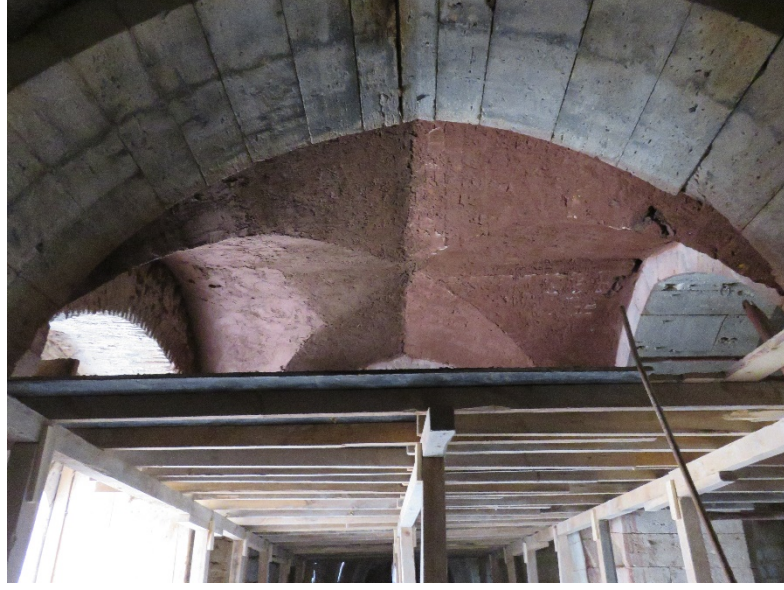
Fotoğraf 212: Haç tonozun örüldükten sonra horasan harcı ile sıvanmasına dair detay
