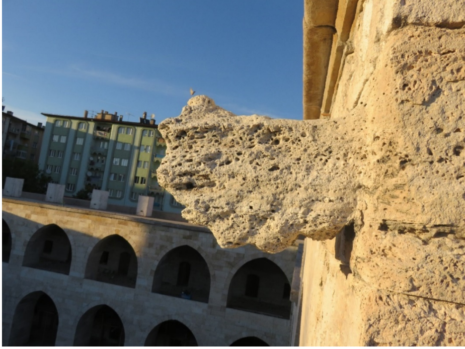
Fotoğraf 106: Behram Paşa Hanı güneydoğu avlu cephesindeki konsol detayı
