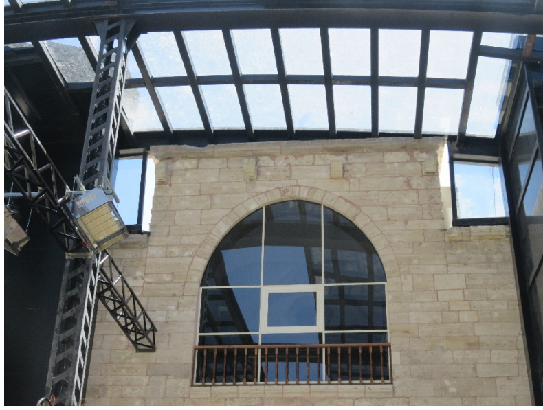
Fotoğraf 168: Hanın kemerli açıklıklarının cam ile kapatılması
