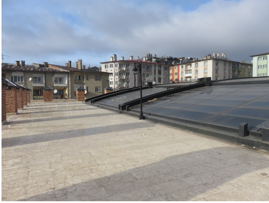
Fotoğraf 193: Örtünün cilalı traverten ile kaplanması
