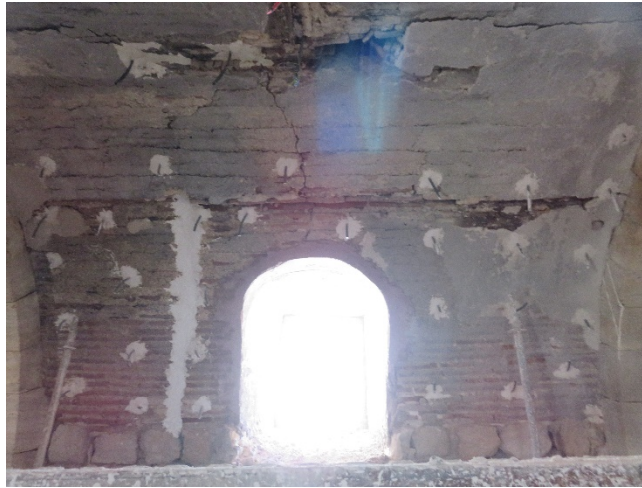
Fotoğraf 235: Yapının ahır bölümünün duvarlarına enjeksiyon işlemlerinin uygulanması
