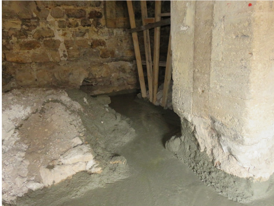
Fotoğraf 127: Hanın ahır bölümünde demir eklenen kanallara beton harcı dökülmesi
