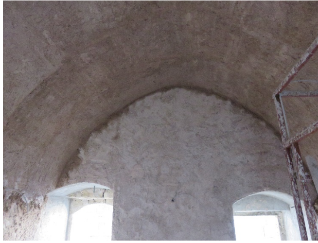
Fotoğraf 202: Horasan harcı ile sıvası yapılmış bir oda
