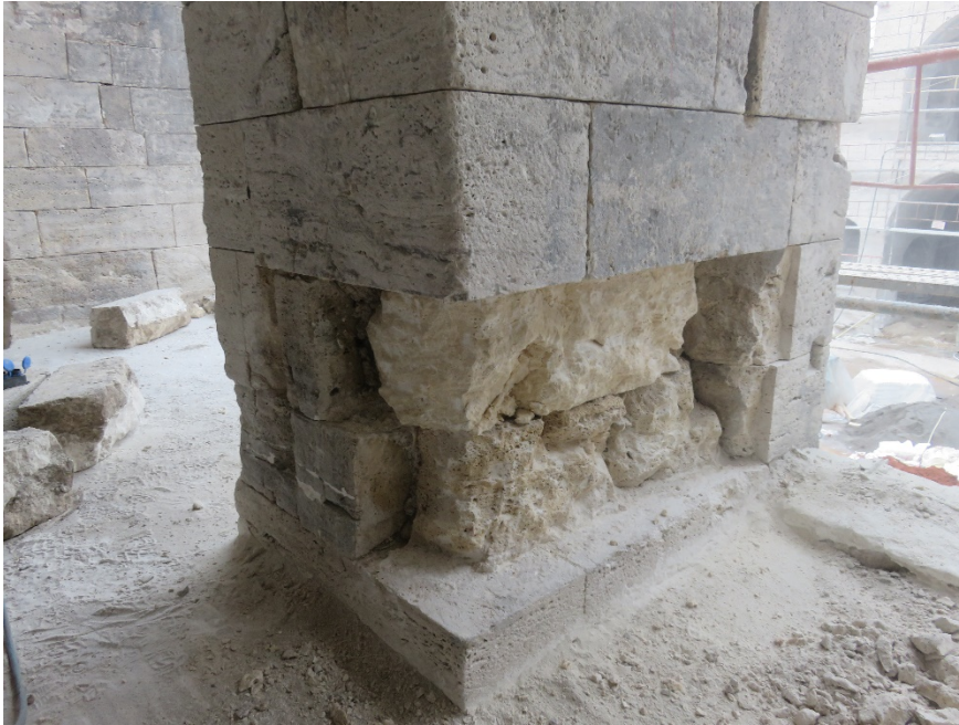
Fotoğraf 179: Yapının 1.kat kuzeydoğu revakındaki taşıyıcı ayakta taş çürütme işlemi yapılması
