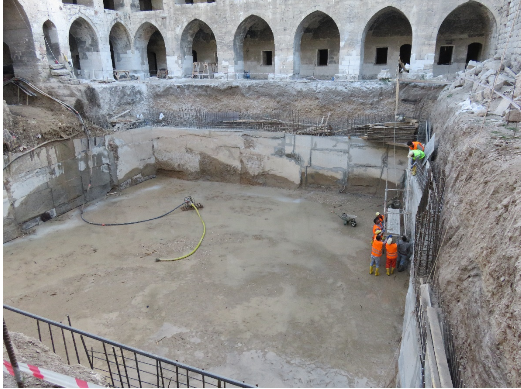
Fotoğraf 134: Hanın, bodrum katı dış beden duvarlarının yapılması
