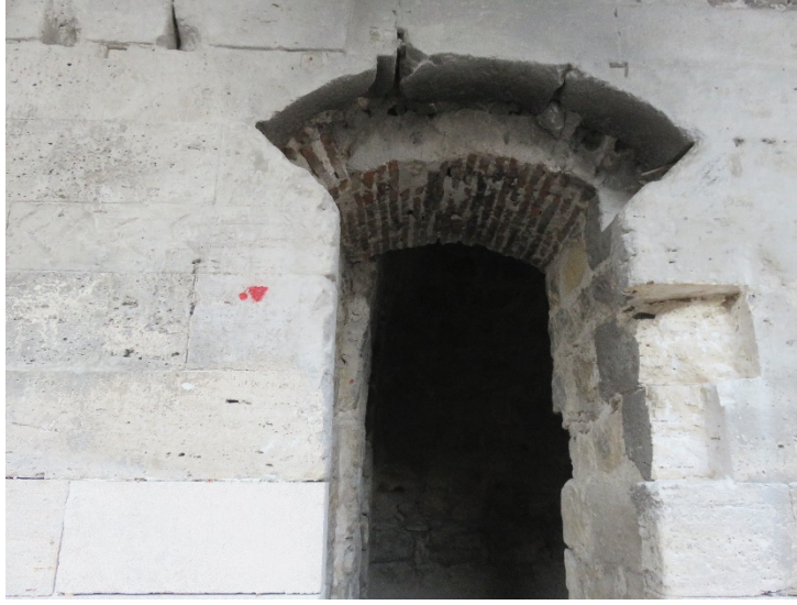
Fotoęraf 218: Basık kemerli oda giriřinin tař çürütme iřlemleri
