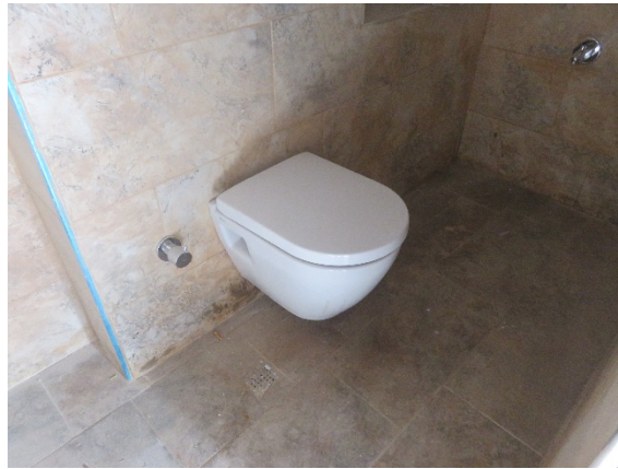
Fotoğraf 144: Alçıpan üzerine fayans yapılması
