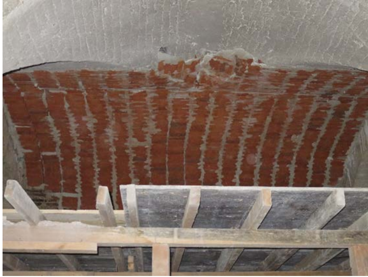
Fotoğraf 211: Yapının 1.kat kuzeybatısında yenilenen beşik tonoz
