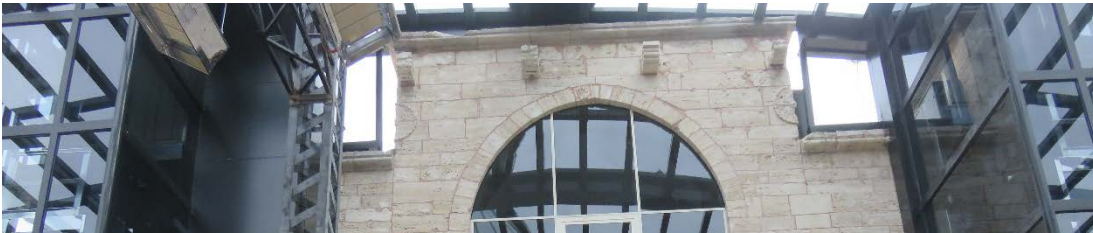
Fotoğraf 87: Güneydoğu cephesi han ağası odası saçığı
