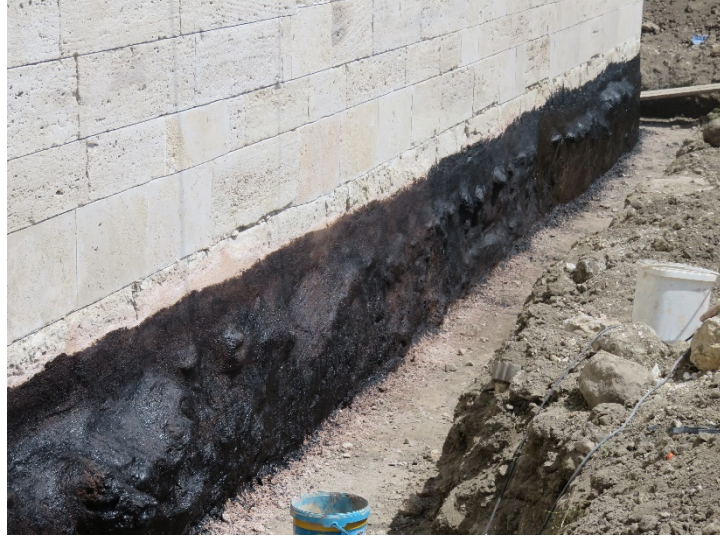
Fotoğraf 230: Behram Paşa Hanı güneydoğu cephesi drenaj çukurunun açılması ve temel taşlarına yalıtım malzemesi sürülmesi
