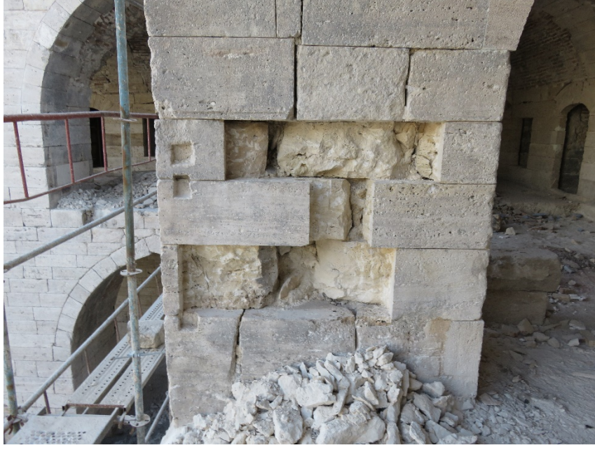
Fotoğraf 180: Yapının güneydoğu revakındaki taşıyıcı ayakta taş çürütme işlemlerinin yapılması
