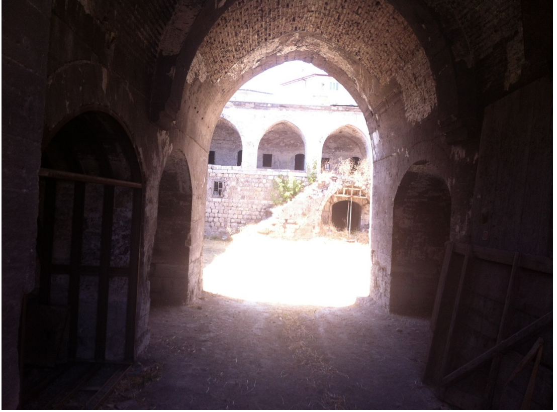
Fotoğraf 59: Destekleyici kemer
