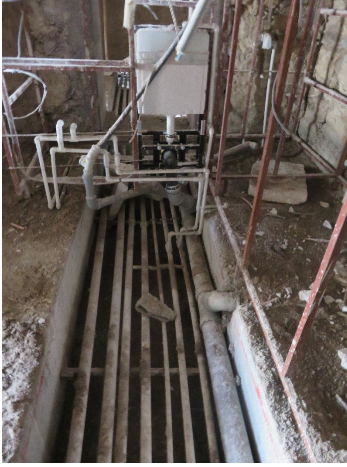
Fotoğraf 160: Zemin kat odalarda kanal açma ve tesisat borularını ekleme çalışmaları
