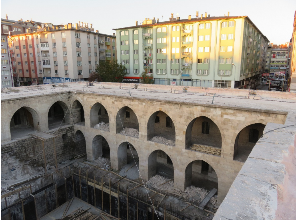
Fotoğraf 276: Ponza taşlarının üzerine sulandırılmış hidrolik kireç dökülmesi
