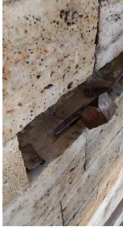
Fotoğraf 241: Eritilen kurşunun demir üstüne dökülmesi
