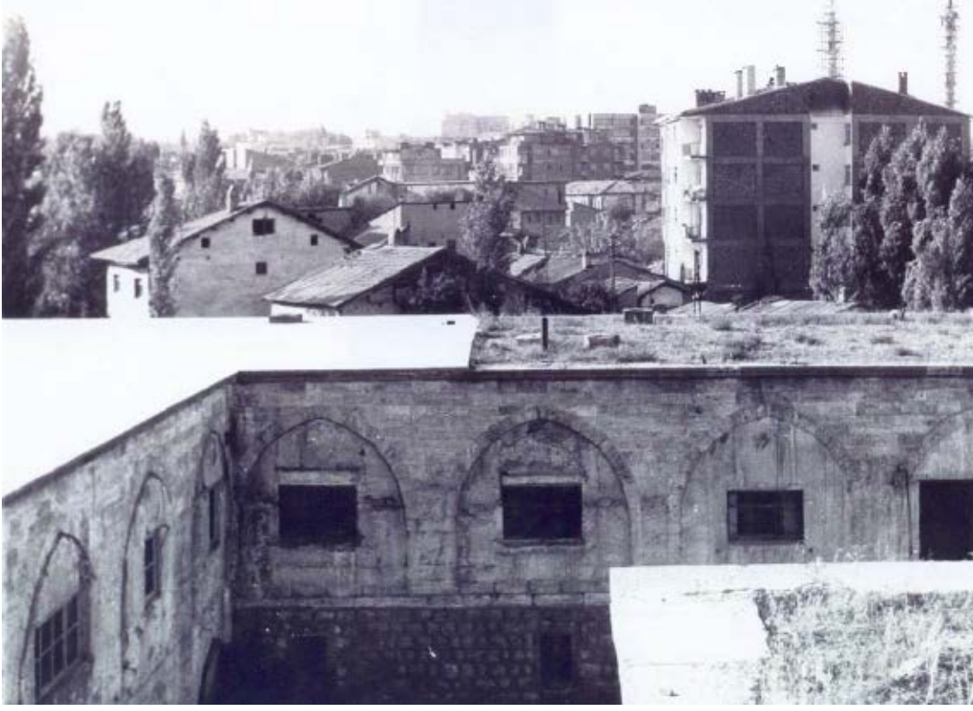
Fotoğraf 32: Örtünün kuzeybatı bölümünde yarım bırakılmış bir beton kaplama detayı / S.V.B.M.F.A.
