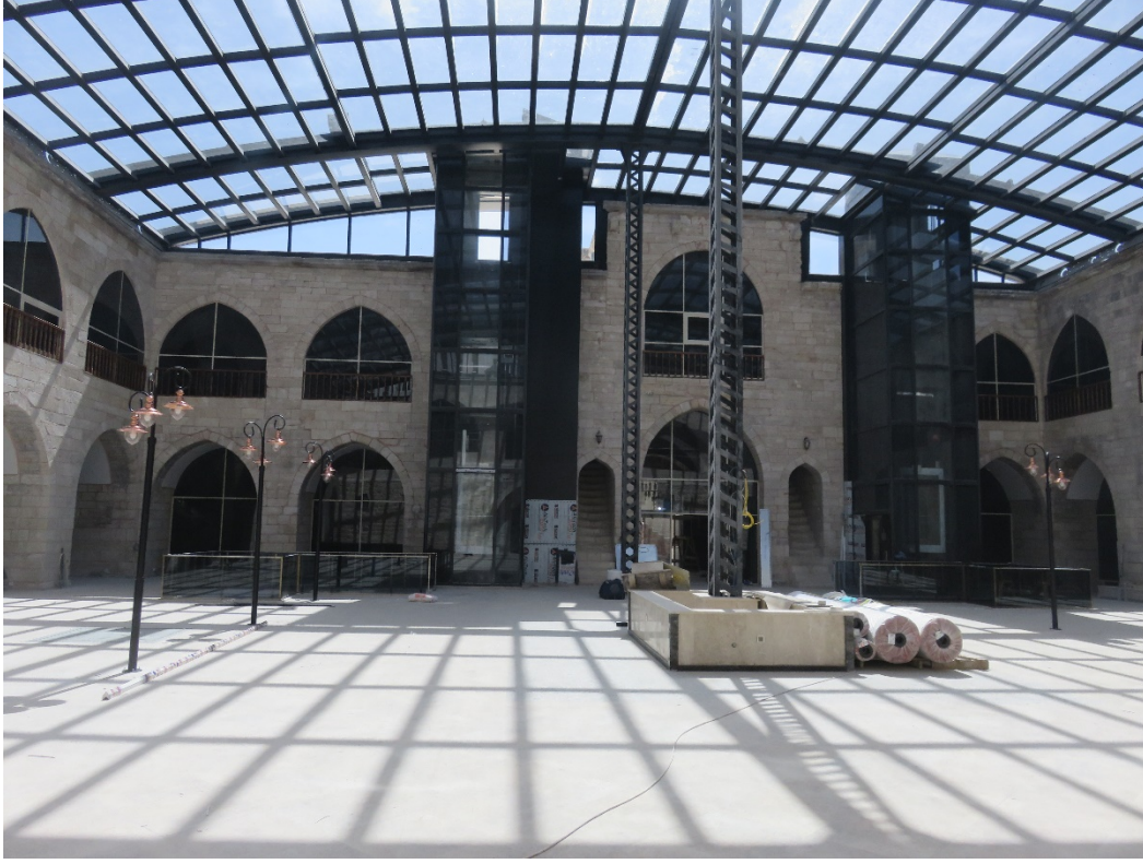
Fotoğraf 285: Behram Paşa Hanı iç avlusu, örtü sistemi ve asansörlere bakış
