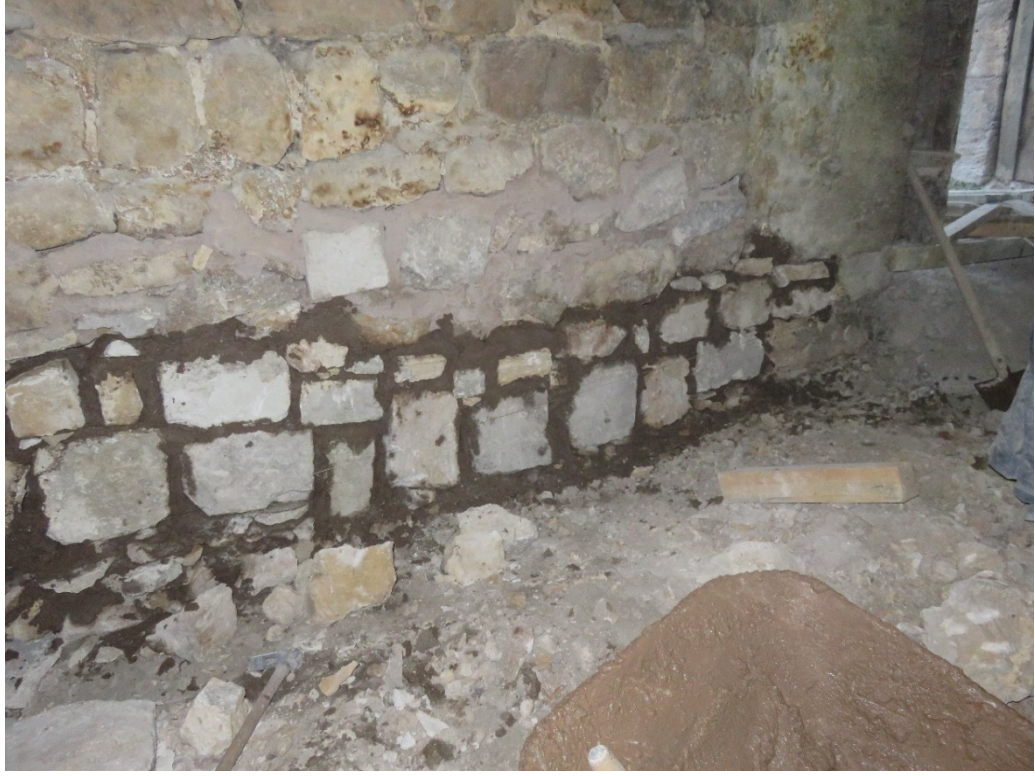
Fotoğraf 176: Yapının ahır bölümündeki iç beden duvarı taşlarının yenilenmesi
