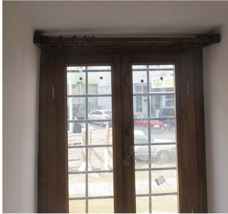
Fotoğraf 162: Restitüsyona göre ahşap dođrama ve pencere yapılması
