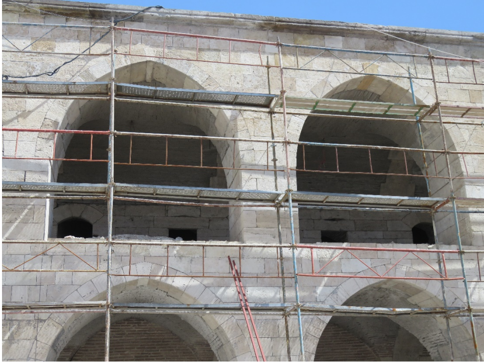
Fotoğraf 224: Kumlama işlemi yapılmış olan kuzeydoğu cephesi
