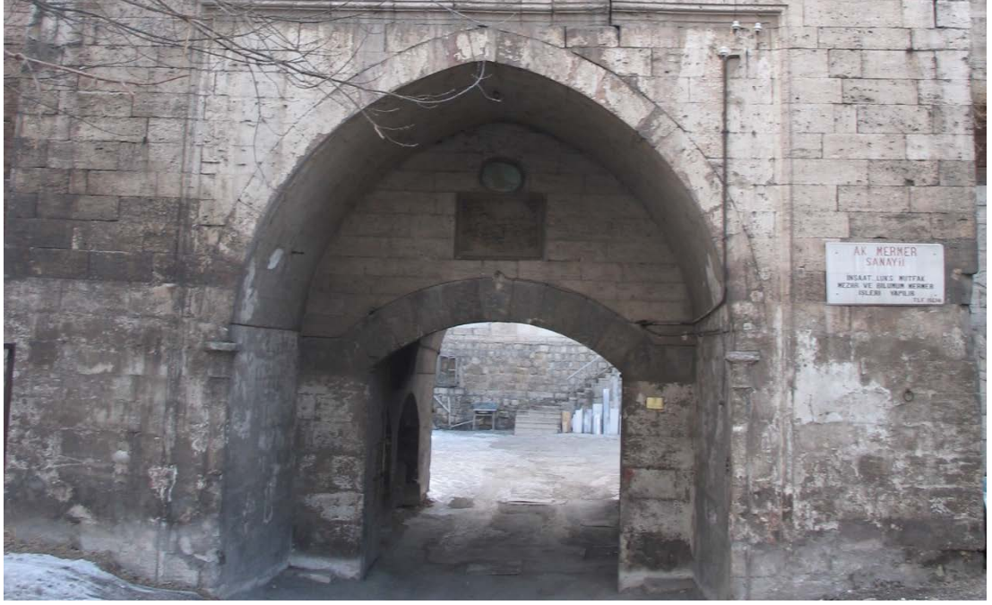
Fotoğraf 90: Güneydoğu cephesinin giriş bölümünün her iki yanında da yer alan sütunçeler
