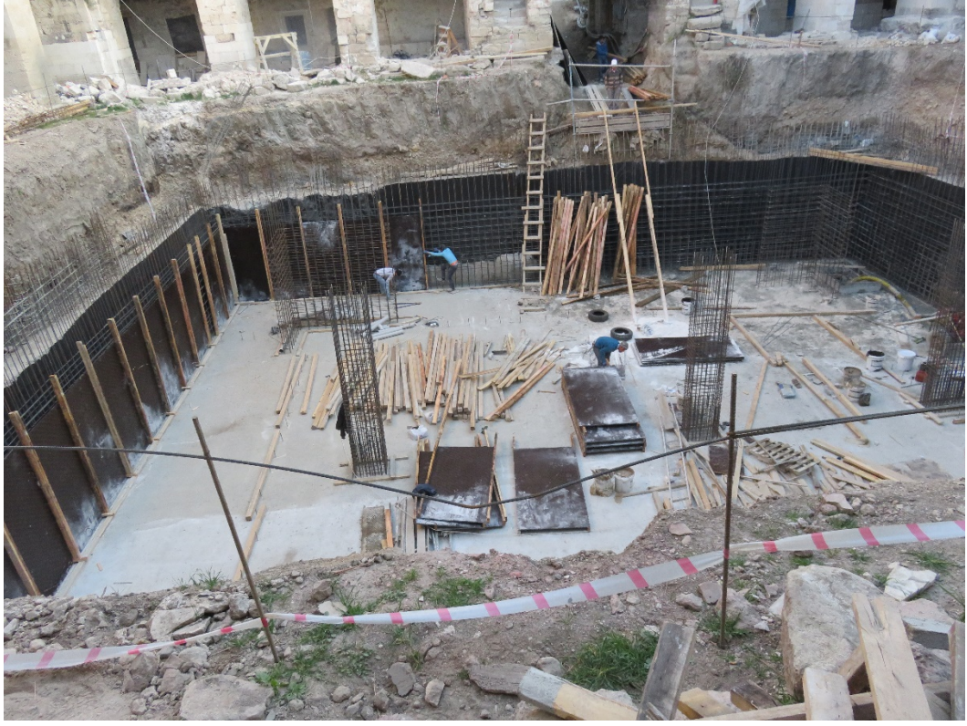
Fotoğraf 133: Hanın, bodrum katı dış beden duvarlarının yapılması
