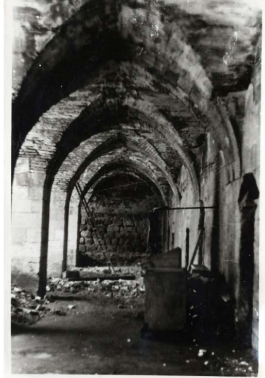
Fotoğraf 28: Zemin kat kuzeydoğu revak / S.V.B.M.F.A
