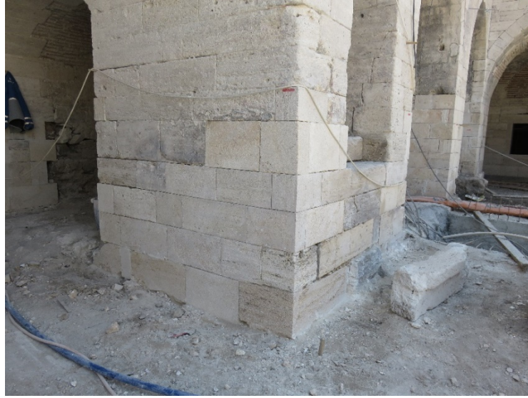
Fotoğraf 228: Hanın giriş bölümündeki kuzeydoğu taraf taşıyıcılarda taş yenilenmesi
