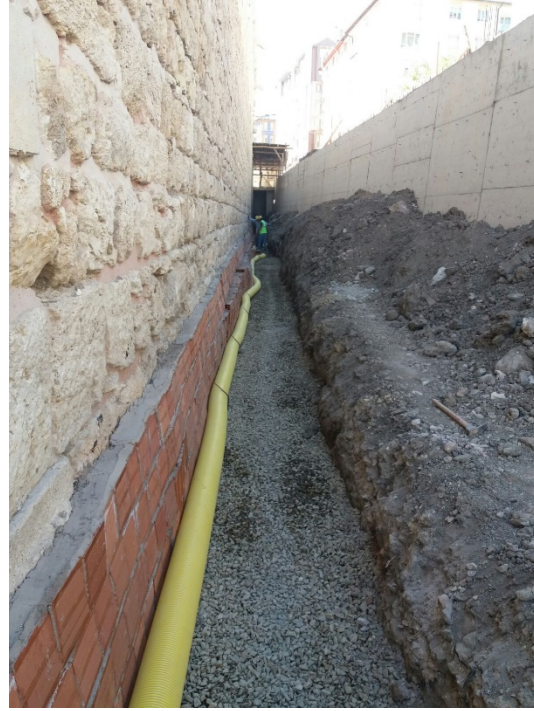
Fotoğraf 233: Behram Paşa Hanı kuzeydoğu cephesi drenaj borusu yerleştirilmesi
