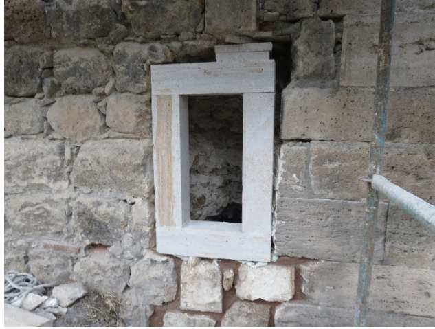
Fotoğraf 237: Mazgal pencere şebekesinin söve değişimi
