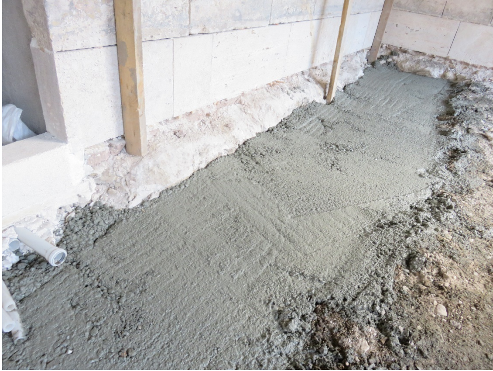
Fotoğraf 121: Zemin kat güneydoğu revakın temel güçlendirme uygulaması
