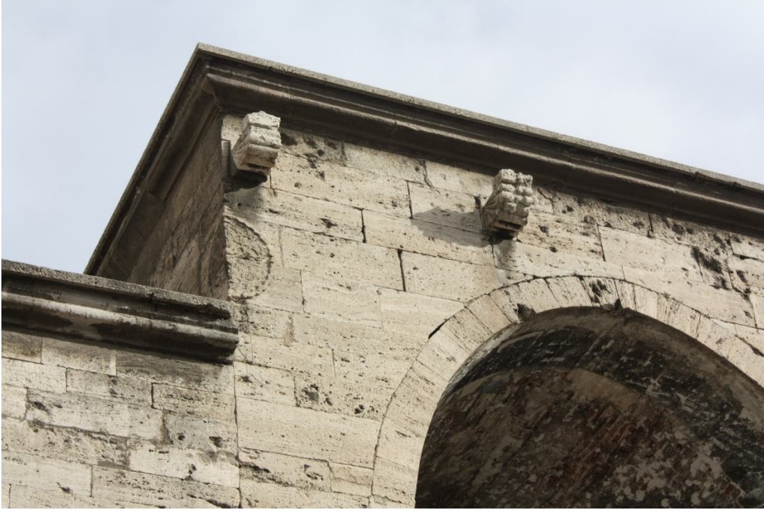
Fotoğraf 104: Behram Paşa Hanı güneydoğu avlu cephesindeki konsol detayı
