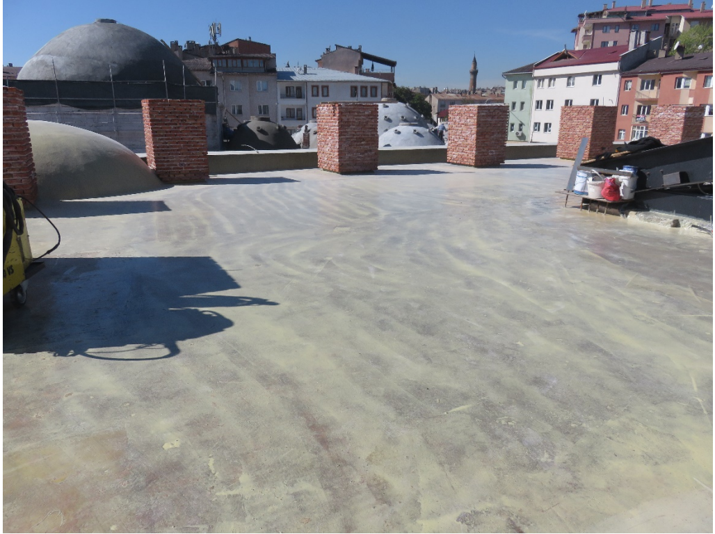
Fotoğraf 277: Örtü bölümü su yalıtım uygulaması
