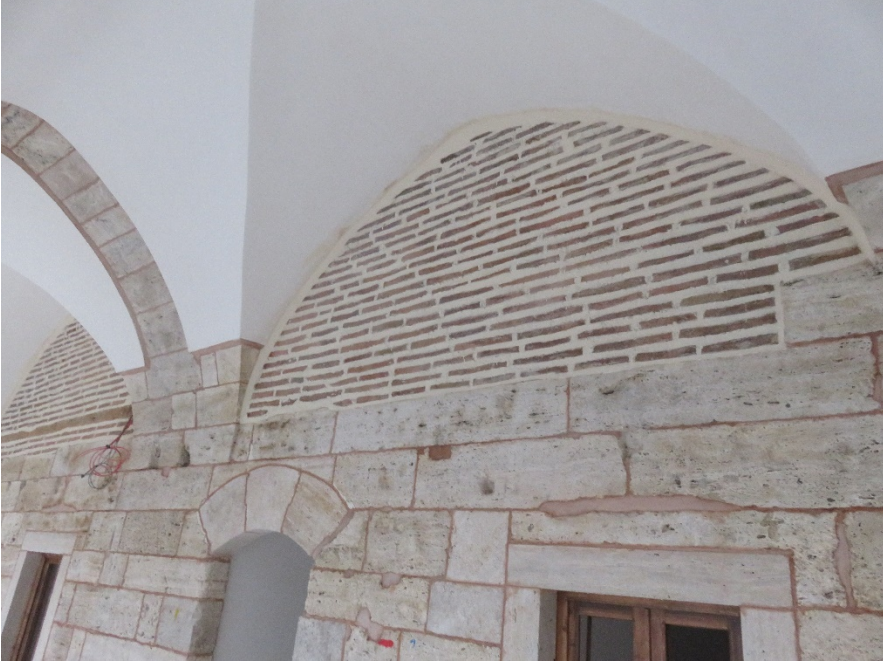
Fotoğraf 253: Odaların revaklara bakan alınlıkları ve korunan harman tuğla detayı
