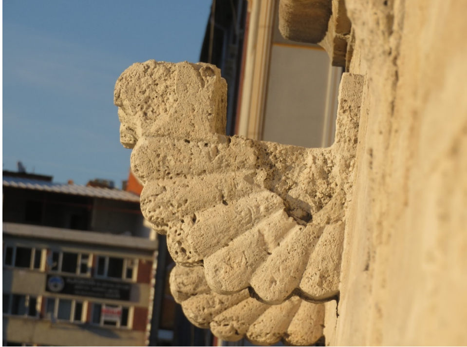
Fotoğraf 107: Behram Paşa Hanı güneydoğu avlu cephesindeki konsol detayı
