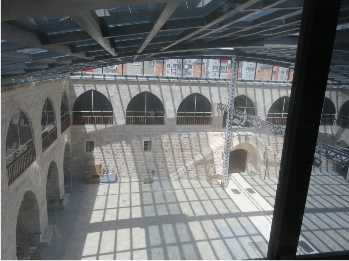
Fotoğraf 167: Hanın kemerli açıklıklarının cam ile kapatılması
