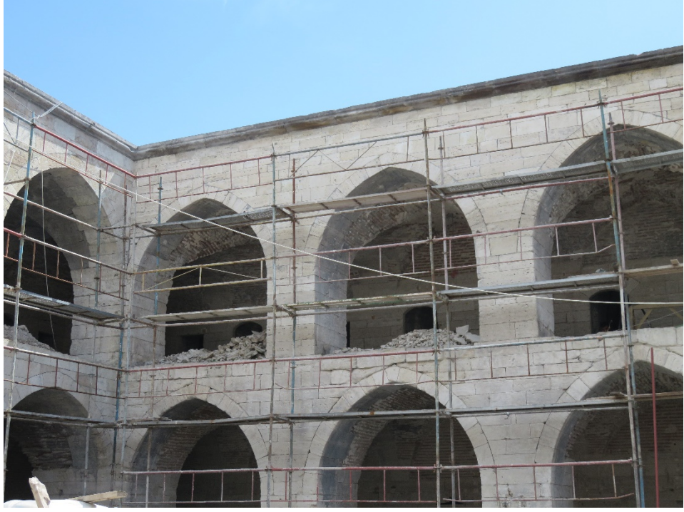
Fotoğraf 223: Kumlama işlemi yapılmış olan güneybatı cephesi
