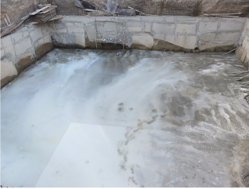
Fotoğraf 135: Hanın bodrum kat dış beden duvarı yapılması
