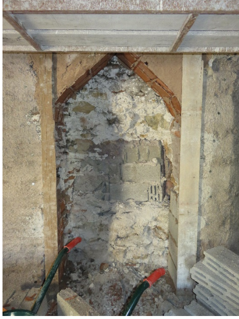
Fotoğraf 109: Ocak nişinin örülmesine dair fotoğraf
