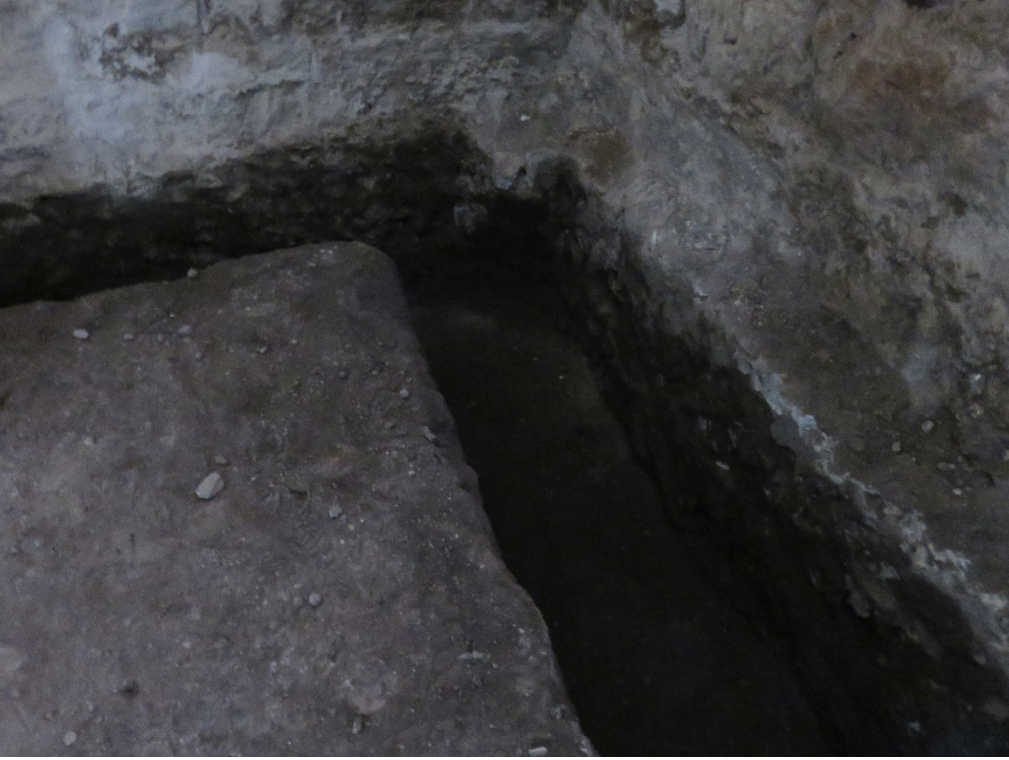
Fotoğraf 116: Zemin kat kuzeydoğu oda zemin güçlendirme için kanal açılması
