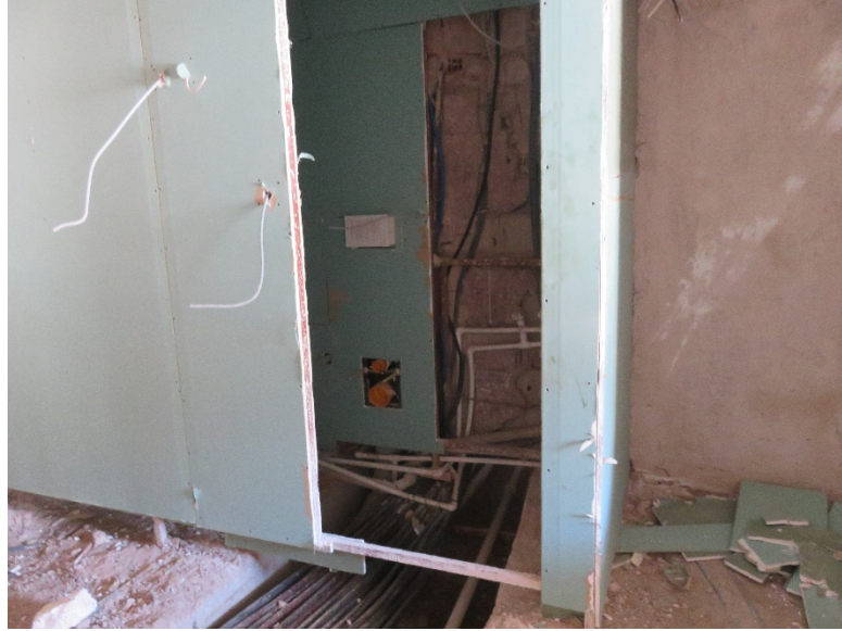
Fotoğraf 129: Odaların içlerine yeşil alçıpan ile duvar yapılması
