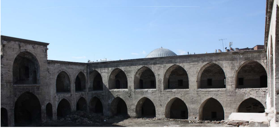
Fotoğraf 73: Behram Paşa Hanı güneybatı avlu cephesine bir bakış
