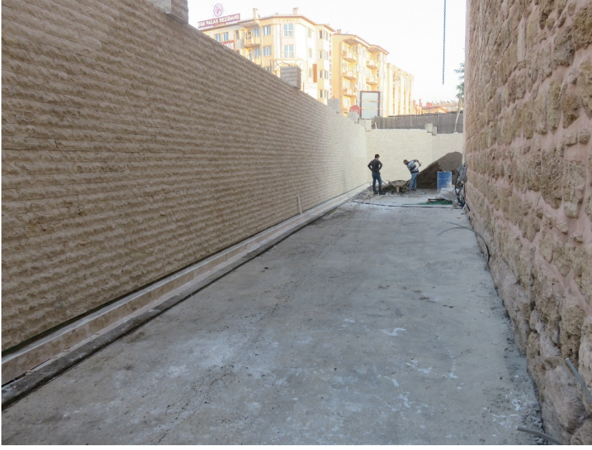
Fotoğraf 257: Kuzeydoğu istinat duvarına patlatma taş kaplama yapılması
