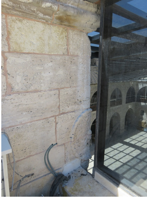
Fotoğraf 249: Yapının örtüsünden güneydoğu cephenin yüksek kesitinde derz yapılması
