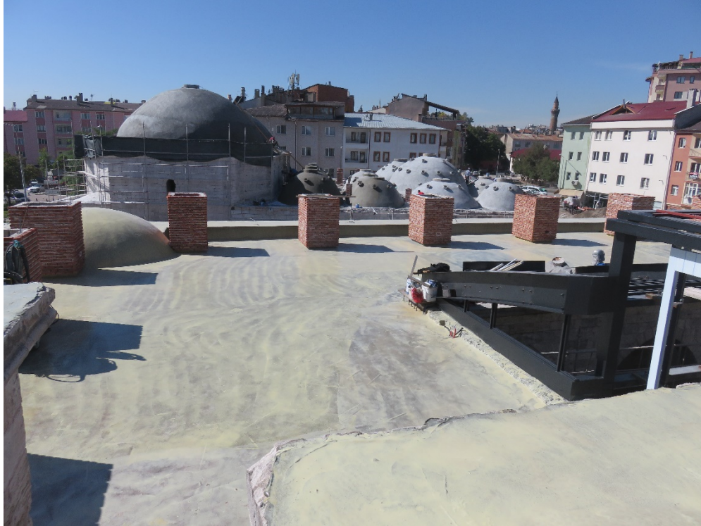
Fotoğraf 279: Örtü bölümü su yalıtım uygulaması
