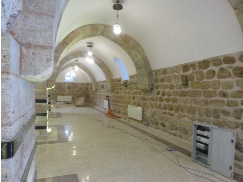
Fotoğraf 205: Alçı sıvası yapılmış yapının ahır bölümü güneybatıya bakış
