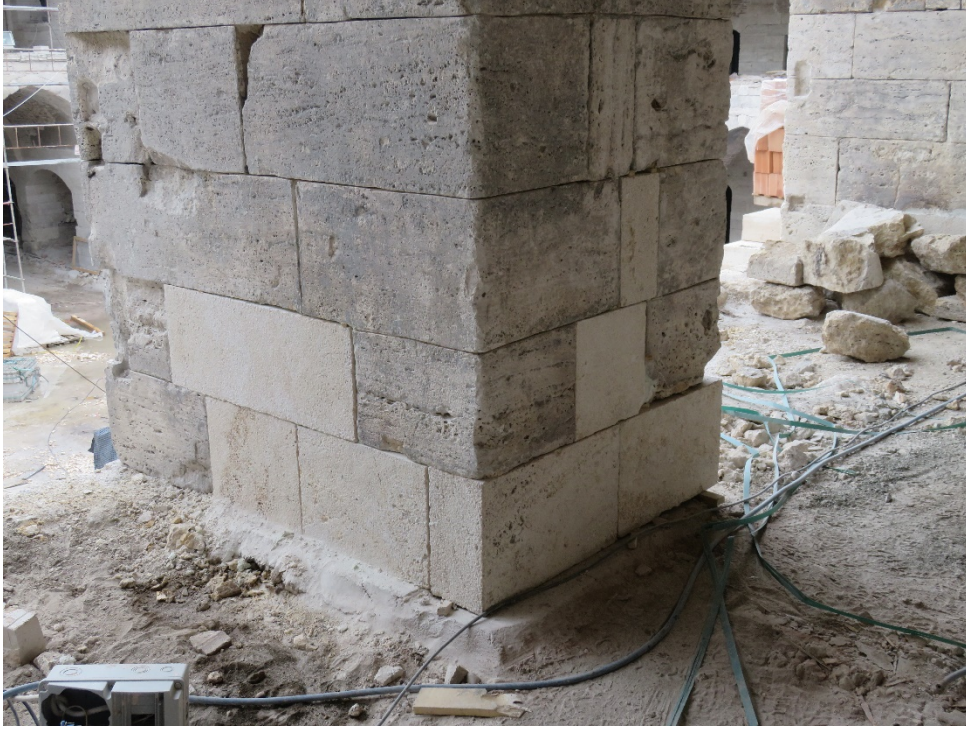
Fotoğraf 178: Yapının 1.kat kuzeybatı revakındaki taşıyıcı ayaklara taş kaplama yapılması
