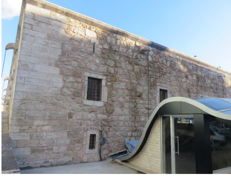
Fotoğraf 163: Restitüsyona göre ahşap doğrama ve pencere yapılması
