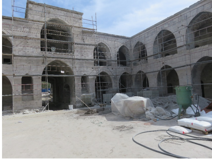
Fotoğraf 209: Kumlanan cephe yüzeyleri
