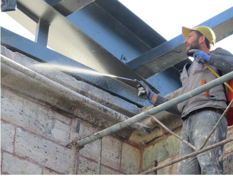
Fotoğraf 225: Arap sabunu ile cephe temizliđi uygulaması
