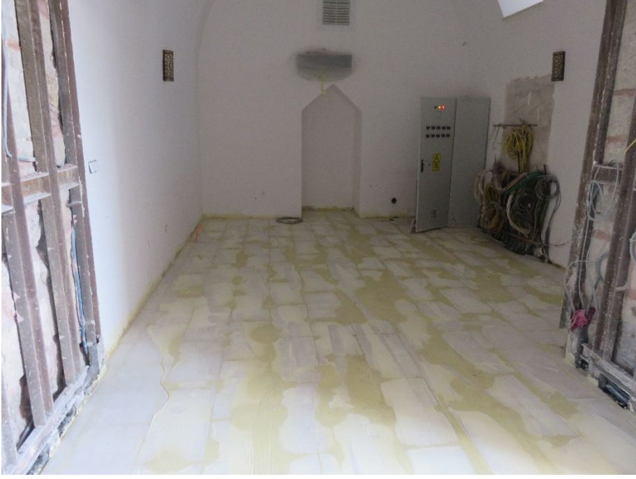
Fotoğraf 206: Alçı sıvası yapılmış hanın girişi kuzeydoğu odası
