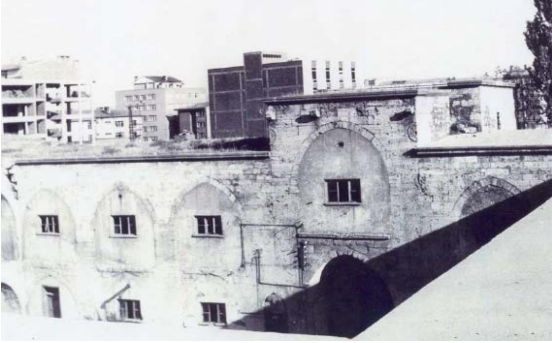
Fotoğraf 20: Güneydoğu avlu cephesine örtüden bir bakış / S.V.B.M.F.A
