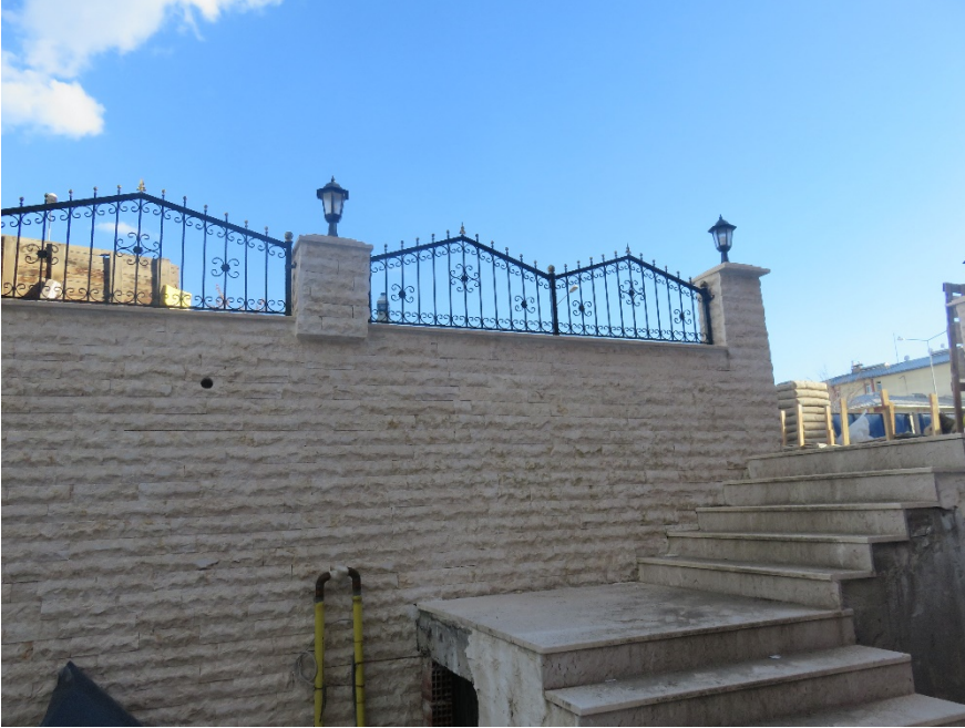
Fotoğraf 258: Güneydoğu istinat duvarına patlatma taş kaplama yapılması
