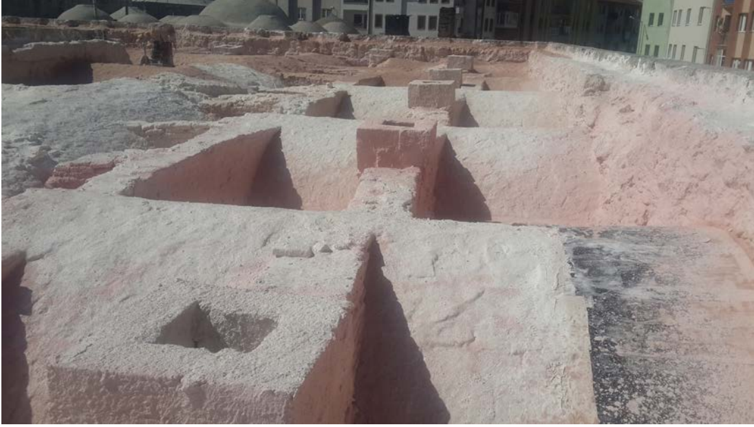
Fotoğraf 270: Hidrolik kireç harcının tonoz üstlerine dökülmesi ve karbon kumaş uygulaması
