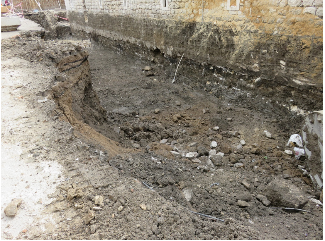
Fotoğraf 148: Hanın kuzeybatısına yapılacak olan eklenti bina için temel kazısı yapılması
