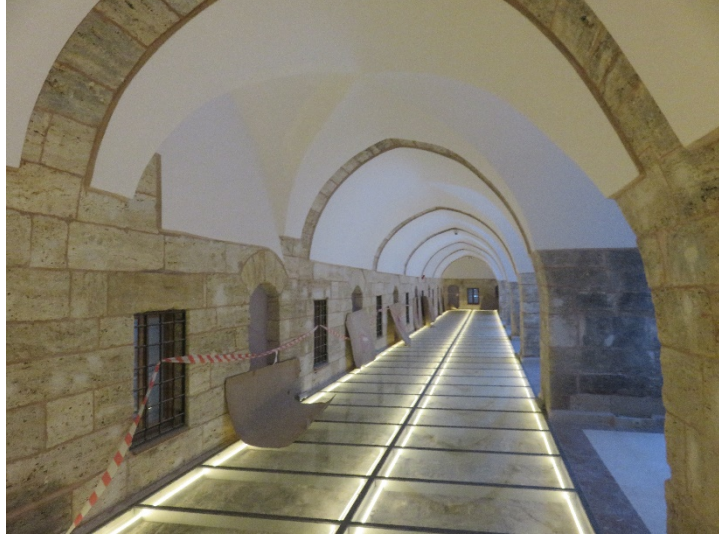
Fotoğraf 184: Behram Paşa Hanı 1.kat güneybatı revakı cam ile zemin koruma uygulaması
