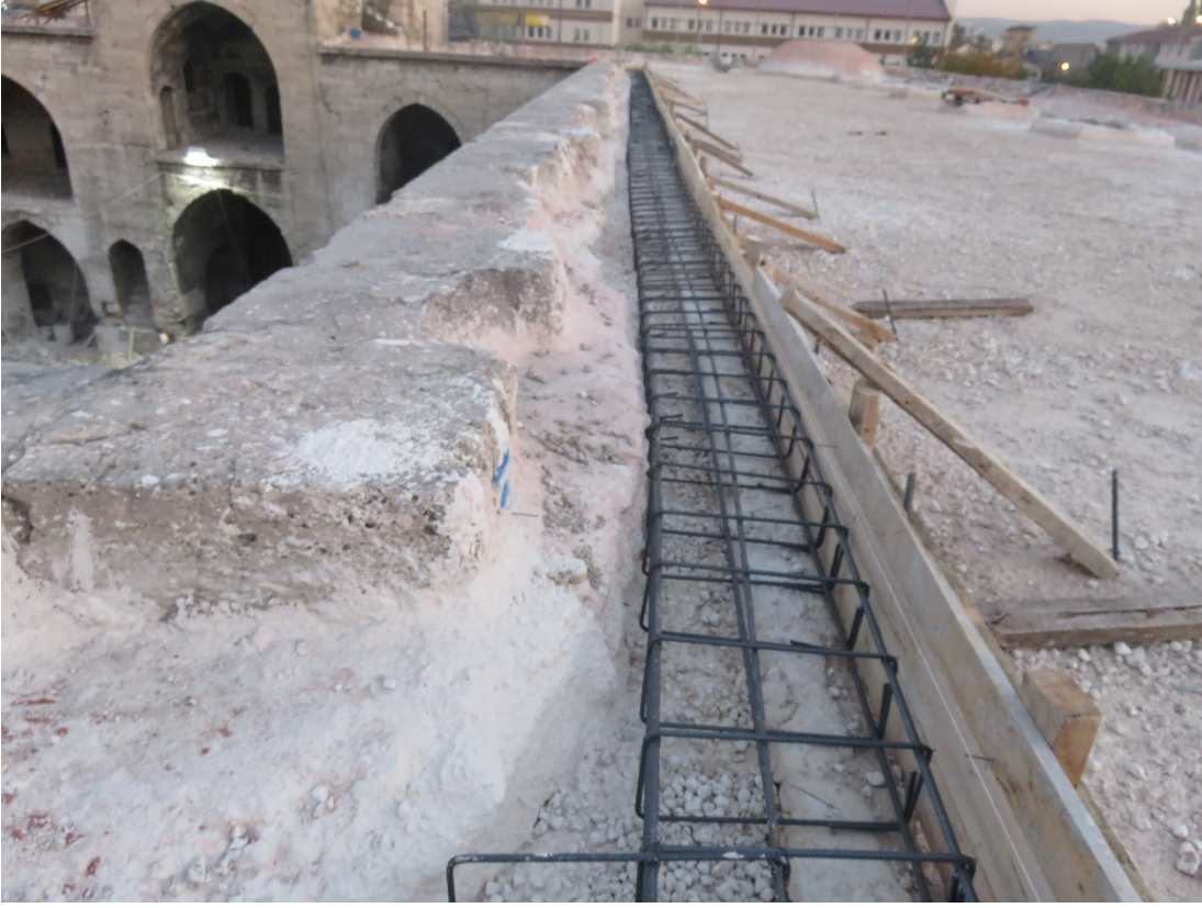
Fotoğraf 292: Örtüye hatıl yapılması ve demirlerin yerleştirilmesi
