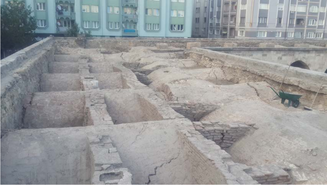
Fotoğraf 268: Mozaik döşemenin el aletleriyle kaldırılması ve tonozlara ulaşılması
