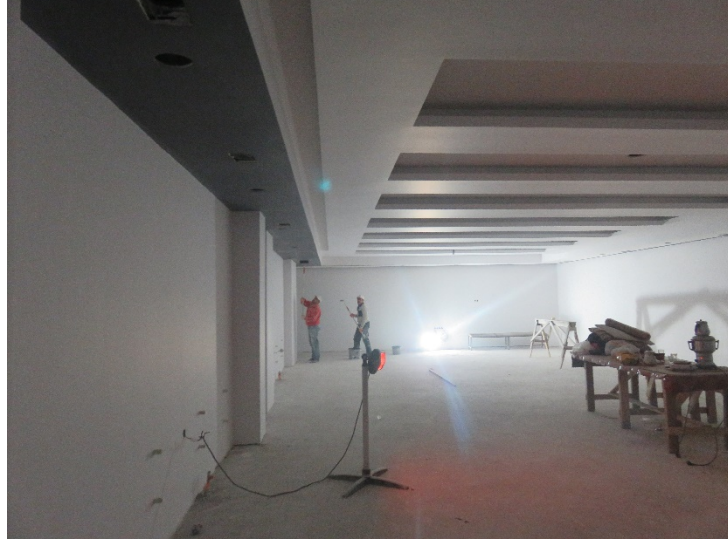
Fotoğraf 155: Havalandırma şaftı ve kanalların yapılması
