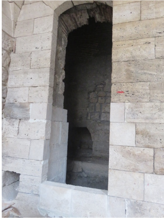
Fotoğraf 172: Kapı Őebekelerinin onarılması
