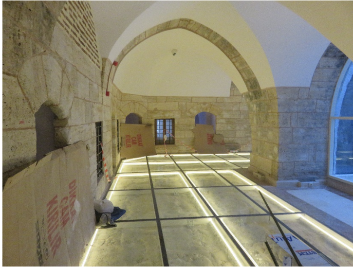
Fotoğraf 183: Behram Paşa Hanı 1.kat güneybatı revakı cam ile zemin koruma uygulaması
