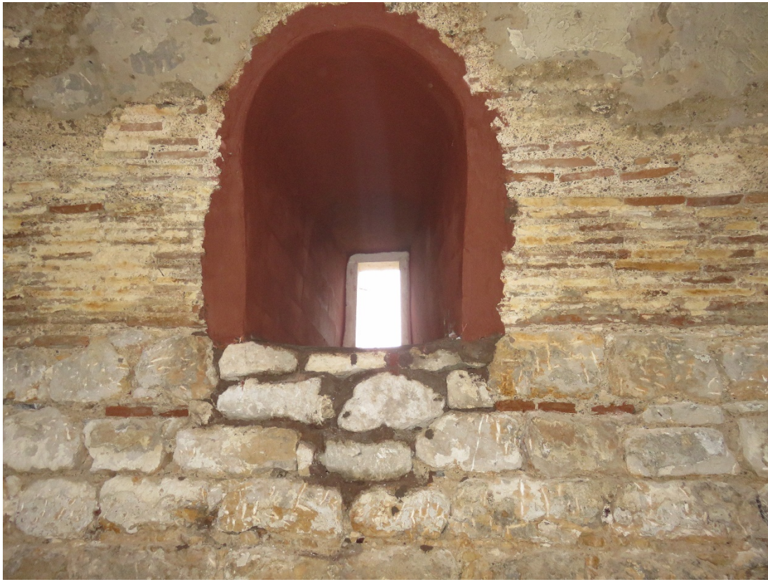
Fotoğraf 170: Pencere şebekelerinin onarılması
