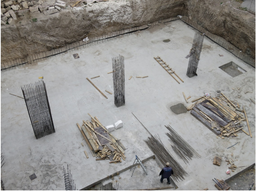
Fotoğraf 137: Hanın bodrum birinci kat tabliye betonunun dökülmesi
