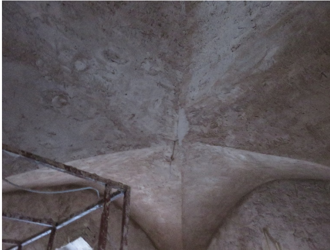
Fotoğraf 203: Horasan harcı ile sıvası yapılmış haç tonoz
