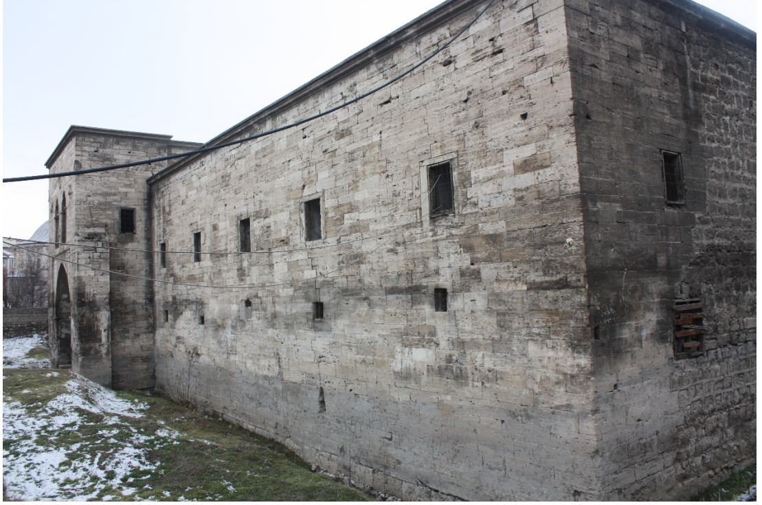
Fotoğraf 48: Güneydoğu cephesi zemin kat odaların mazgal pencereleri
