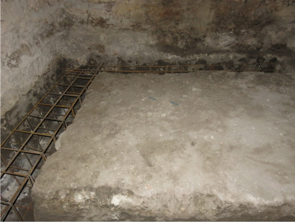
Fotoğraf 117: Zemin kat güneybatı oda zemin güçlendirme kanallarına demirlerin yerleştirilmesi
