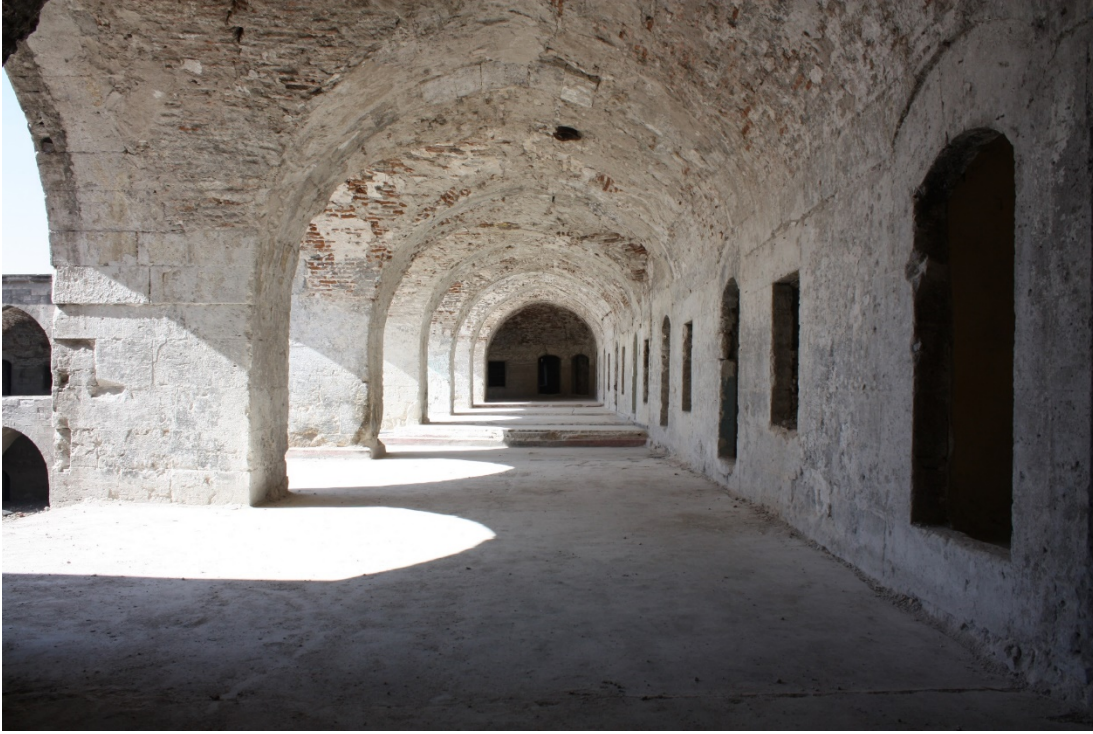
Fotoğraf 63: Behram Paşa Hanı'nın 1.kat kuzeybatı revakı
