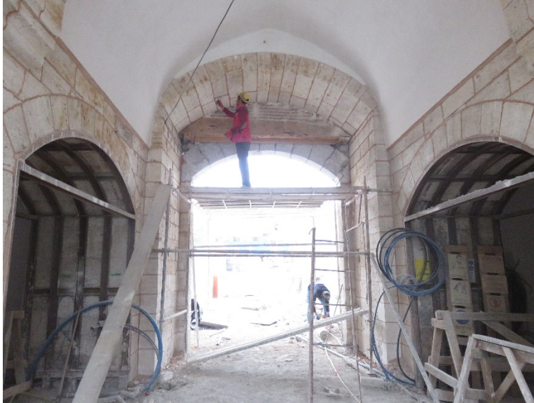
Fotoğraf 215: Yapının giriş kapısının kemer arkasında yer alan ahşap hatıl yenilenmesi
