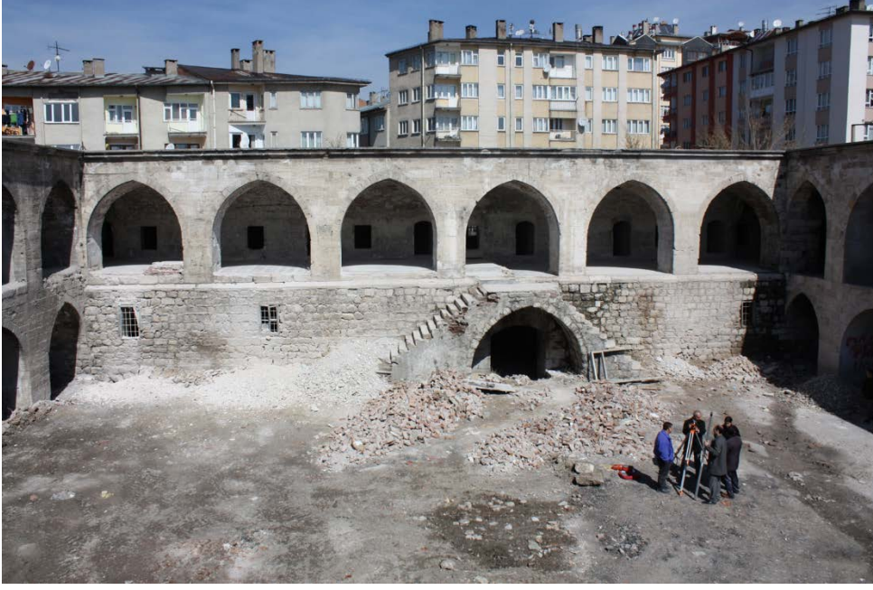
Fotoğraf 40: Hanın Kuzeybatı cephesine ve ahır bölümünün girişine bir bakış
