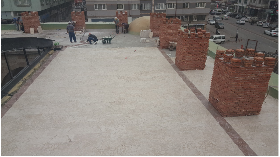
Fotoğraf 281: Örtüye cilalı traverten yapılması
