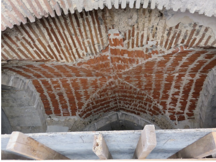
Fotoğraf 210: Yapının 1.kat kuzeybatısında yenilenen haç tonoz
