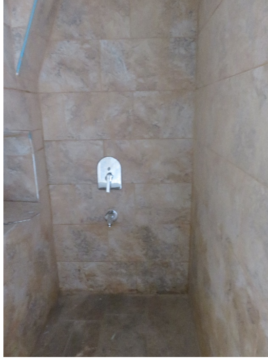
Fotoğraf 143: Alçıpan üzerine fayans yapılması
