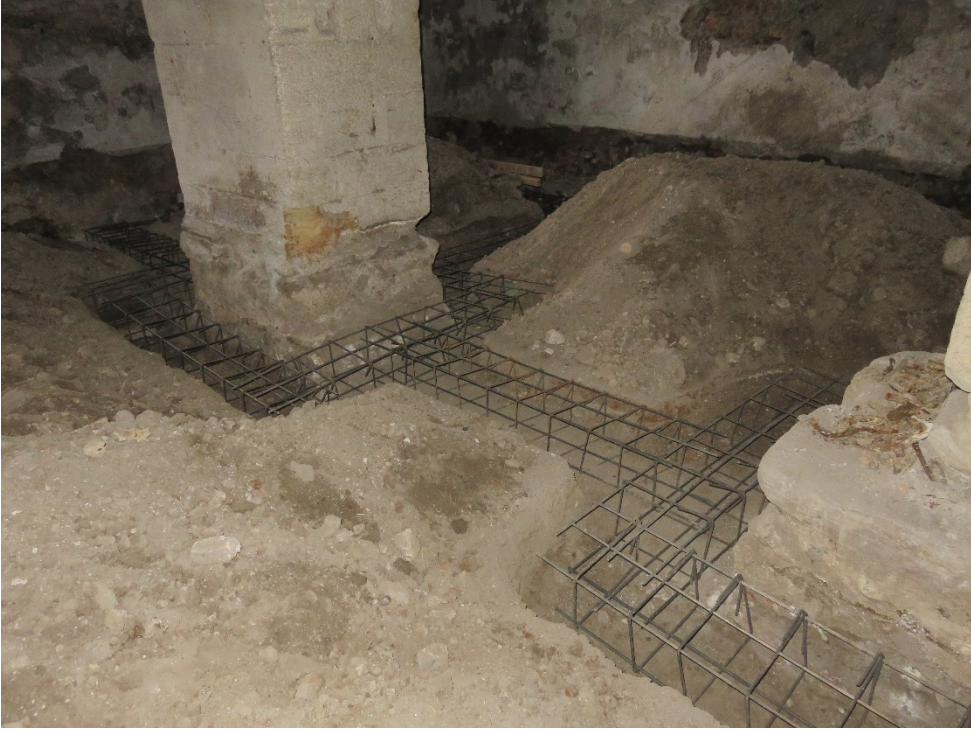
Fotoğraf 124: Hanın ahır bölümünde kanallara demirlerin yerleştirilmesi
