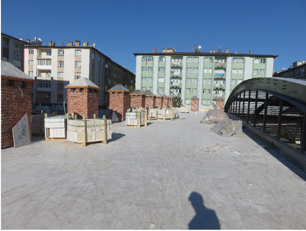
Fotoğraf 282: Örtüye cilalı traverten yapılması
