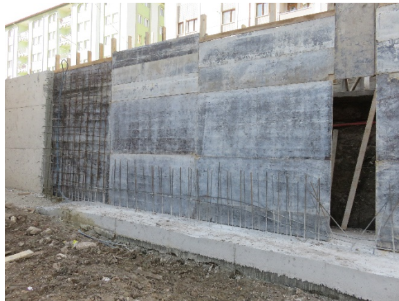
Fotoğraf 256: Kuzeydoğu cephesi istinat duvarının perde betonu kalıplarının hazırlanması
