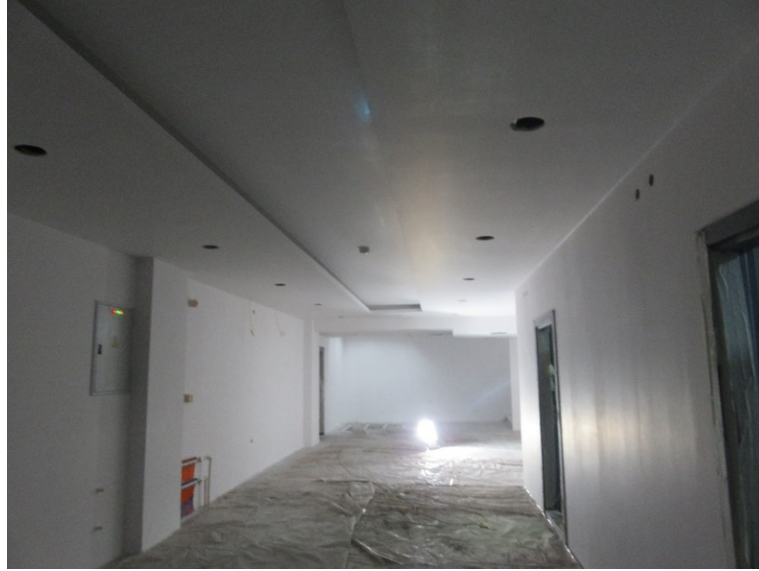
Fotoğraf 156: Havalandırma şaftı ve kanalların yapılması
