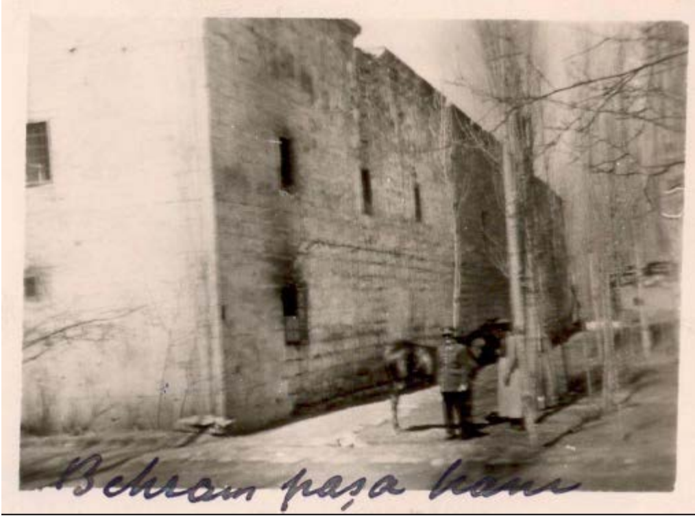
Fotoğraf 14: Behram Paşa Hanı'nın kuzeydoğu cephesi / S.V.B.M.F.A
