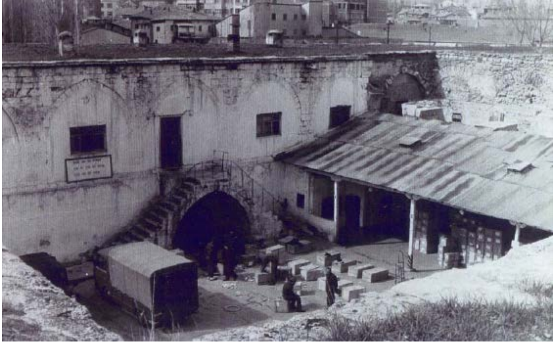
Fotoğraf : 18 Avlunun güney köşesinden kuzeybatı ve kuzeydoğu cephelere bir bakış / S.V.B.M.F.A.
