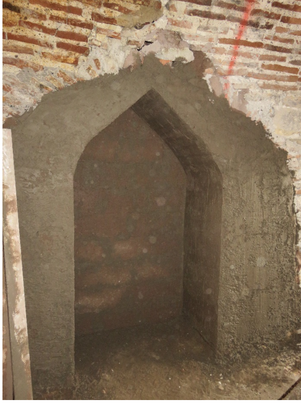
Fotoğraf 111: Ocak nişinin örülmesine dair fotoğraf
