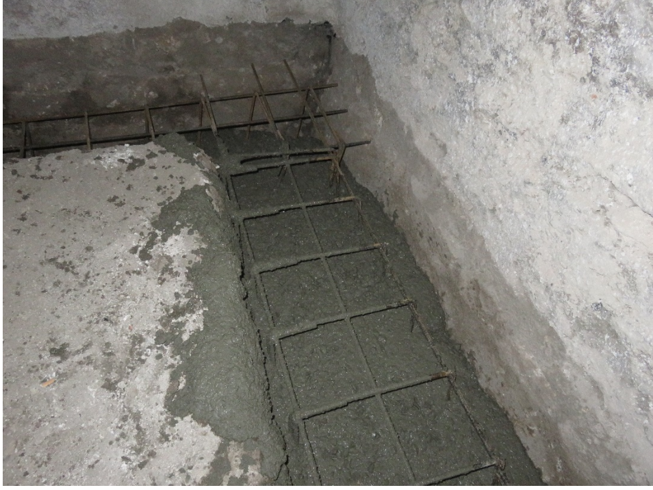
Fotoğraf 118: Zemin kat kuzeydođu oda temel güçlendirme için beton harcı dökülmesi.
