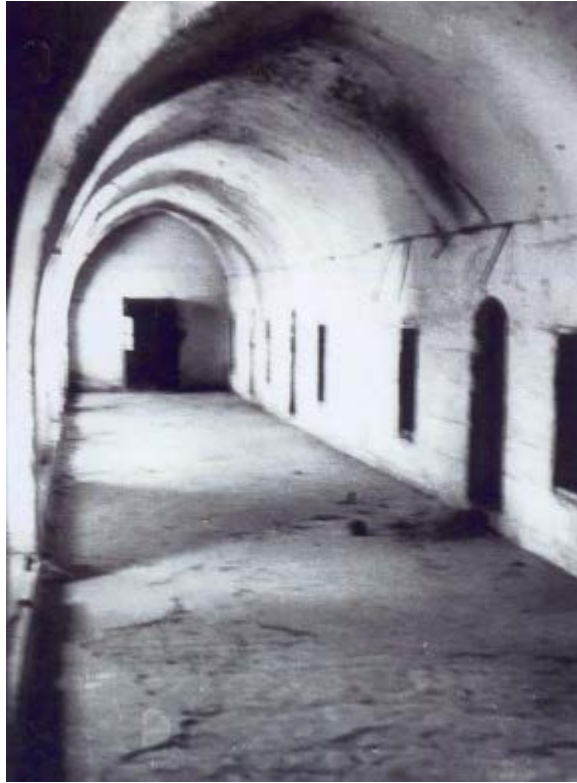
Fotoğraf 24: Hanım 1. katı güneybatı revaka bir bakış / S.V.B.M.F.A
