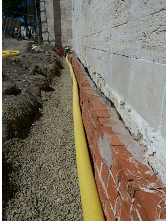
Fotoğraf 232: Behram Paşa Hanı güneydoğu cephesi drenaj borusunun yerleştirilmesi
