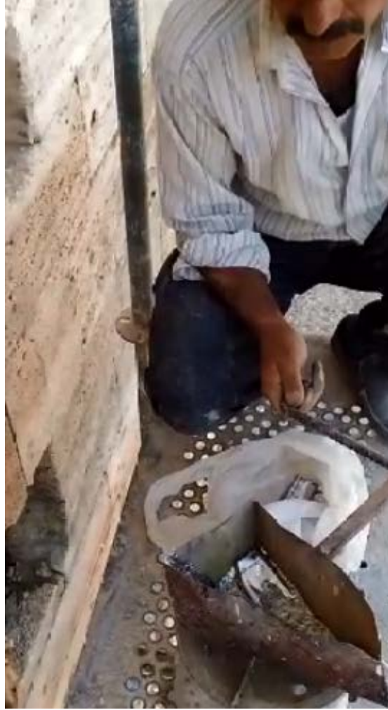
Fotoğraf 240: Mekanik dikiş için kurşun eritilmesi
