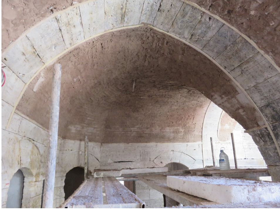
Fotoğraf 204: Horasan harcı ile sıvası yapılmış revak tonozu
