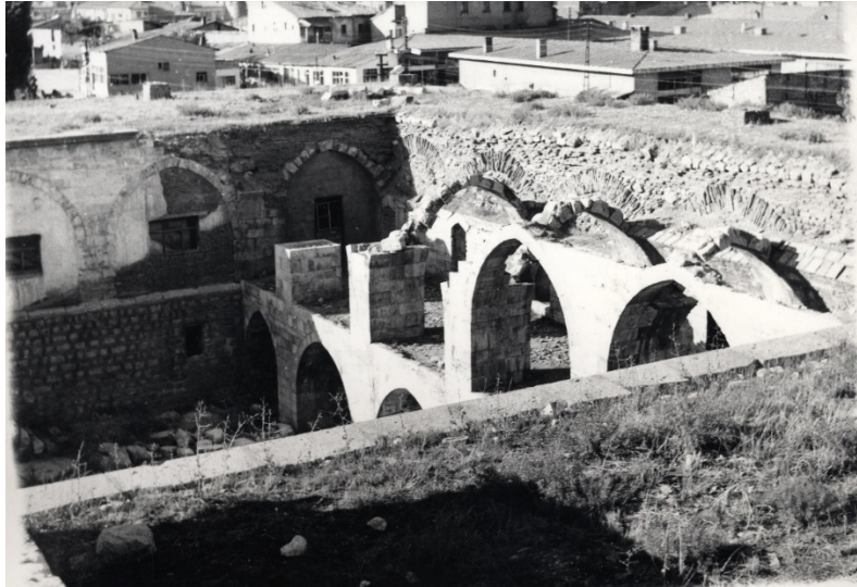
Fotoğraf 67: Behram Paşa Hanı kuzeydoğu cephesi, 1980 yılı restorasyon öncesi görseli / S.V.B.M.F.A.
