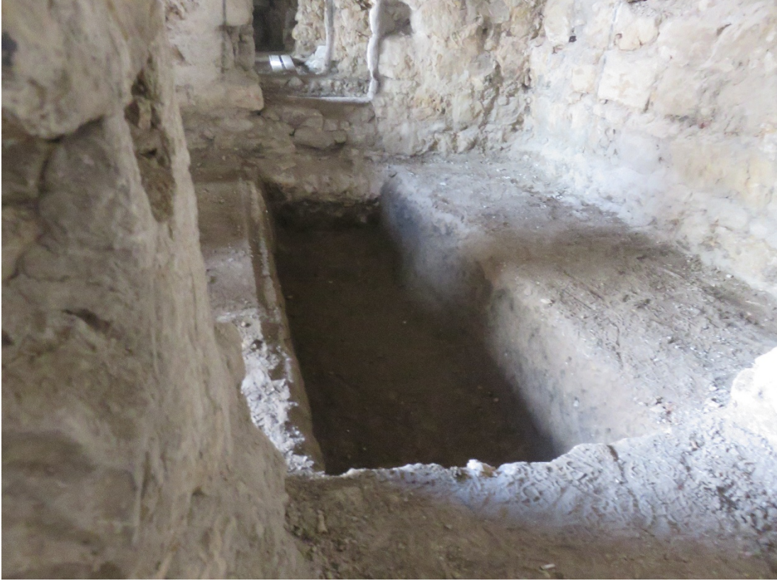
Fotoğraf 157: Zemin kat odalarda kanal açma ve tesisat borularını ekleme çalışmaları
