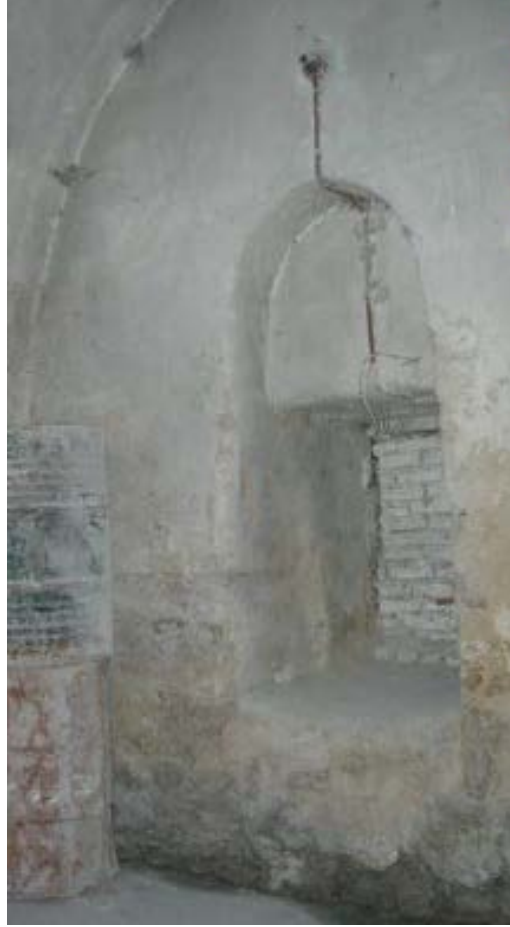
Fotoğraf 12: Örülerek kapatılan pencere açıklığı
