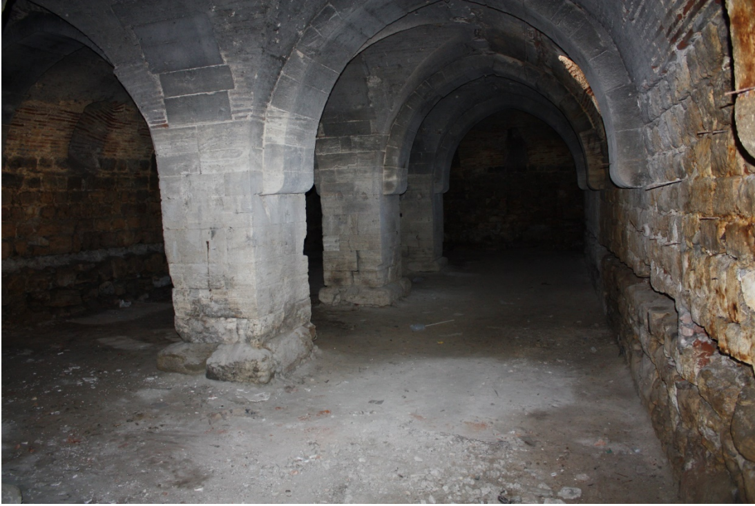
Fotoğraf 61: Behram Paşa Hanı'nın ahır içinden kuzeydoğu bölümüne bakış
