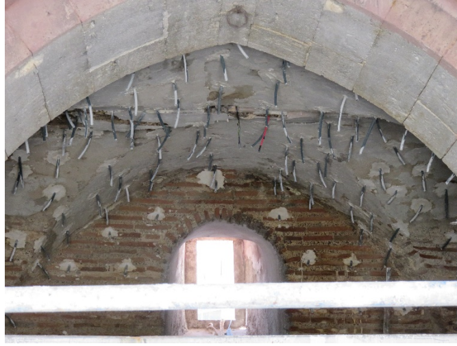
Fotoğraf 234: Yapının ahır bölümünün duvarlarına enjeksiyon işlemlerinin uygulanması
