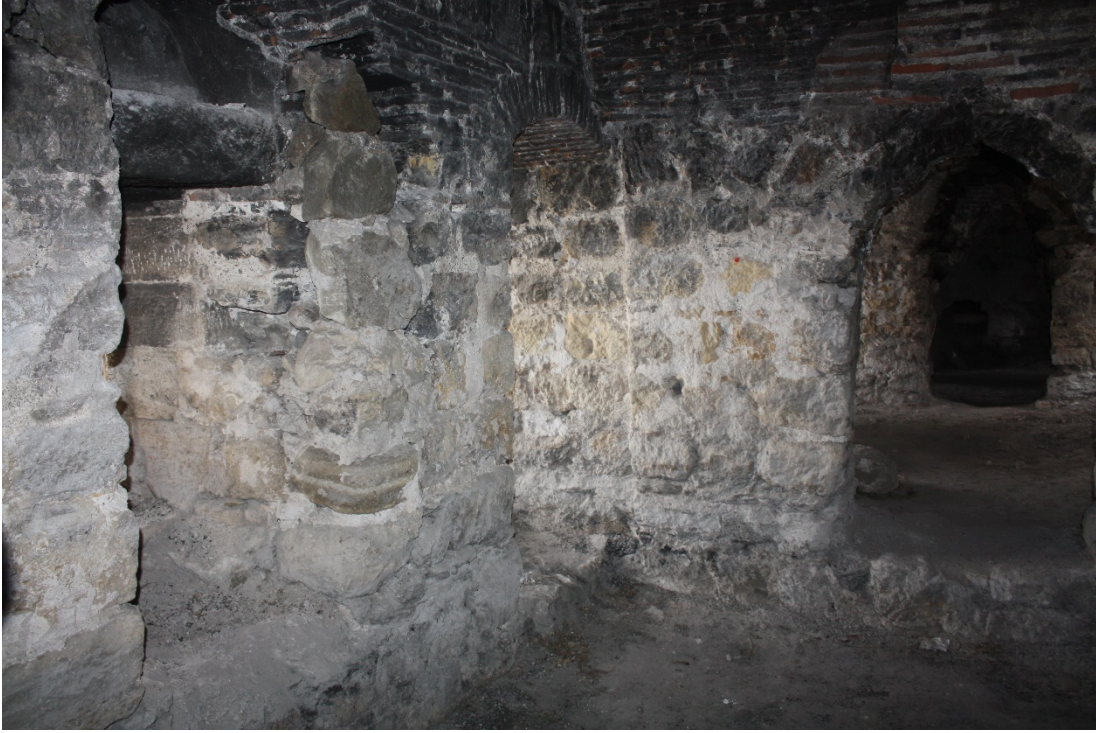
Fotoğraf 83: Ocakların yıkılarak odalar arası geçiş sağlanması
