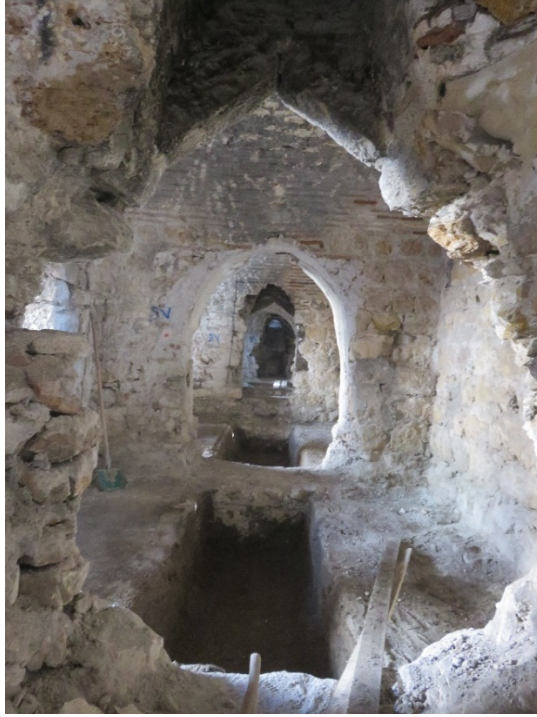
Fotoğraf 159: Zemin kat odalarda kanal açma ve tesisat borularını ekleme çalışmaları
