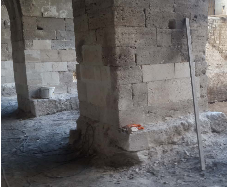
Fotoğraf 181: Yapının zemin kat güneybatı revakındaki taşıyıcı ayaklara taş kaplama yapılması
