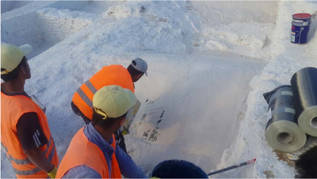
Fotoğraf 271: Hidrolik kireç harcının tonoz üstlerine dökülmesi ve karbon kumaş uygulaması
