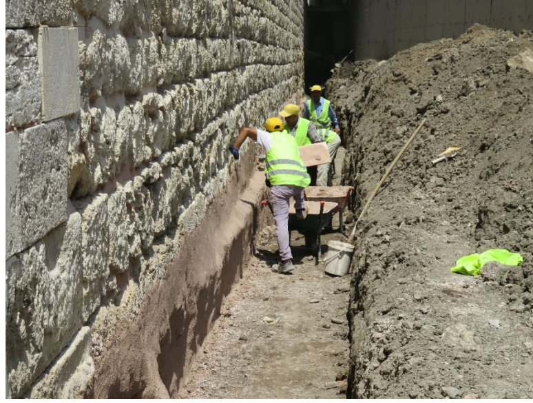
Fotoğraf 231: Behram Paşa Hanı kuzeydoğu cephesi drenaj çukurunun açılması ve bozuk temel taşlarının değiştirilip horasan harcıyla örülmesi)
