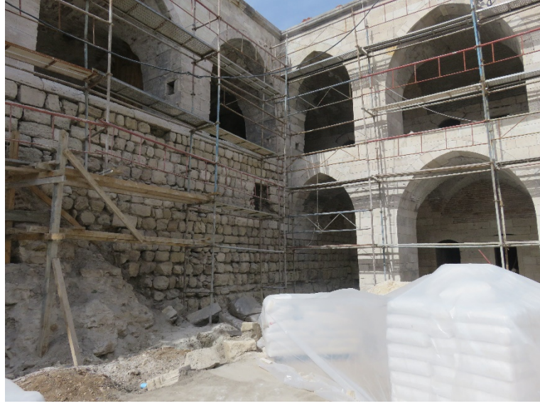
Fotoğraf 208: Kumlanan cephe yüzeyleri
