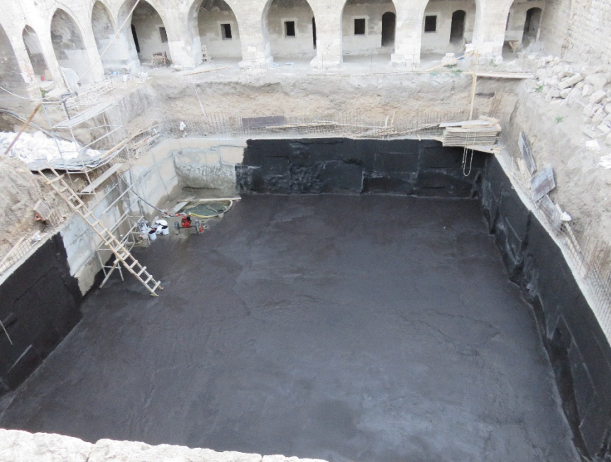
Fotoğraf 136: Hanın bodrum kat beden duvarına yalıtım malzemesi sürülmesi
