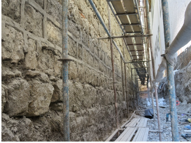
Fotoğraf 243: Kuzeydoğu cephesi çimento esaslı derzlerin sökülmesi
