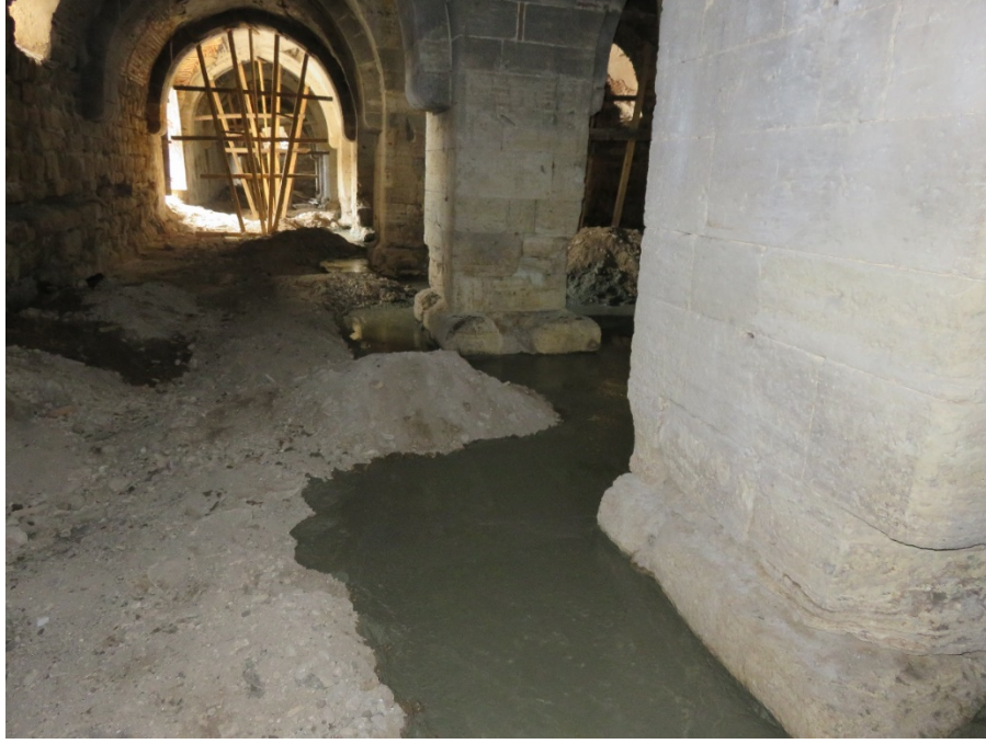
Fotoğraf 126: Hanın ahır bölümünde demir eklenen kanallara beton harcı dökülmesi
