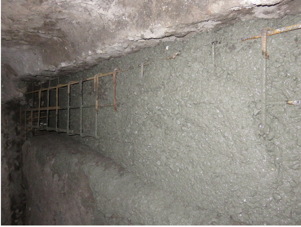
Fotoğraf 120: Zemin kat kuzeydoğu oda temel güçlendirme için beton harcı dökülmesi
