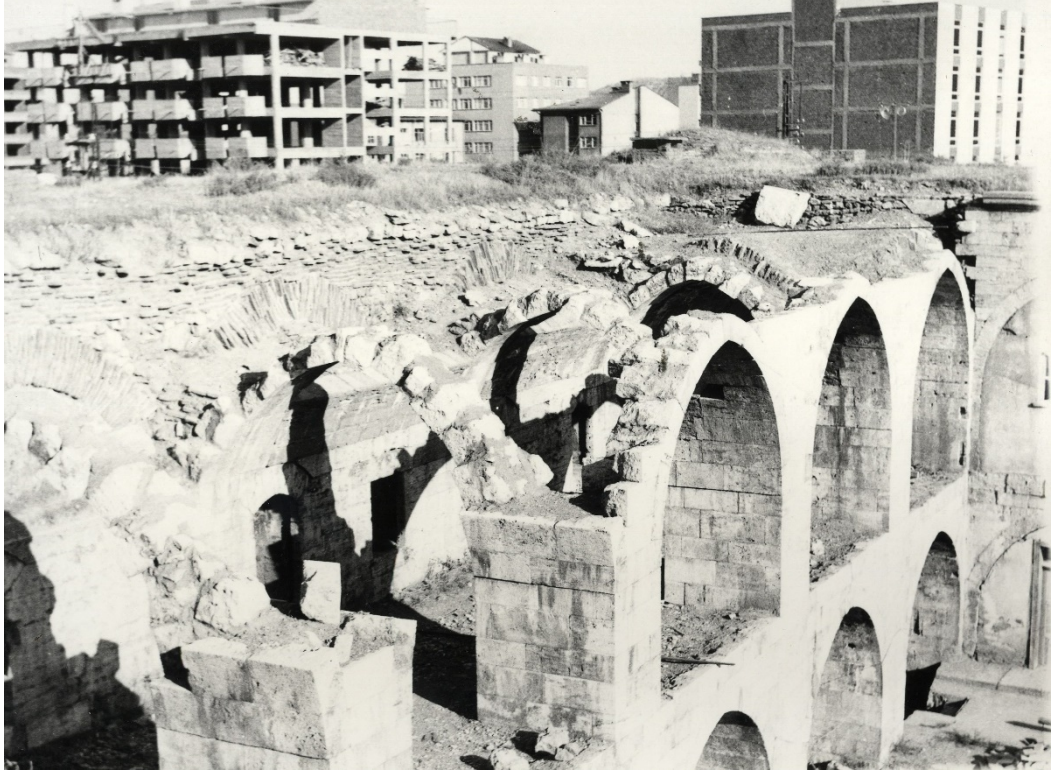
Fotoğraf 68: Behram Paşa Hanı kuzeydoğu cephesi, 1980 yılı restorasyon öncesi görseli / S.V.B.M.F.A.
