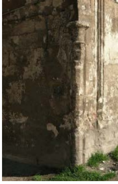
Fotoğraf 92: Behram Paşa Hanı giriş cephesinin kuzeydoğu köşesinde yer alan sütünce detayı
