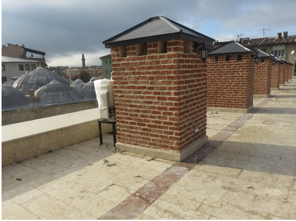
Fotoğraf 300: Örtüde baca yapılması
