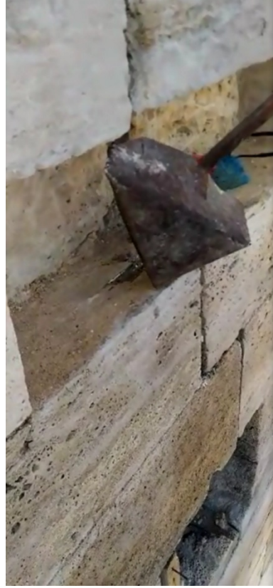
Fotoğraf 242: Eritilen kurşunun demir üstüne dökülmesi
