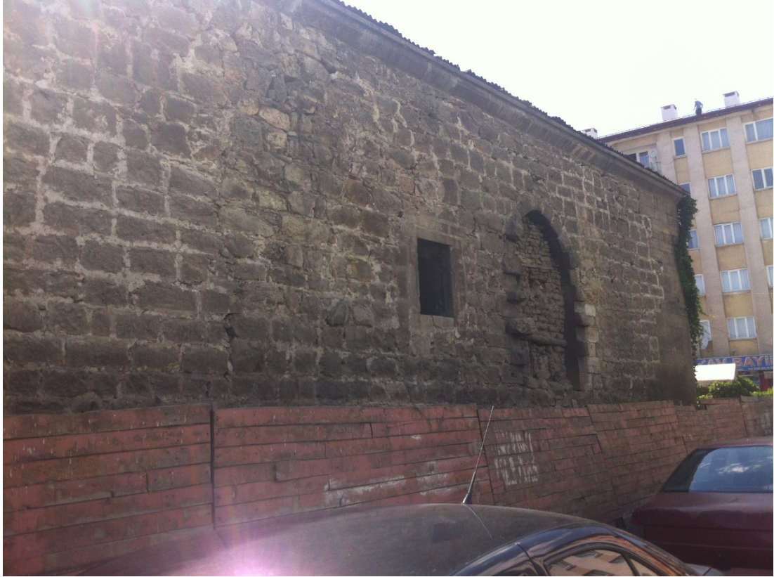
Fotoğraf 64: Behram Paşa Hanı'nın Kuzeydoğu cephesinde bulunan açıklık
