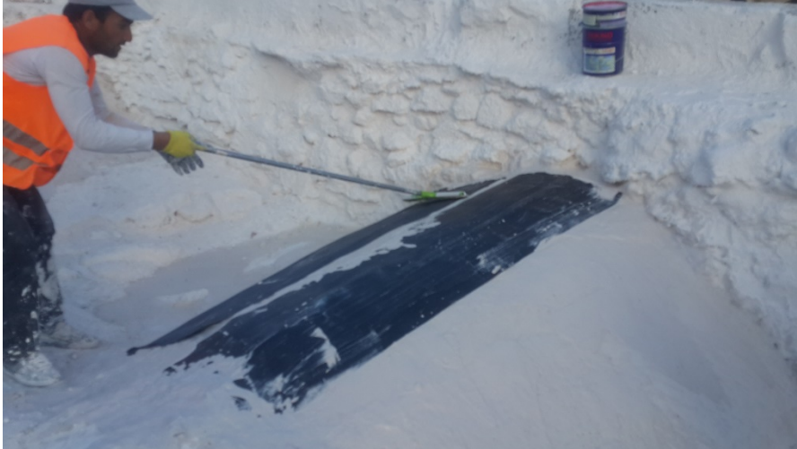
Fotoğraf 199: Örtüdeki çatlayan tonozun fiber karbon kumaş ile güçlendirilmesi
