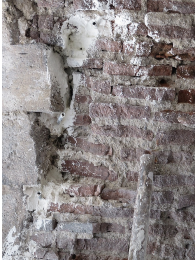
Fotoğraf 197: Enjeksiyon uygulaması sırasında taşan hidrolik kireç
