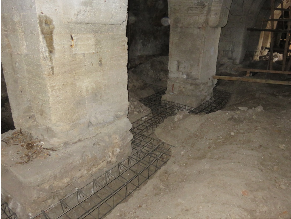
Fotoğraf 125: Hanın ahır bölümünde kanallara demirlerin yerleştirilmesi
