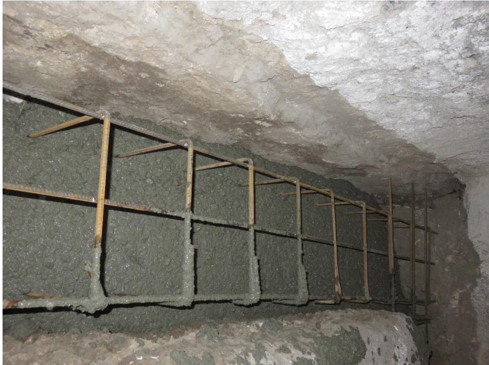
Fotoğraf 119: Zemin kat kuzeydođu oda temel güçlendirme için beton harcı dökülmesi.
