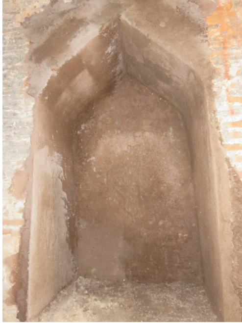
Fotoğraf 110: Ocak nişinin örülmesine dair fotoğraf
