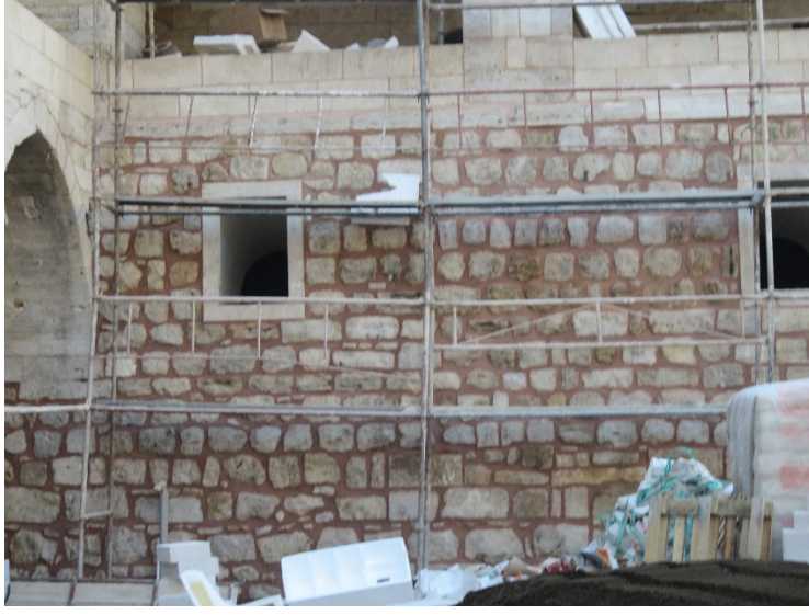
Fotoğraf 247: Ahır bölümünün iç avluya bakan yüzüne derz yapımı
