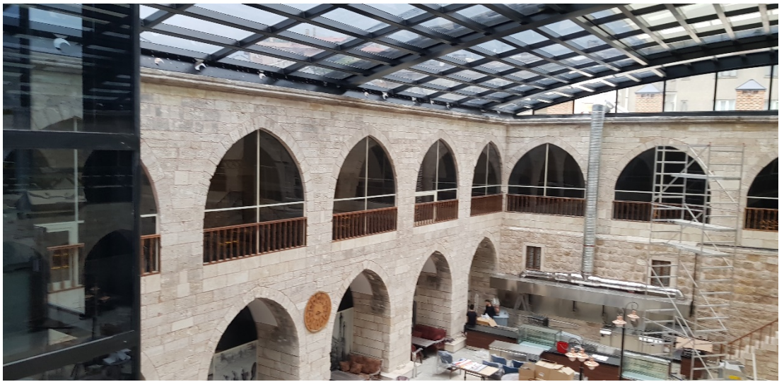
Fotoğraf 250: Ahşap korkuluk yapılması
