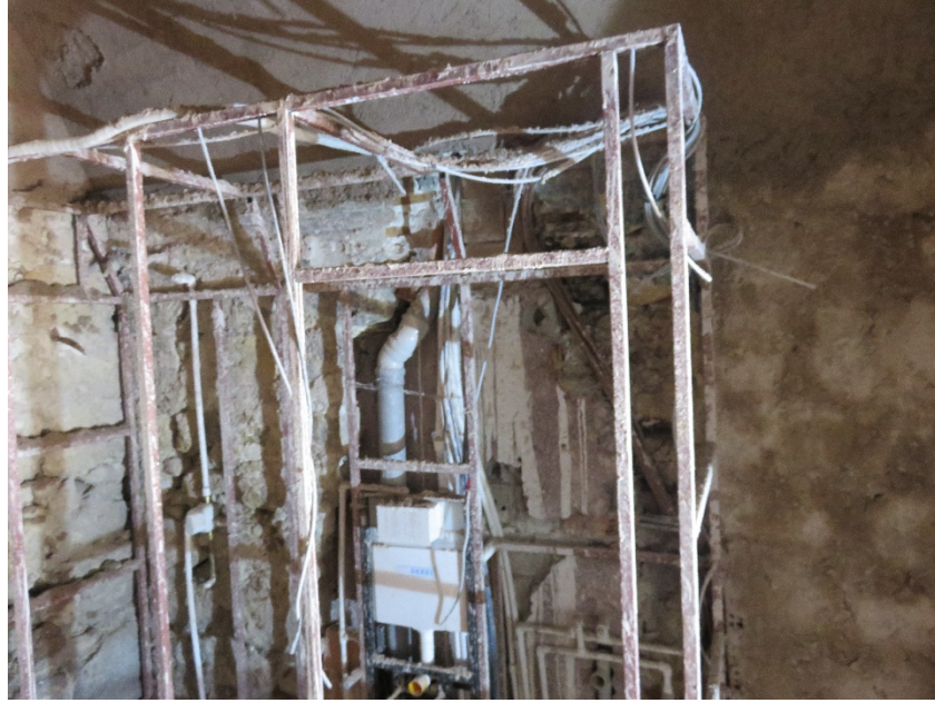
Fotoğraf 142: Baca boşluklarından tesisat borularının geçirilmesi
