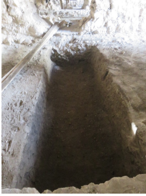
Fotoğraf 158: Zemin kat odalarda kanal açma ve tesisat borularını ekleme çalışmaları
