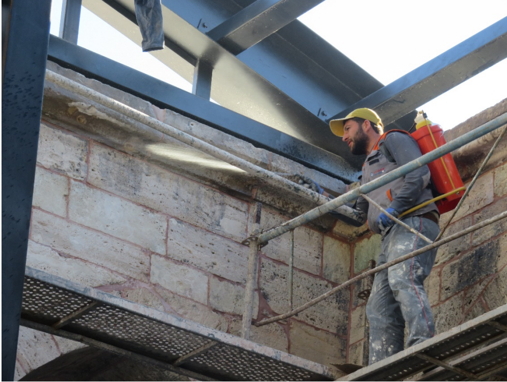
Fotoğraf 226: Arap sabunu ile cephe temizliđi uygulaması
