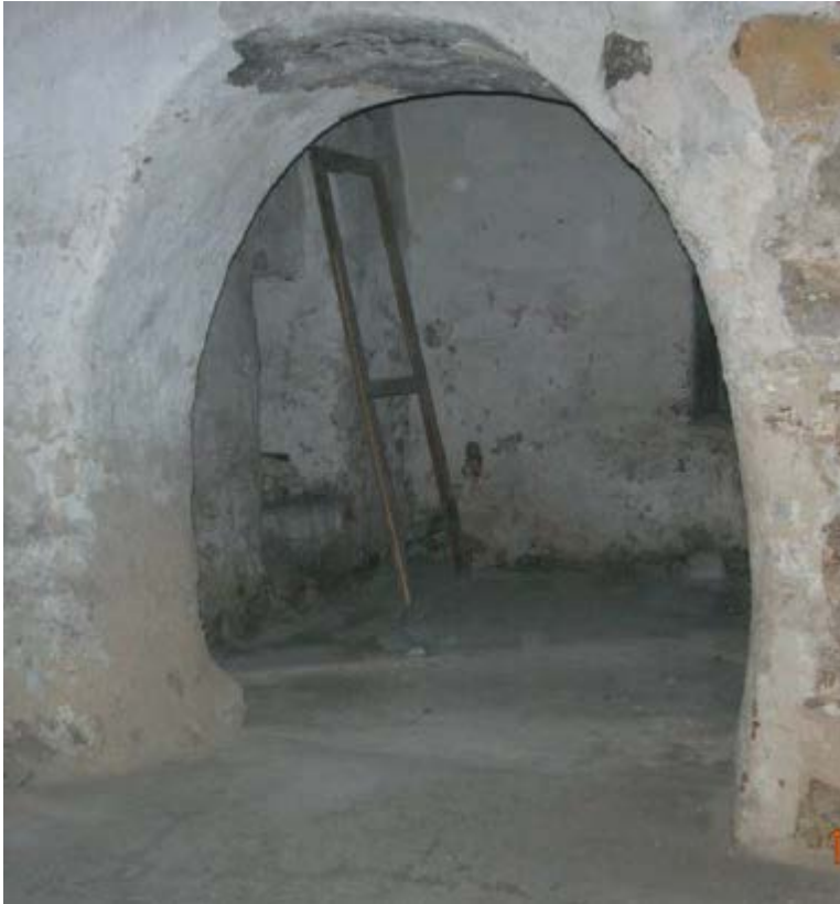
Fotoğraf 84: Zemin kat güneydoğu duvar diğer odaya kemerli geçiş
