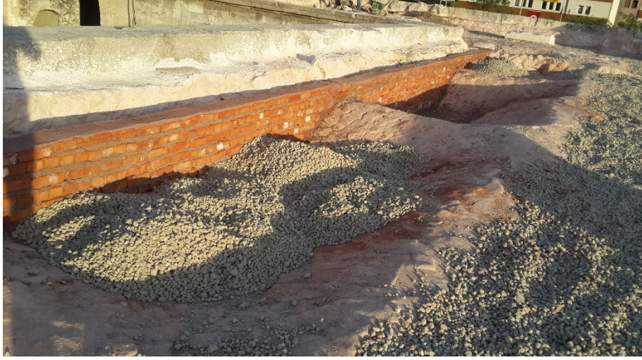
Fotoğraf 290: Harman tuğlasıyla örülen duvar, hatlın alt yapısı
