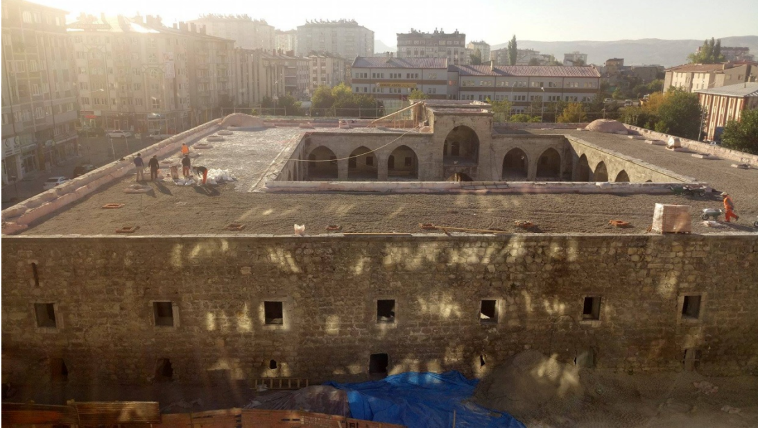
Fotoğraf 86: Örtüden toprak alma sırasında ortaya çıkan baca temelleri
