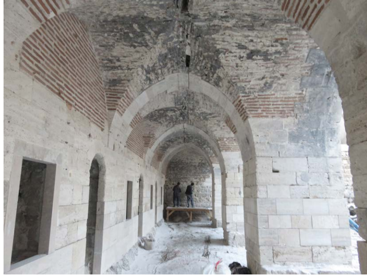
Fotoğraf 220: Kapı kemi ve revak kemi tamiratının yapılması
