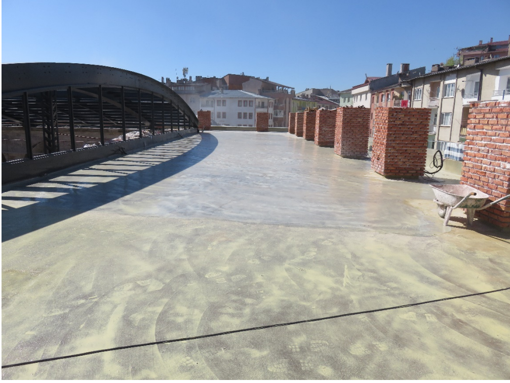
Fotoğraf 278: Örtü bölümü su yalıtım uygulaması
