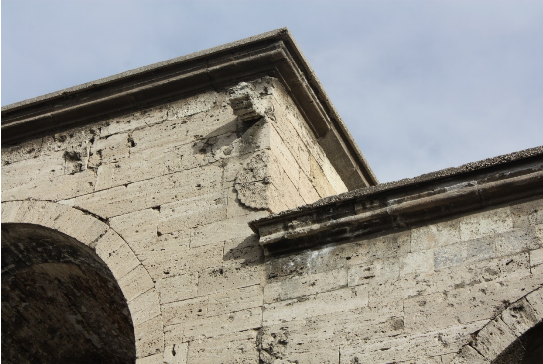
Fotoğraf 105: Behram Paşa Hanı güneydoğu avlu cephesindeki konsol detayı
