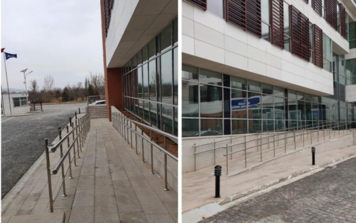
Şekil 2.2.8. Rampa –bina ana girişi-.
