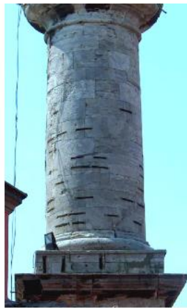
Şekil 1. Yığma sütunun kenet ile onarılması
