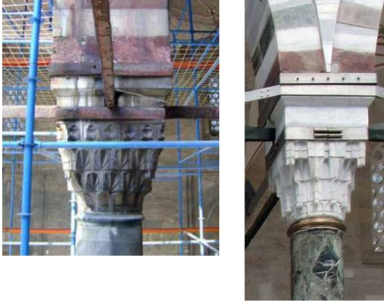
Şekil 2. Fatih Camisinde uygulanan paslanmaz çelikten sütun başlığı kuşaklama detayı
