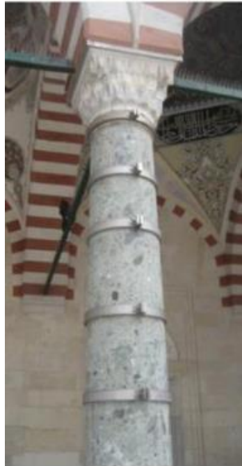
Şekil 6. Edirne Üç Şerefeli Camii sütunlarında uygulanan çemberleme uygulaması
