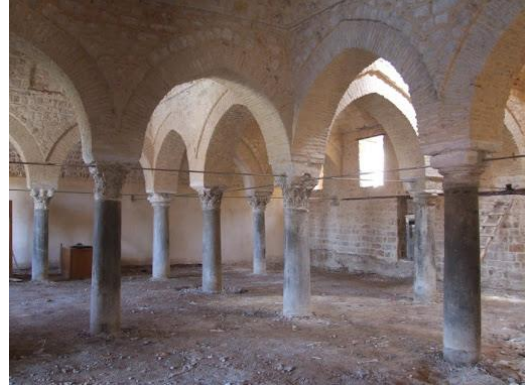
Şekil 5. Antalya Yivli Minare ve Camisinin sütunlarda yapılan güçlendirilme sistemleri (URL-1)
