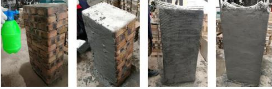
Şekil 8. Yığma sütunlarda yapılan güçlendirilme
