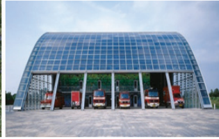
Şekil 5.11: İtfaiye istasyonu cephesinde fotovoltaik hücre uygulaması, Houten, Hollanda (Url-12).
