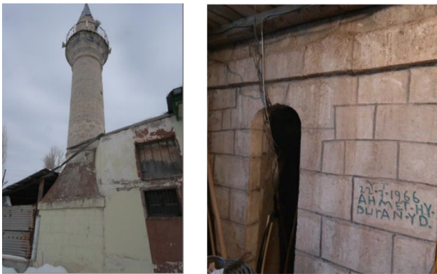
Fot. 2: Kuzeybatı, Minare, Genel Görünüm ve Minare Giriş Açıklığı
