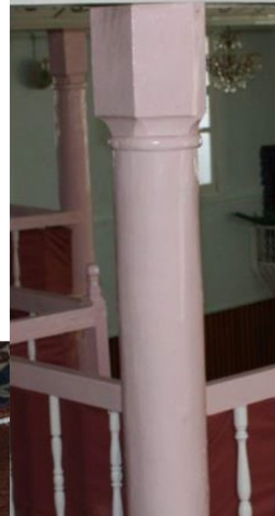
Fot. 5: Harimde Yer alan Ahşap Destekler, Sütun başlıkları ve Beton Kaide, Detay
