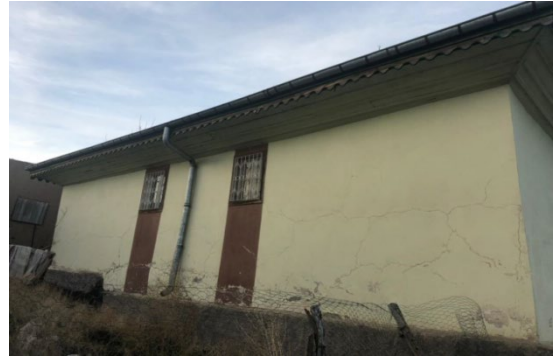
Fot. 16: Esenyurt Cami, Güney Cephe, Genel Görünüm
