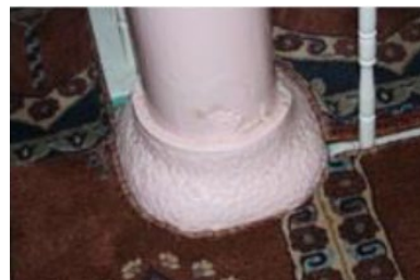
Fot. 5: Harimde Yer alan Ahşap Destekler, Sütun başlıkları ve Beton Kaide, Detay
