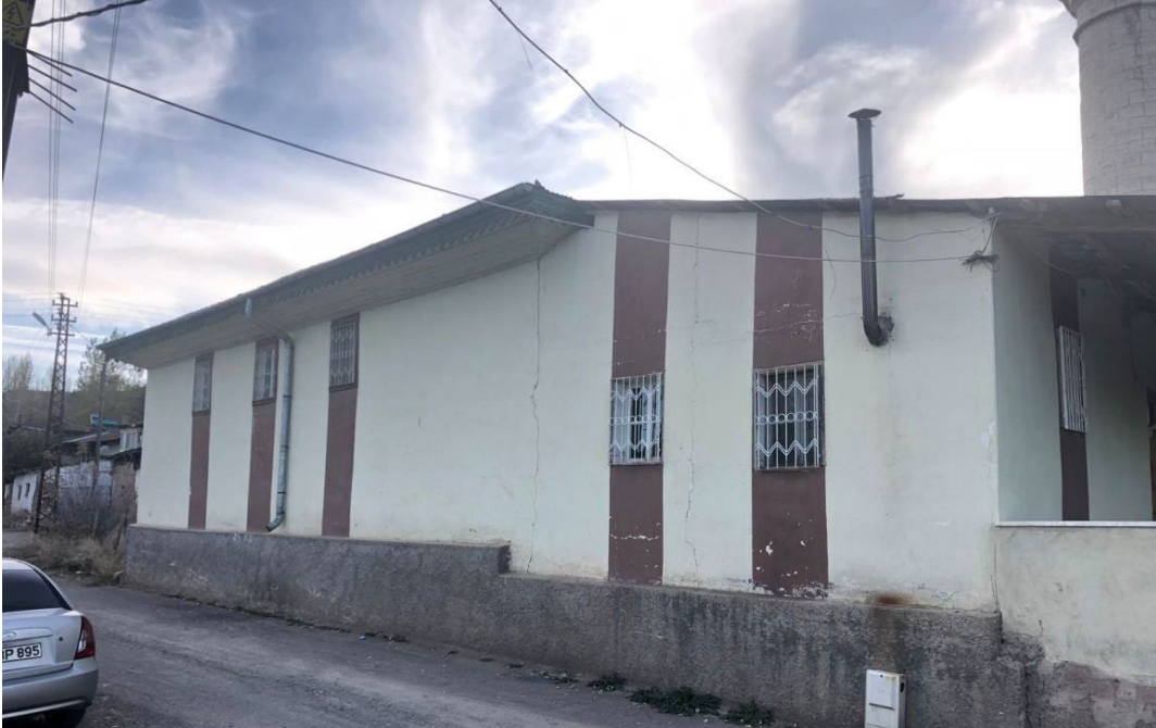
Fot. 19: : Esenyurt Cami, Doğu Cephe, Genel Görünüm
