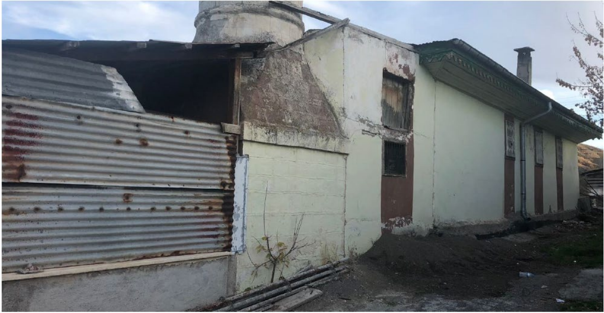
Fot. 17: : Esenyurt Cami, Batı Cephe, Genel Görünüm
