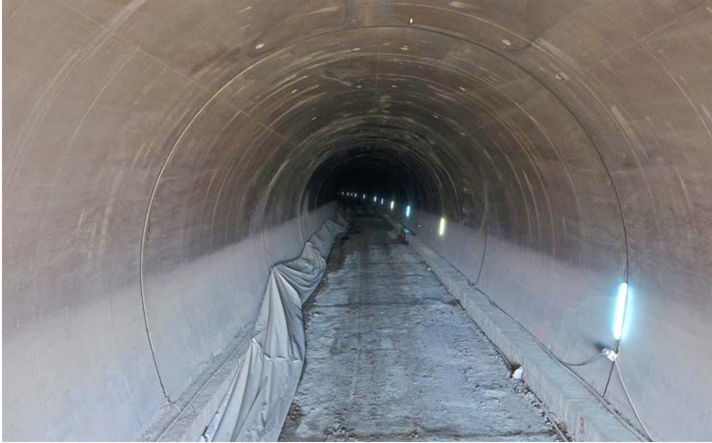
Hızlı Tren Alt Yapı Çalışması
