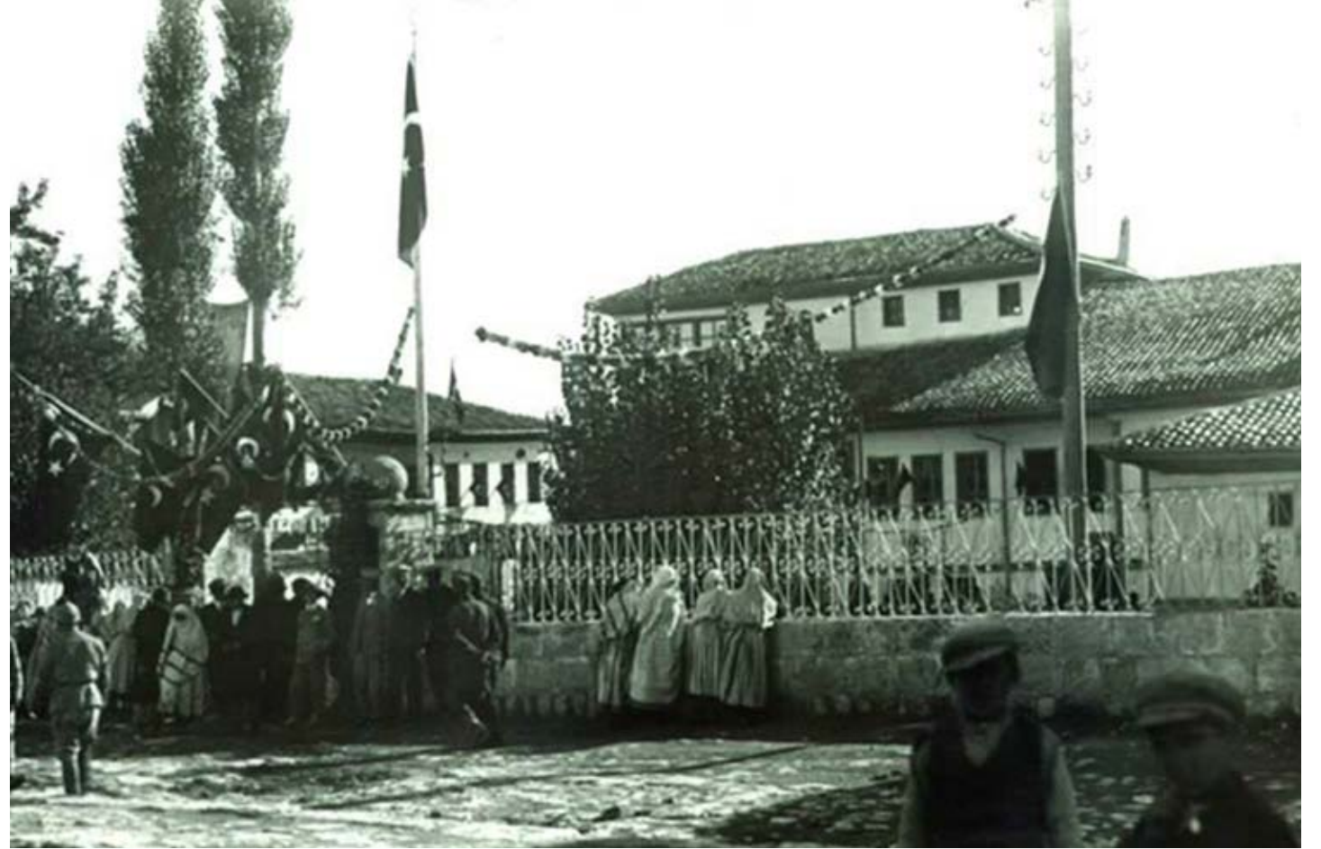
Sivas PTT Binası / 1930'lar
