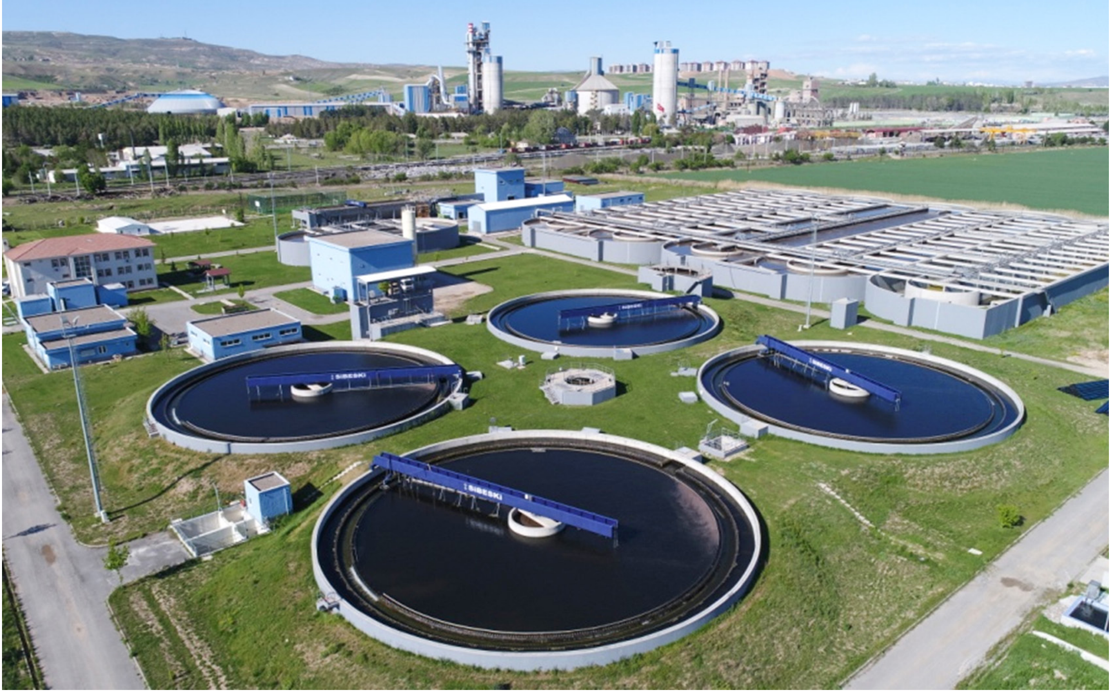
Sivas Atıksu Arıtma Tesisi
