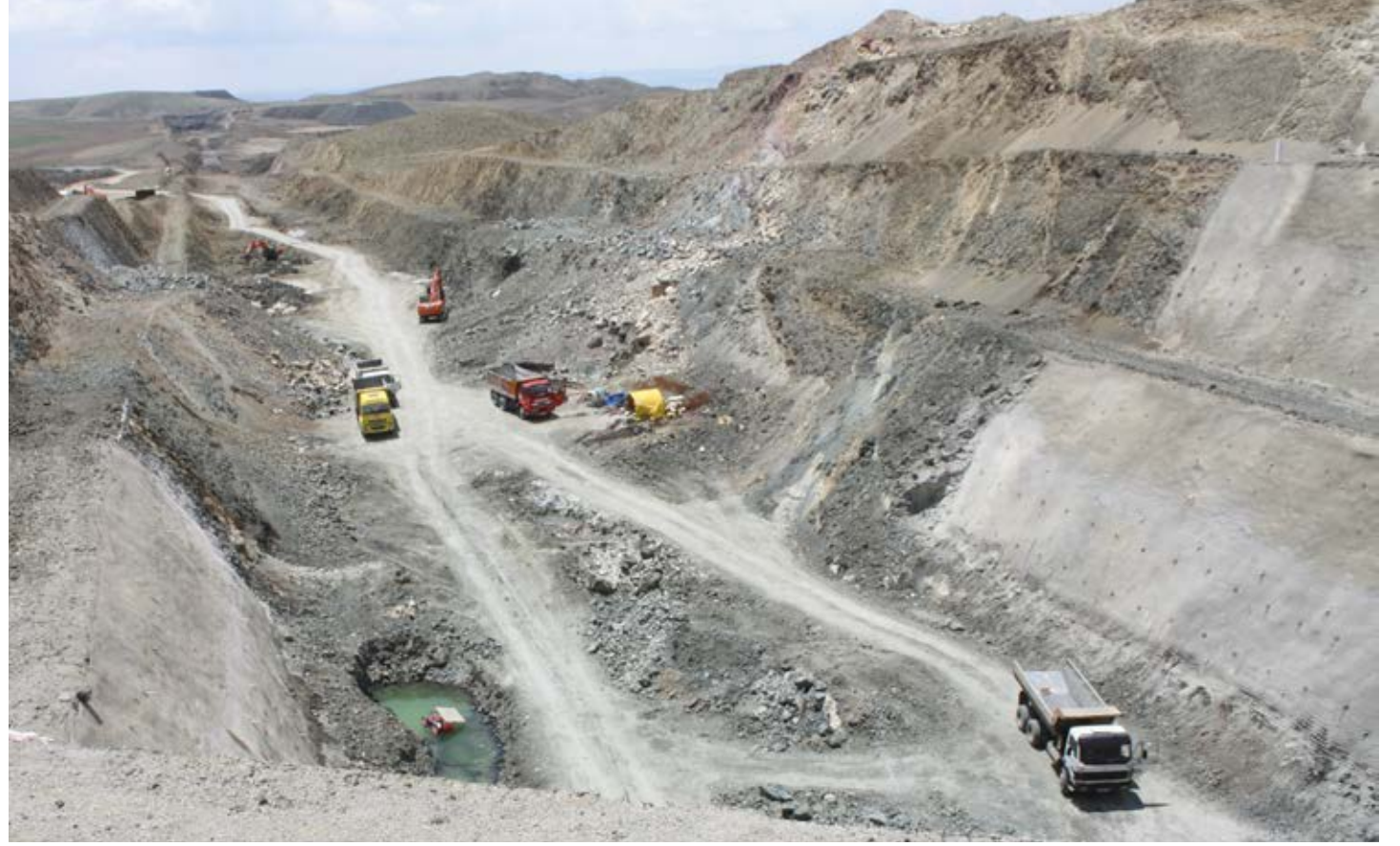
Hızlı Tren Alt Yapı Çalışması
