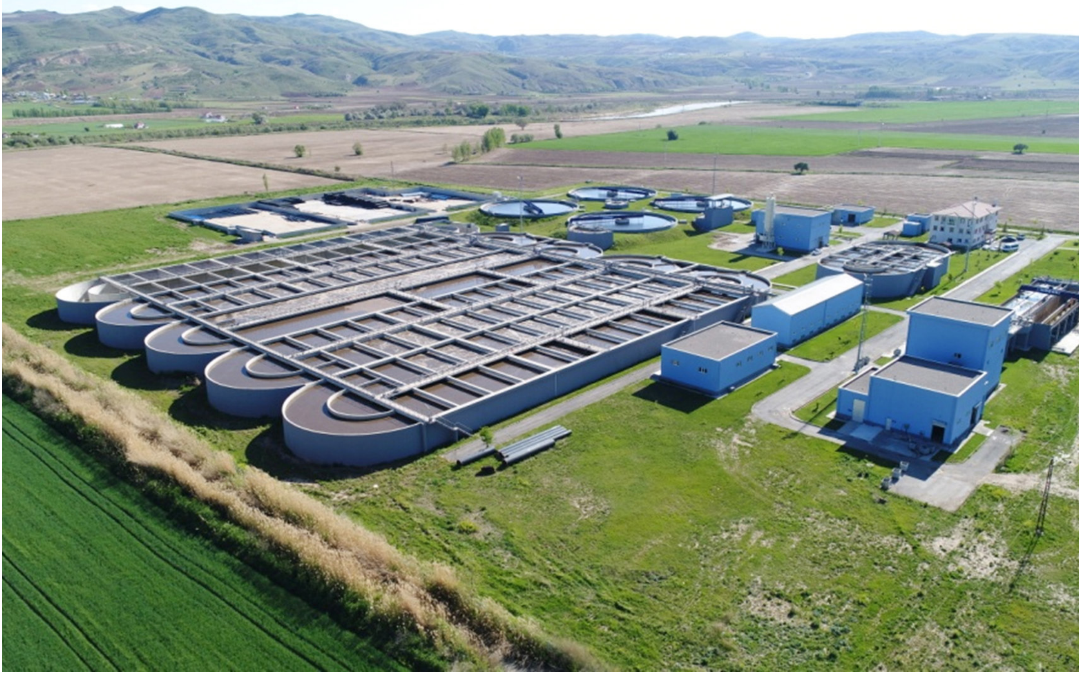
Sivas Atıksu Arıtma Tesisi
