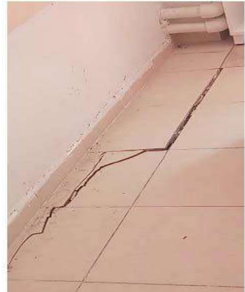
Şekil 2. Çalışma alanında görülen (a) Köşe Kolon altı yer hareketi (b) Seramik Kaplama Hasarı
