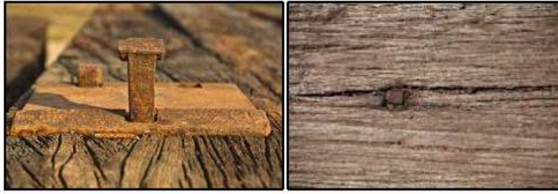
Şekil 9. Ahşap traverse bulon takviyesi
