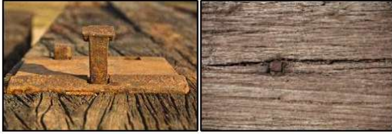
Şekil 9. Ahşap traverse bulon takviyesi
