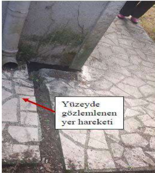
Şekil 2. Çalışma alanında görülen (a) Köşe Kolon altı yer hareketi (b) Seramik Kaplama Hasarı
